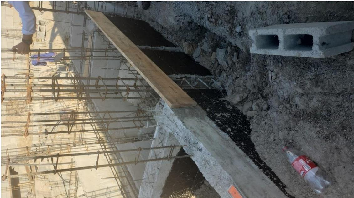
**Ilustración 54. Impermeabilizante en Zapatas**
