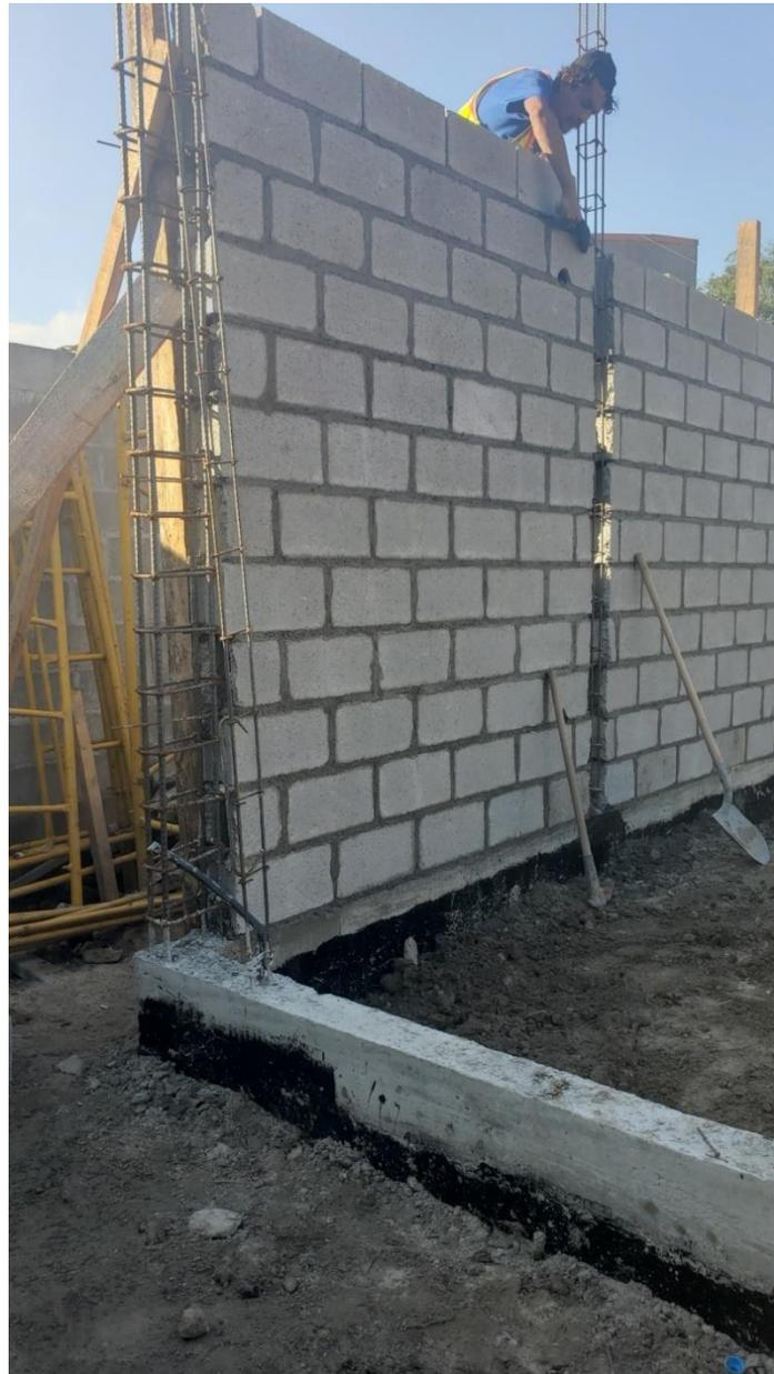
**Ilustración 55. Levantamiento de Muros**
