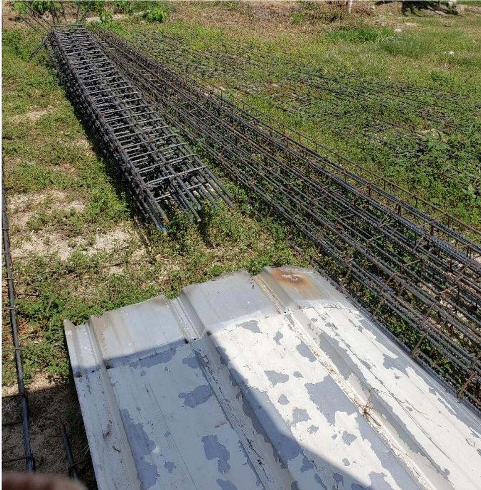
**Ilustración 42. Armado de Columnas y Castillos**
