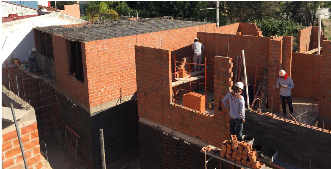
Ilustración 20. Sistema constructivo de ECA Townhouses.
