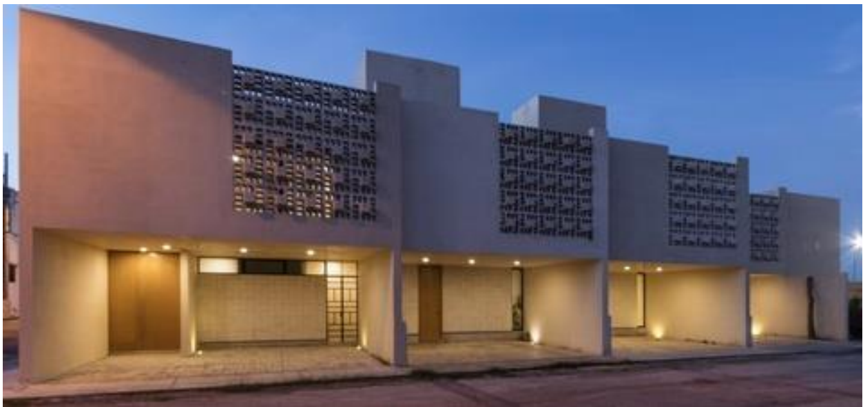
Ilustración 33. Fachada frontal y empleo de materiales de concreto.
