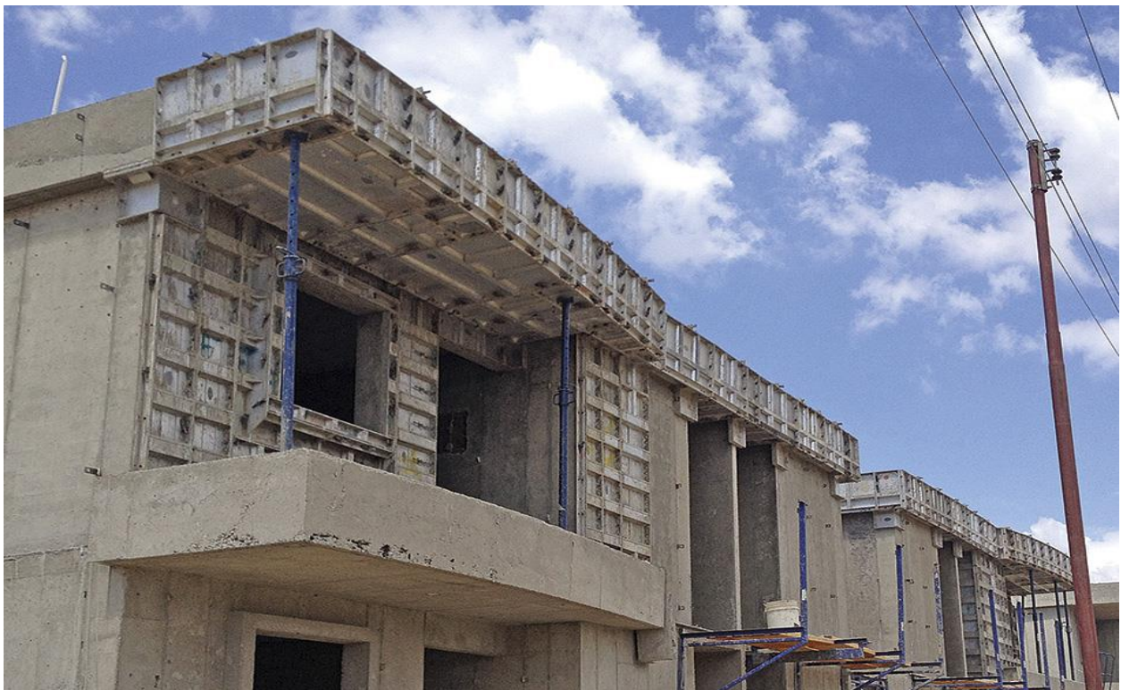
Ilustración 12. Sistema industrializado de muros de concreto.
