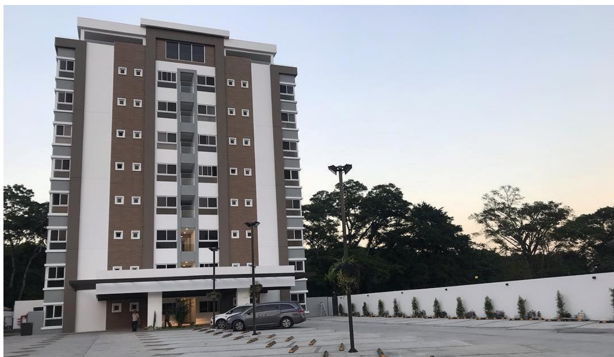
Ilustración 4. Torre Fontana de la Arboleda.
