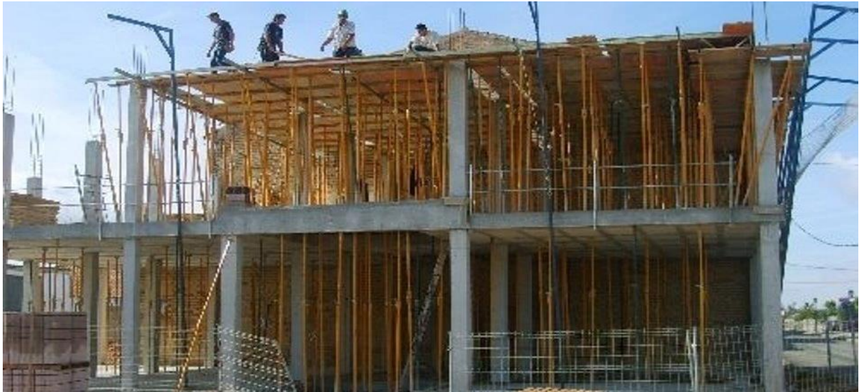
Ilustración 10. Sistema convencional adintelado con cerramiento de bloque.
