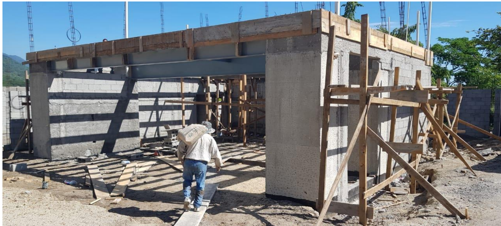
Ilustración 54. Construcción de vivienda en residencial Pedregal.
