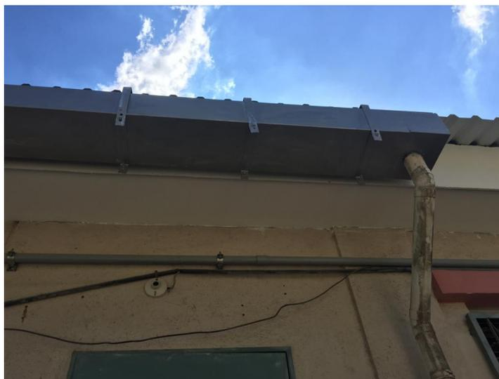
**Ilustración 101. Pintura en canales de aguas lluvia**
