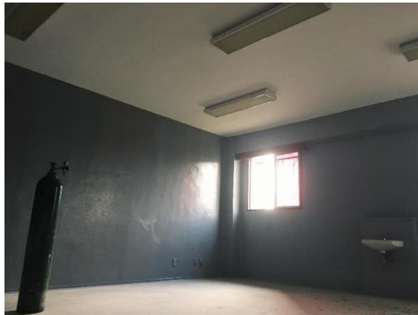
**Ilustración 86. Esmalte epóxico en sala de parto, etapa 1**
