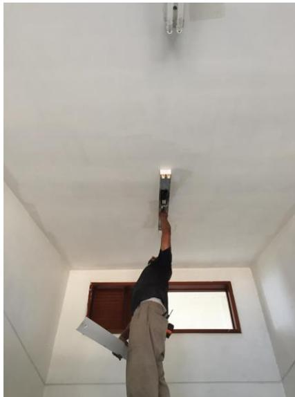
**Ilustración 90. Instalación de luminarias, etapa 2**
