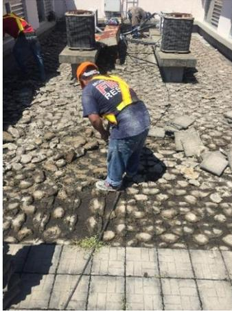
**Ilustración 68. Remoción de capa de mortero y baldosas de concreto**
