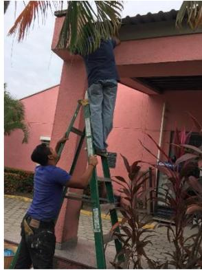
**Ilustración 145. Instalación de lámina de densglass**
