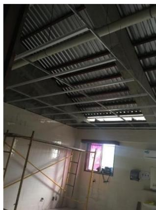
**Ilustración 72. Instalación de estructura de cielo falso en área de quirófano B-1**
