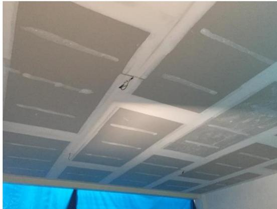
**Ilustración 95. Instalación de cielo falso área de enfermería**
