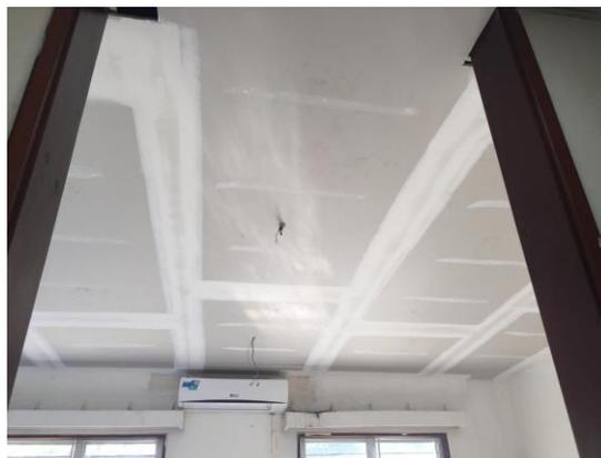
**Ilustración 96. Instalación de cielo falso en área de parto etapa #1ª**
