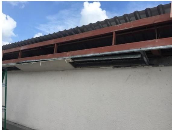
**Ilustración 81. Desmontaje de panelit en cenefa**
