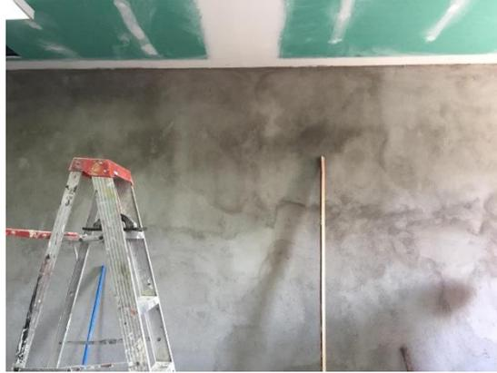
**Ilustración 80. Repello y pulido en paredes de quirófano**
