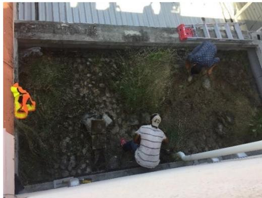
**Ilustración 69. Remoción de capa vegetal en losa**
