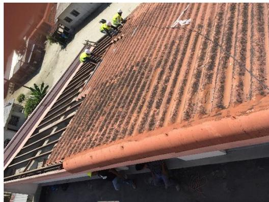
**Ilustración 70. Desmontaje de lámina de asbesto en techo**
