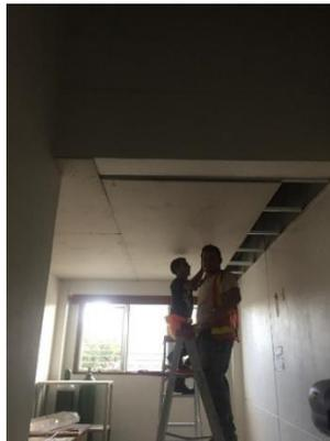
**Ilustración 71. Instalación de tabla yeso mineral en sala A-1**
