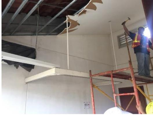
**Ilustración 65. Desmontaje de cielo falso en B-1**
