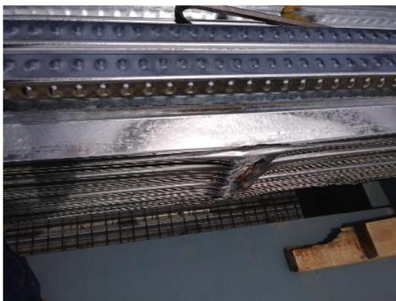
**Ilustración 98 Las láminas se endereza in situ.**
