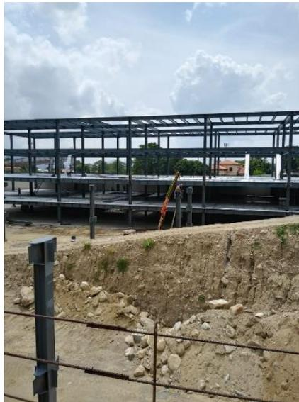
**Ilustración 96 Montaje de columnas mediante el uso de grúa.**
