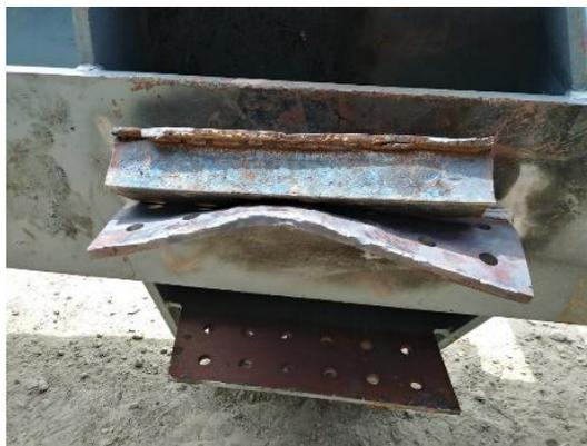
**Ilustración 97 Los herreros están enderezando las vigas para su posterior montaje.**
