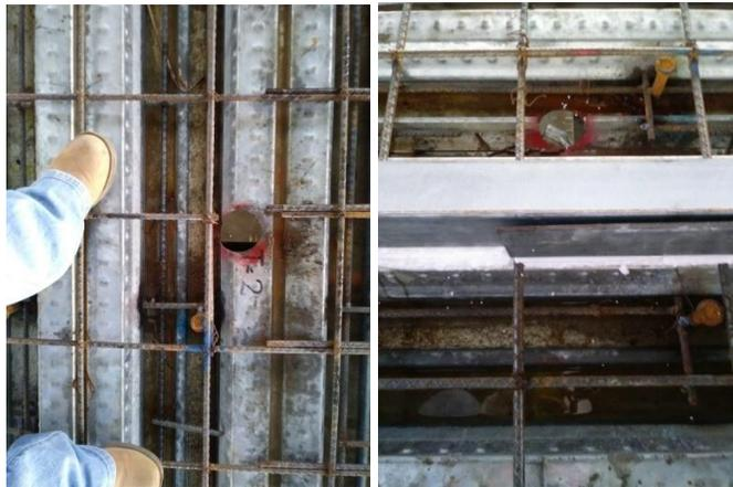
**Ilustración 111 Perforación de boquete para bajantes de instalaciones hidrosanitarias.**
