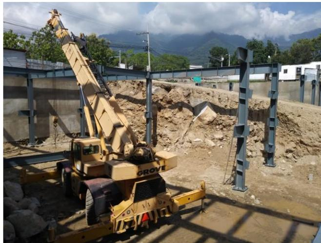
**Ilustración 117 Se colocaron vigas para el cerramiento de estructuras en el área de estacionamiento.**
