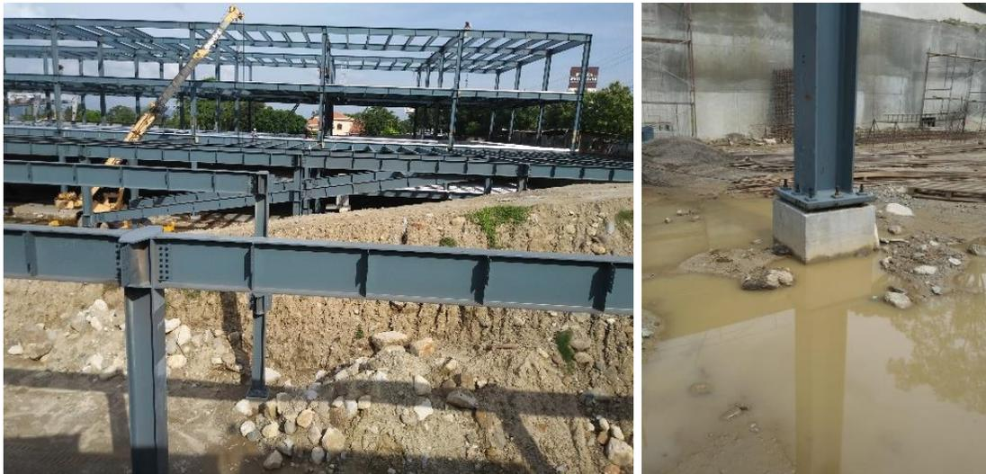
**Ilustración 123 Vista a colocación vigas en Nivel +00.**
