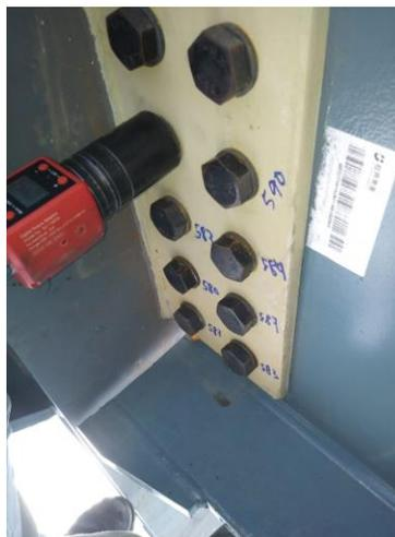
**Ilustración 77 Verificación de pernos en tercer nivel. Edificio 2.**
