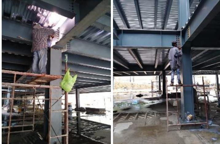
**Ilustración 101 A la izquierda soldador reforzando la estructura y a la derecha un operador pintando la columna (ambos en nivel -8.00 metros).**
