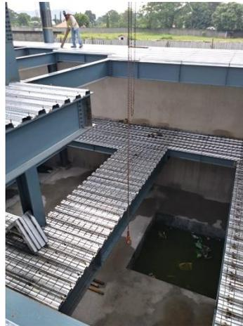
**Ilustración 103 Se usa tecla para subir equipo de trabajo al siguiente nivel.**
