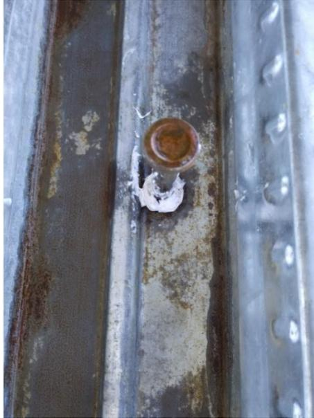
**Ilustración 87 Colocación de silicona en pernos de láminas de aluzinc.**
