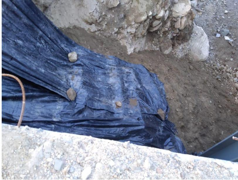
**Ilustración 143 Se dejó cubierto el material selecto que se metió**
