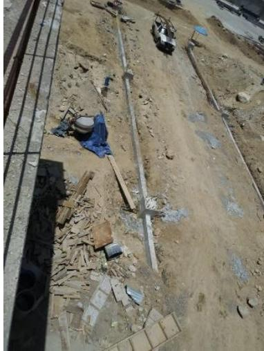
**Ilustración 92 Vigas tensoras acabadas.**
