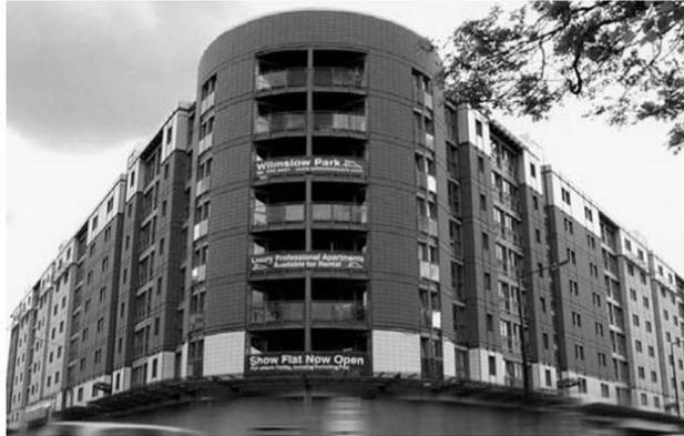
**Ilustración 18 Módulos en LSF conforman este edificio en Inglaterra.**
