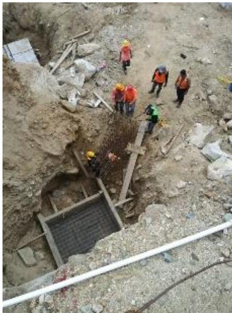
**Ilustración 88 Armado de zapata.**
