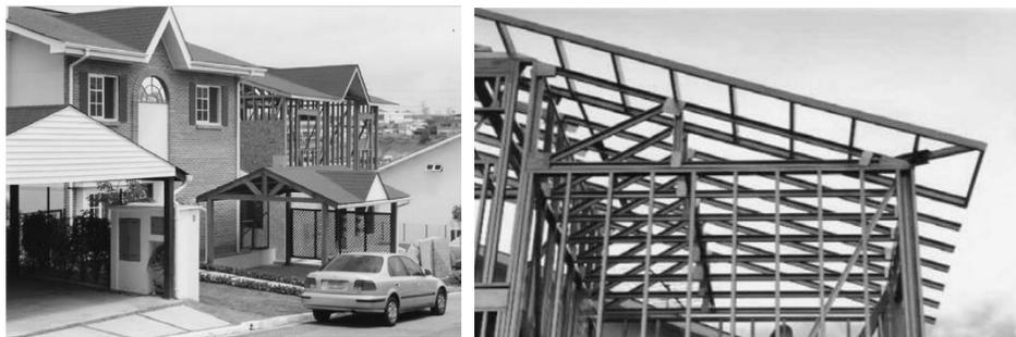
**Ilustración 14 A la izquierda residencias construidas con el sistema Light Steel Framing en San Paolo, Brasil y a la derecha estructura del tejado de una vivienda Steel framing.**
