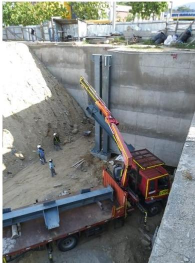
**Ilustración 93 Montaje de estructuras metálicas.**
