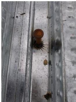
**Ilustración 100 Perno que quedó con un ángulo de inclinación.**
