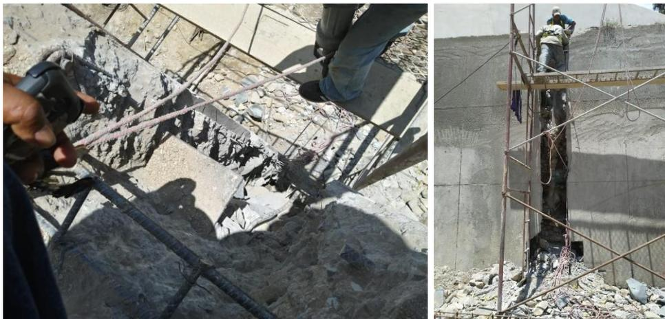
**Ilustración 132 Picado de muro para inserción de columna.**
