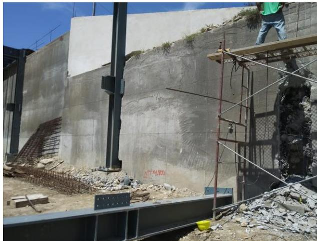
**Ilustración 136 Vista de las perforaciones en el muro de contención.**
