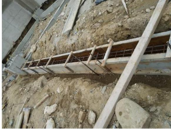
**Ilustración 89 Inspección de encofrados de vigas tensoras.**
