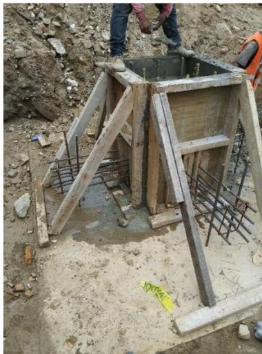
**Ilustración 86 Supervisión de correcto vibrado en pedestal.**
