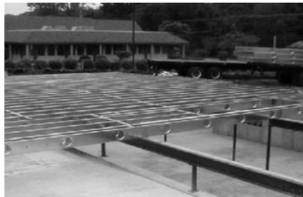
**Ilustración 55 Vigas de entrepiso apoyadas sobre la viga principal de a acero.**
