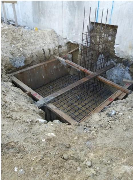
**Ilustración 81 Supervisión de fundición de zapata.**
