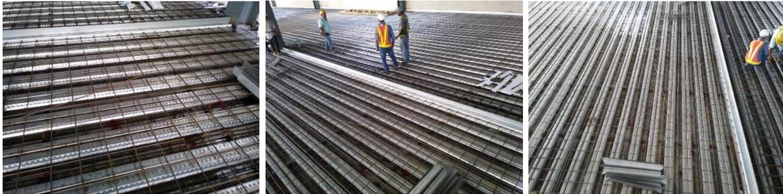
**Ilustración 112 Con perfilería metálica se divide la sección de losa que se va a fundir.**
