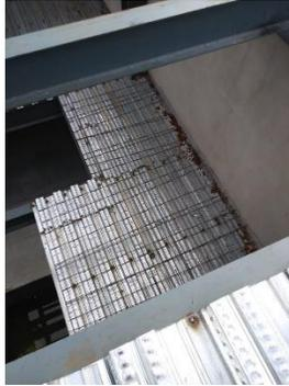
**Ilustración 99 Láminas dañadas.**
