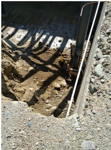
**Ilustración 140 Conformación de la rampa debido a la lluvia ocurrida a inicio de la semana, para ello se protegió el pedestal de las columnas continuas a dicha rampa.**
