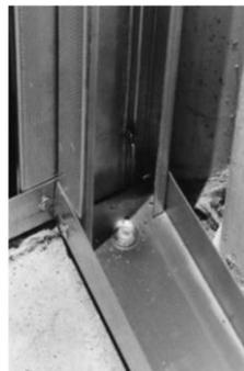
**Ilustración 25 Anclaje provisorio.**
