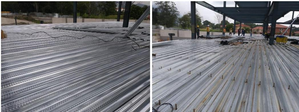
**Ilustración 102 A la izquierda el nivel + 5.00 y a la derecha el nivel 00 donde ya se puede observar el laminas peroadas.**
