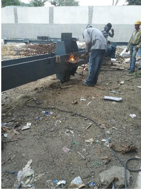
**Ilustración 94 Rectificación de aletas de columnas.**
