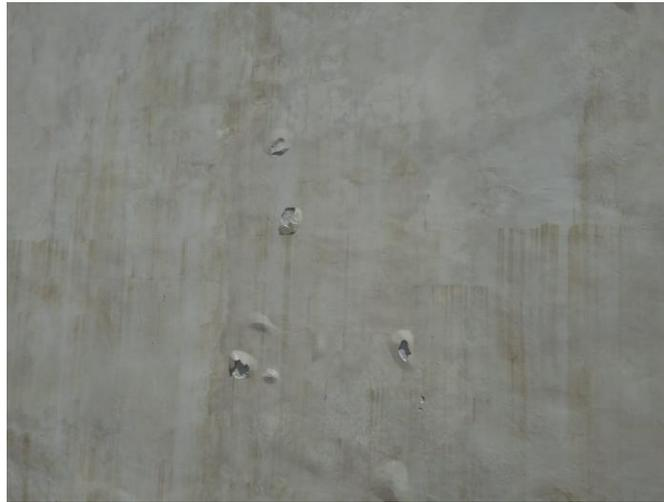
**Ilustración 137 Filtraciones en el muro de micropilotes construido por Geotécnica.**
