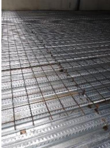
**Ilustración 91 Armados de losa de entrepiso.**
