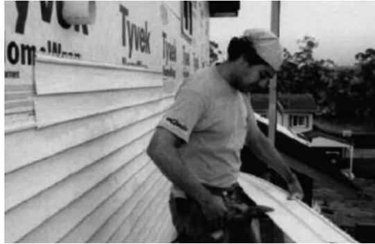
**Ilustración 59 Instalación de siding vinílico.**
