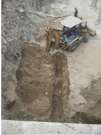
**Ilustración 78 Excavación para vigas tensoras.**
