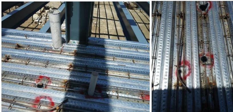
**Ilustración 135 Orificios en láminas de Aluzinc.**
