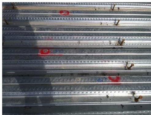
**Ilustración 104 Marcaje para abertura en lámina de Aluzinc.**
