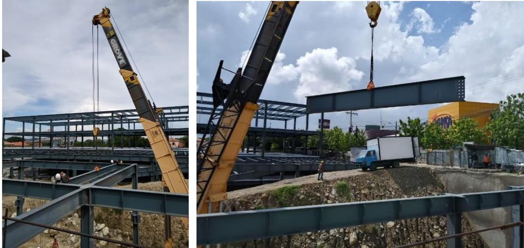
**Ilustración 128 Montaje de vigas primarias y secundarias, en Control de montaje de estructuras.**
