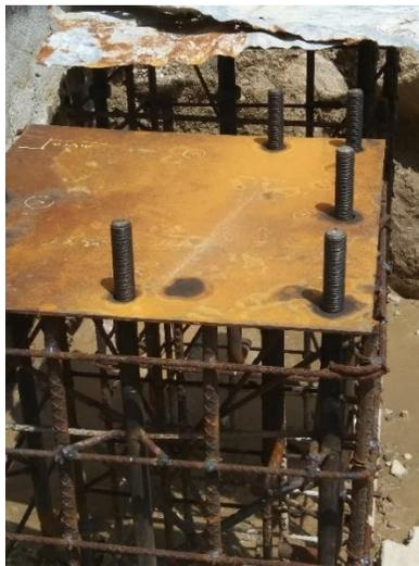
**Ilustración 74 Placas de un pedestal.**
