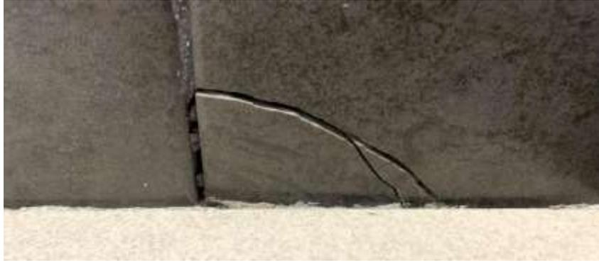
**Ilustración 87. Fisura en Recubrimiento de Columna**
