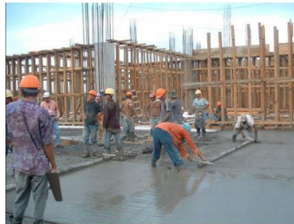
Ilustración 9. Realización de proyecto arquitectónico utilizando hormigón pulido.
