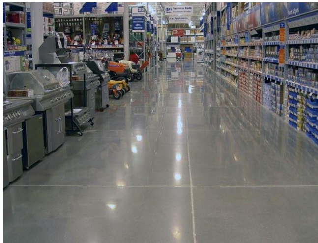
Ilustración. Fotografía interior de hormigón pulido
