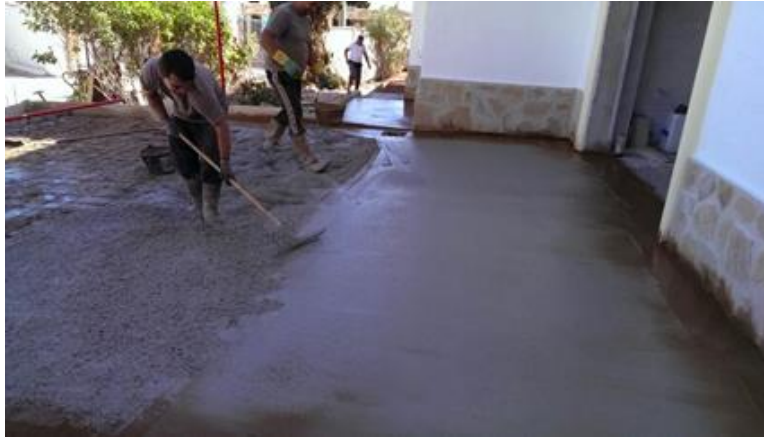
Ilustración 4. Aplicación de hormigón pulido.
