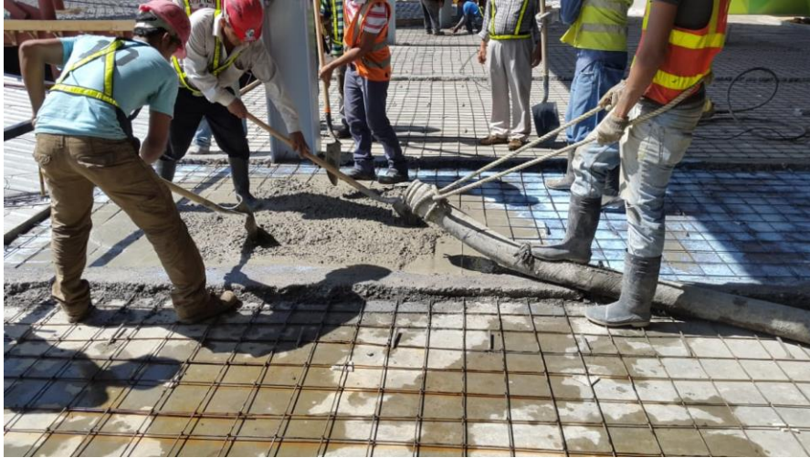
Ilustración 60. Preparación de fundido de losa, S.P.S.
