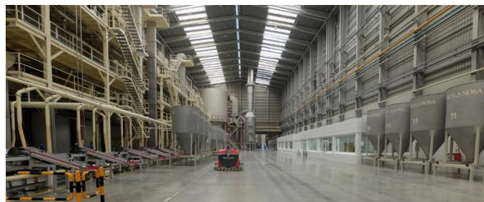
Ilustración 10. Realización de proyecto arquitectónico utilizando hormigón pulido.
