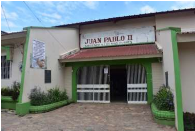
Ilustración 95. Fachada principal Clínica Municipal de Maternidad Juan Pablo II
