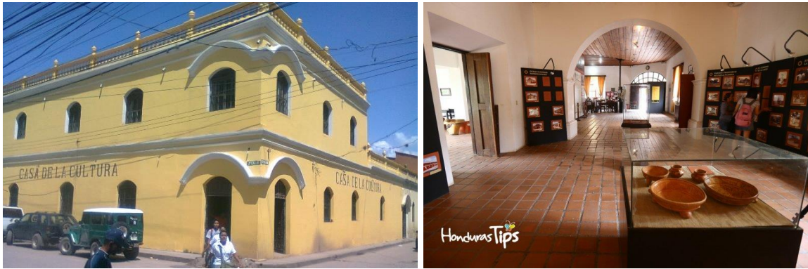
Ilustración 8 Casa de la Cultura de Juticalpa, fachada y vista interior.
