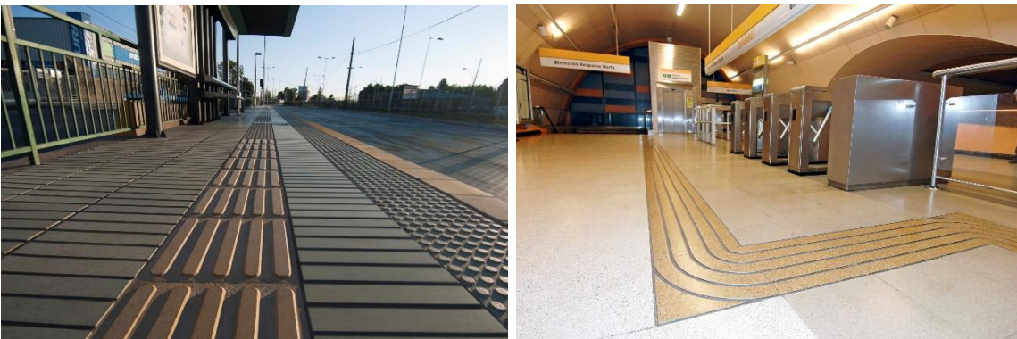
Ilustración 60 Señalización: baldosas con relieve o podotáctiles para circuitos no videntes.
