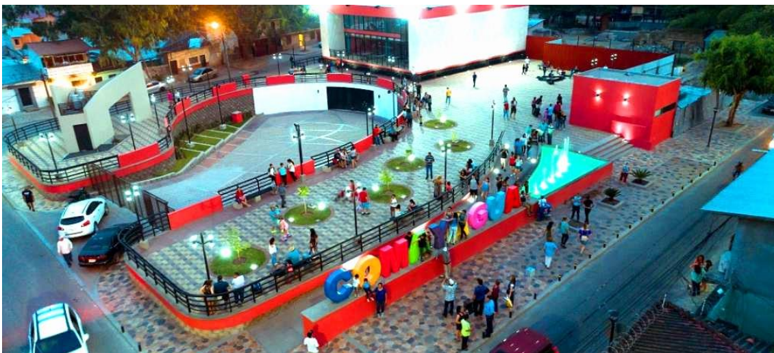
Ilustración 34 Vista aérea de conjunto del Centro de la Juventud de Comayagua, Honduras.
