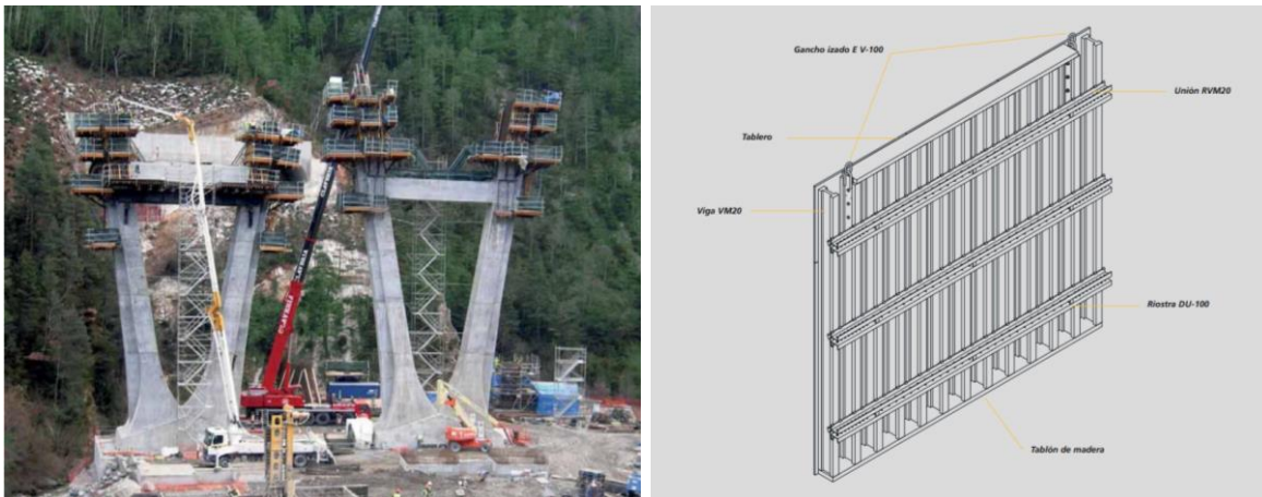
Ilustración 102 Muestra de sistema de encofrado con paneles metálicos, que permiten flexibilidad en geometría.
