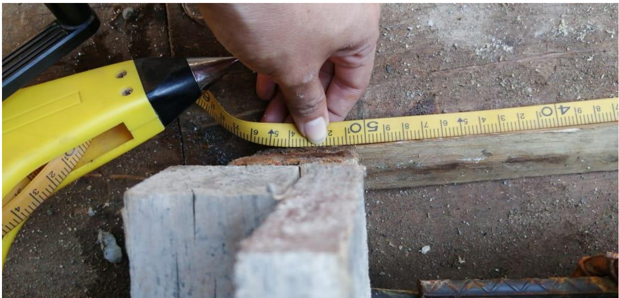
Ilustración 16. Supervisión de claro de la viga
