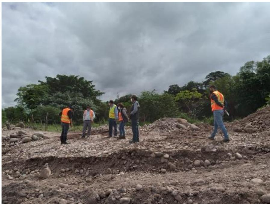
*Ilustración 13-Mala conformación de Taludes*
