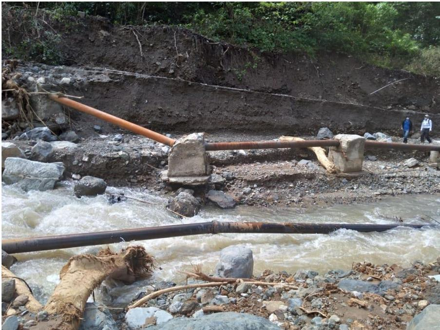
*Ilustración 6-Líneas de Conducción Agua Dañadas*
