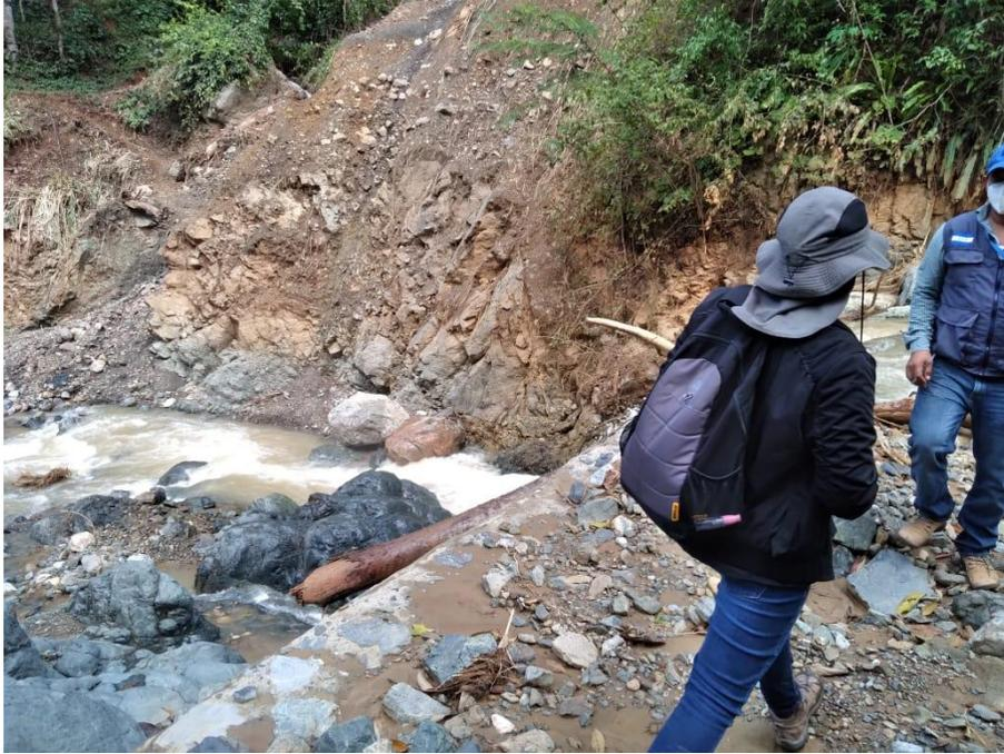
*Ilustración 5-Presa llena de material aluvial*
