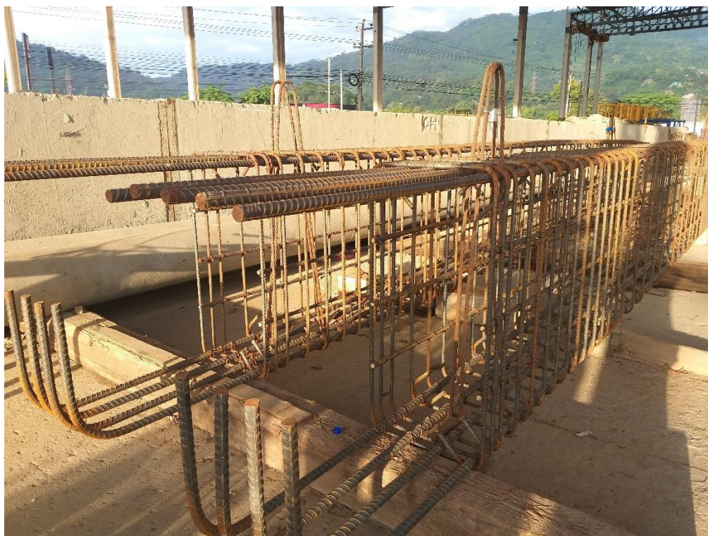
Ilustración 18 Armado de Vigas LB-1
