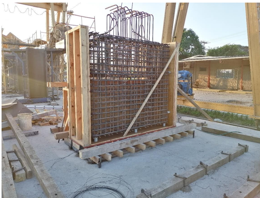
Ilustración 31 Armado de Viga FB colocado en encofrado
