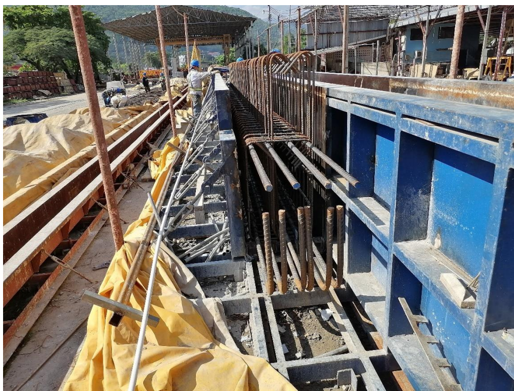
Ilustración 19 Armado de Viga LB-6 colocado en molde
