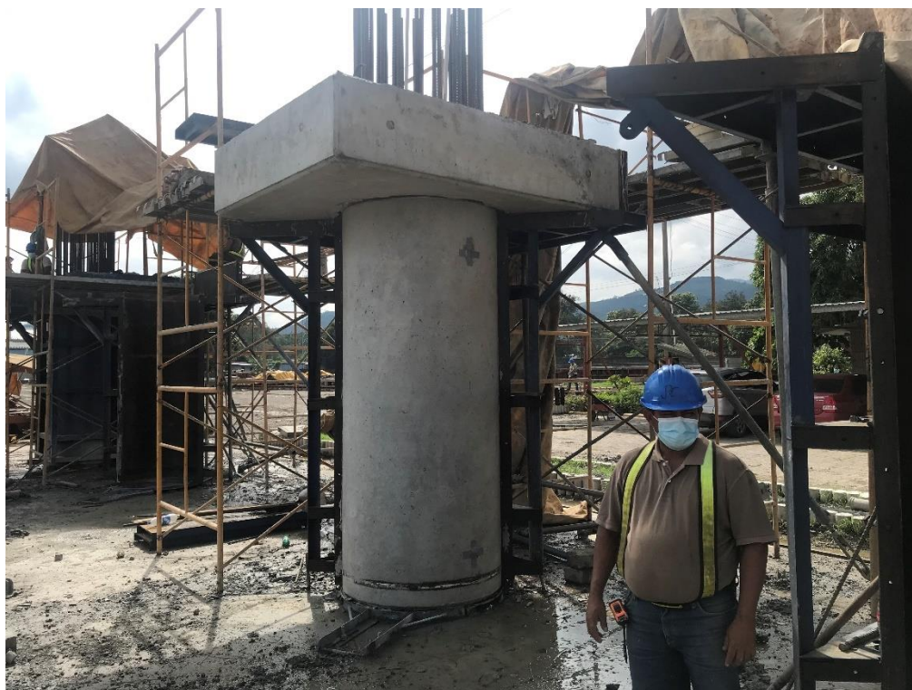
Ilustración 46 Desmolde de Capiteles
