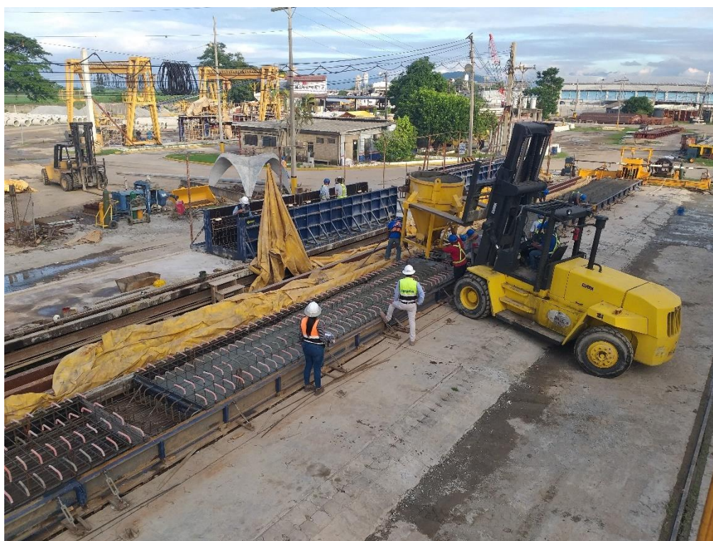
Ilustración 11 Colado de Losas DP
