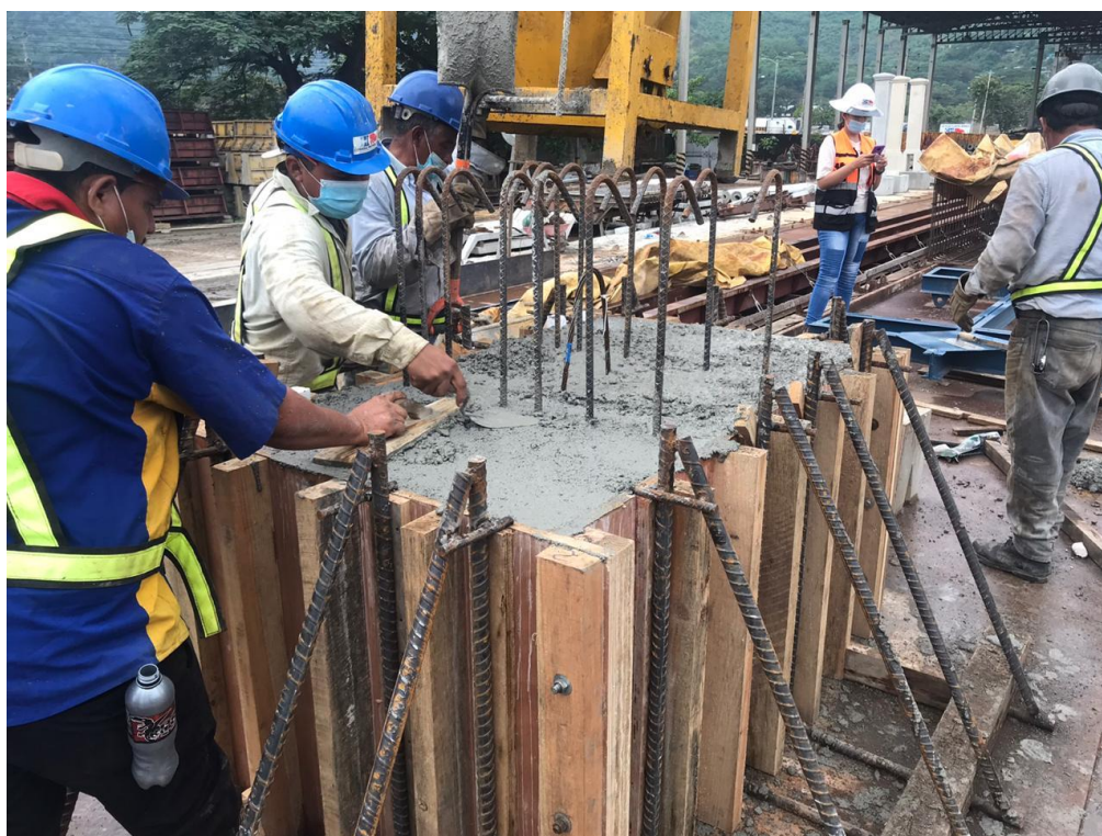
Ilustración 27 Acabado de Viga CB-1
