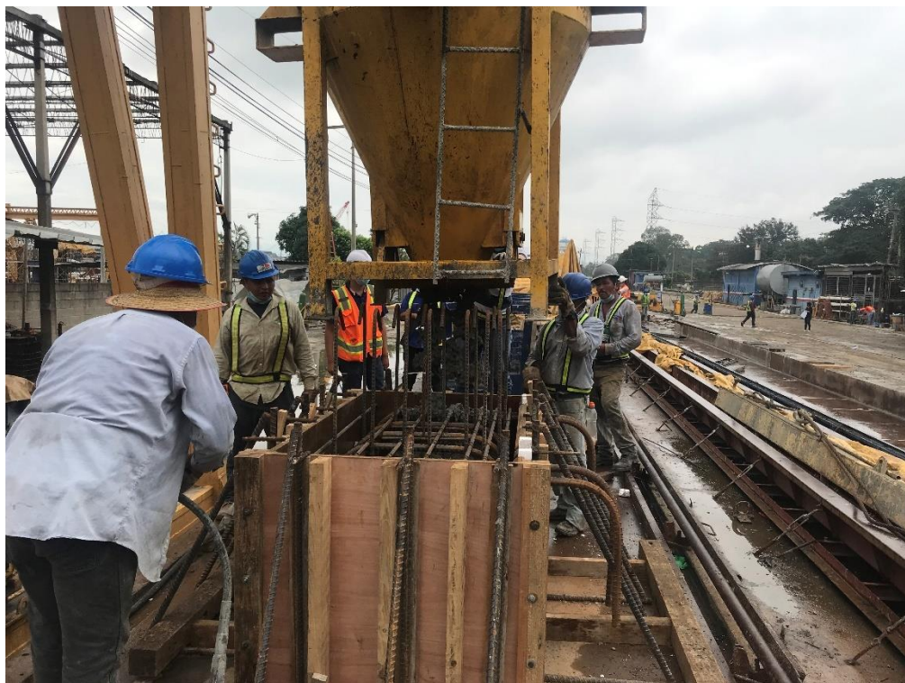
Ilustración 26 Colado de Viga CB-1
