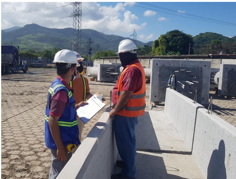
Ilustración 37 Realización de Posinspección Vigas U
