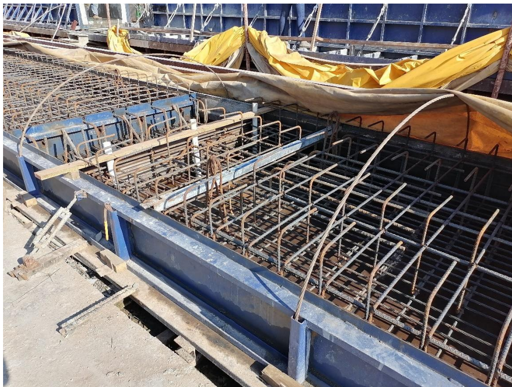
Ilustración 10 Anillos de Losas DP
