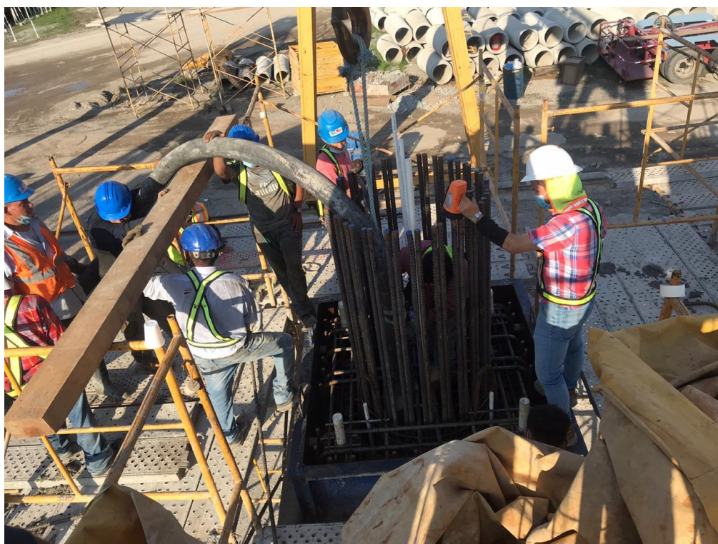
Ilustración 41 Colado de Capiteles con bomba.
