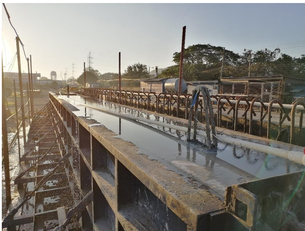
Ilustración 21 Curado de vigas en sitio
