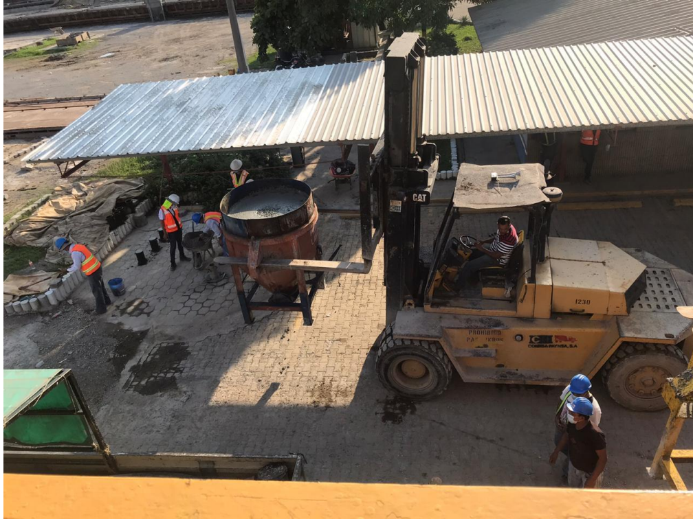
Ilustración 42 Llegada del Cubilete al sitio de colado de capiteles
