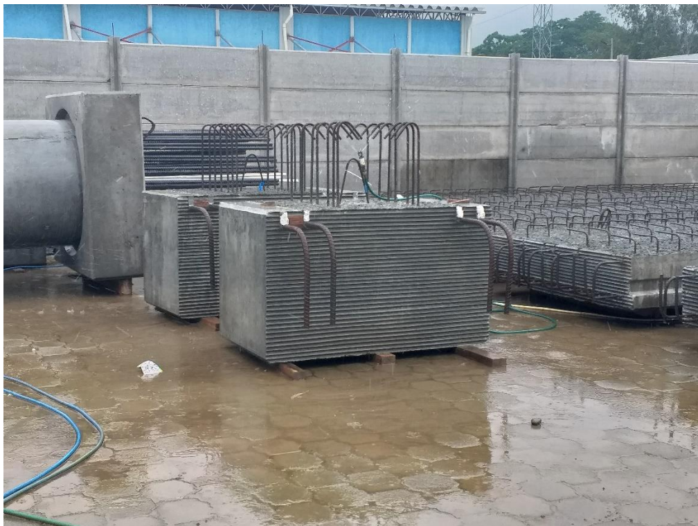
Ilustración 29 Curado de Vigas CB-1 en patio de curado
