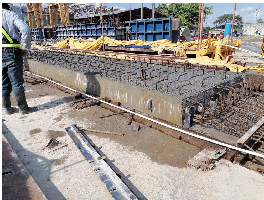
Ilustración 15 Desmolde de Losas
