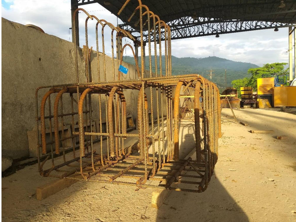
Ilustración 24 Armado de Viga CB-1
