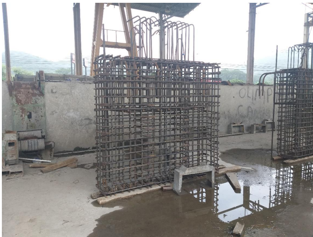
Ilustración 30 Armado de Viga de Defensa FB-1
