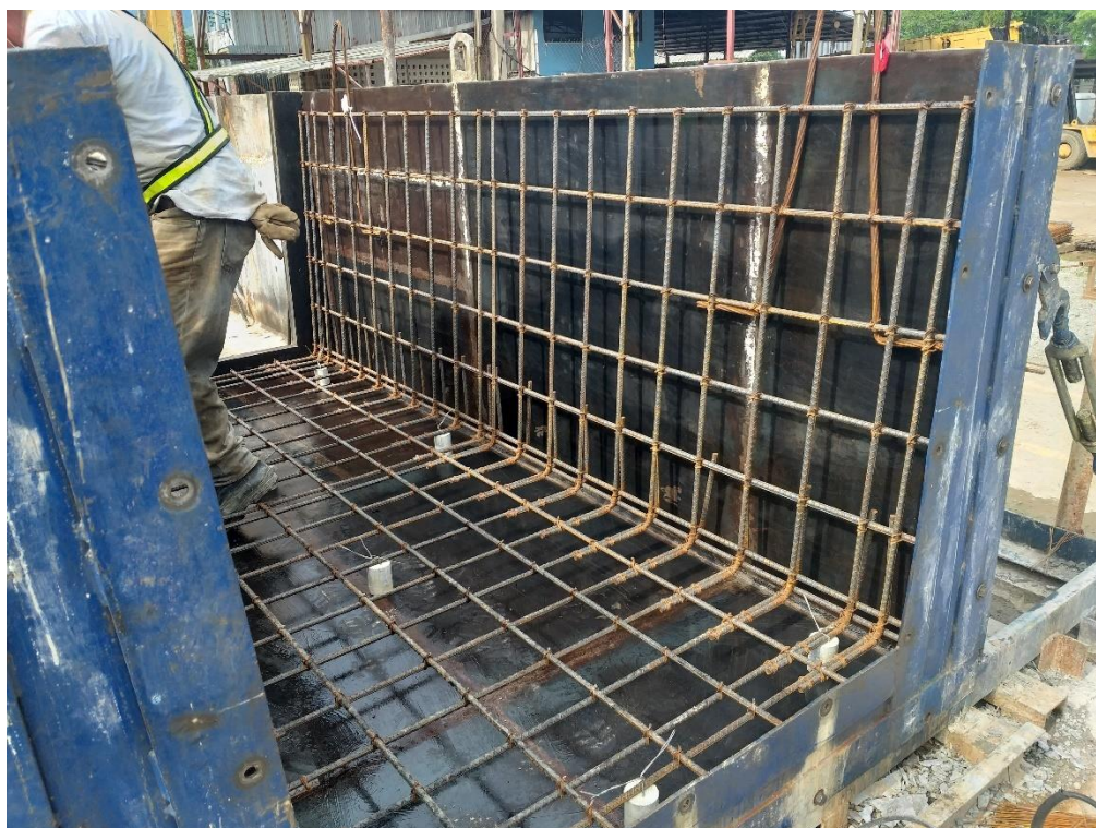
Ilustración 32 Armado de vigas UB-1
