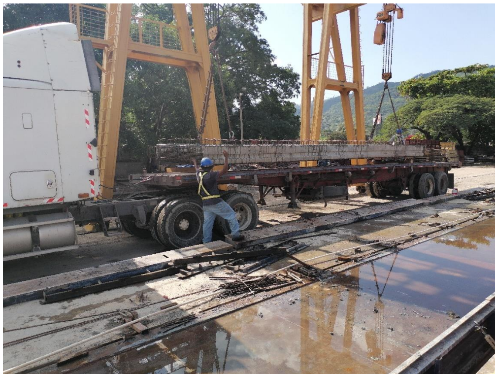
Ilustración 16 Transporte de losas a patio de curado
