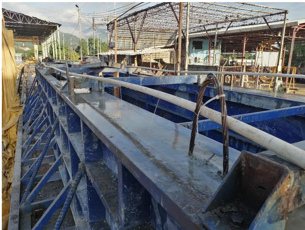
Ilustración 34 Curado de Vigas U en sitio
