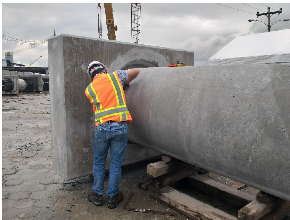
Ilustración 47 Realización de Posinspección de Capiteles
