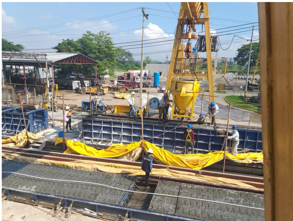
Ilustración 20 Colado de Vigas
