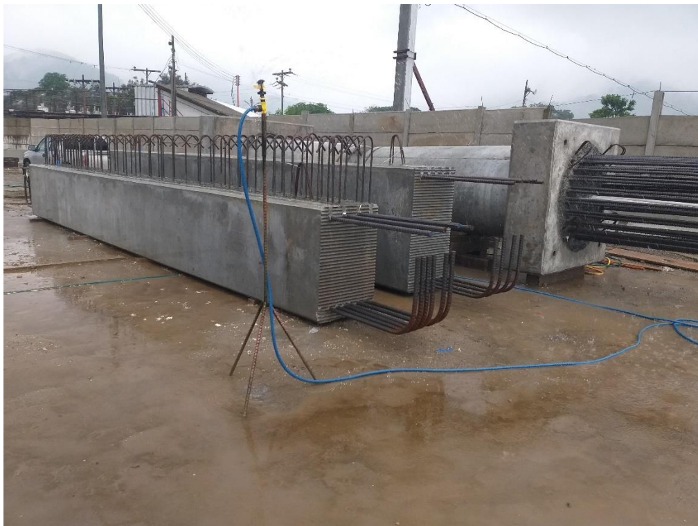
Ilustración 23 Viga LB-6 y LB-1 en patio de curado
