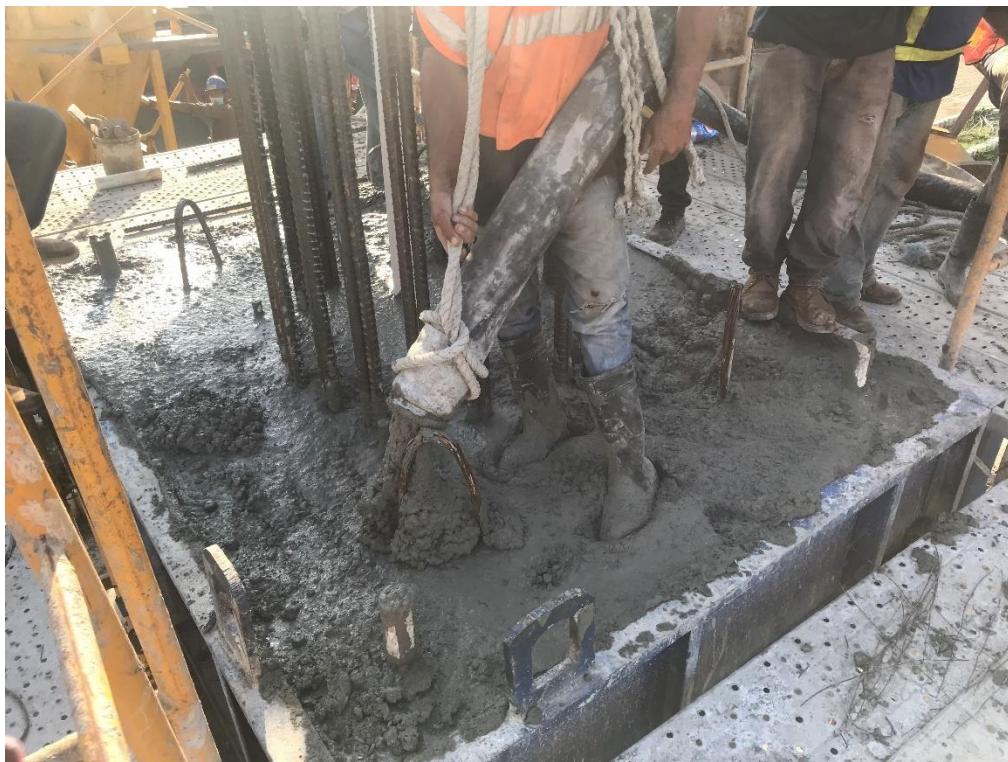
Ilustración 43 Colado de losa de Capitel con bomba
