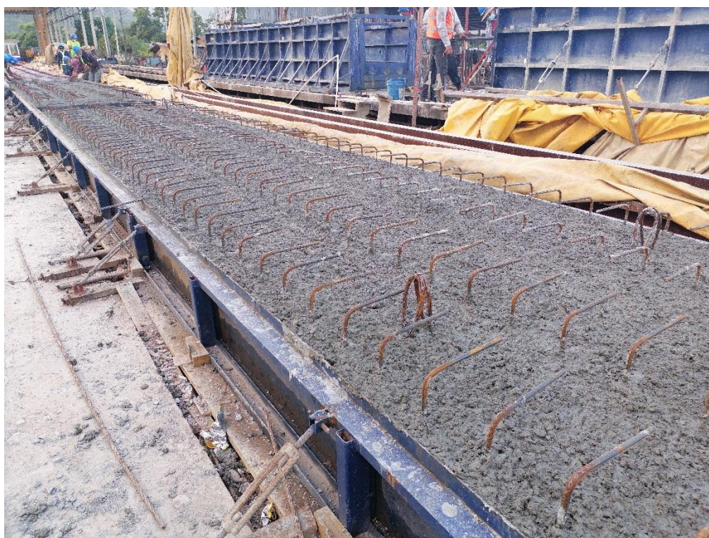
Ilustración 13 Acabado final de Losas
