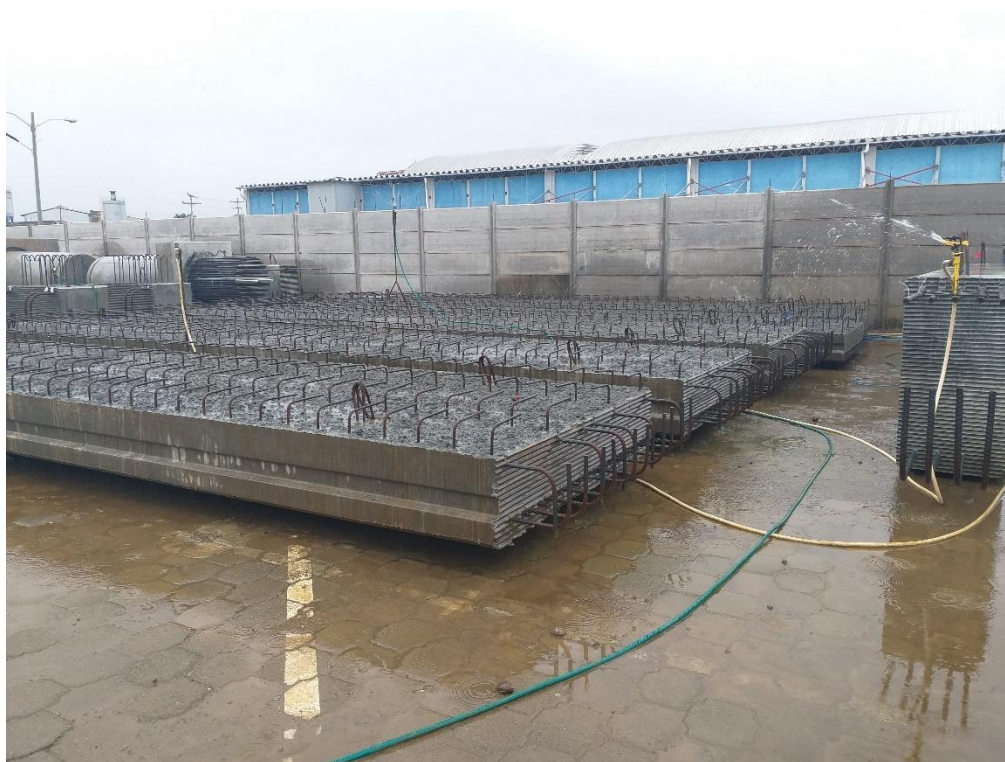
Ilustración 17 Curado de Losas en el Patio de Curado
