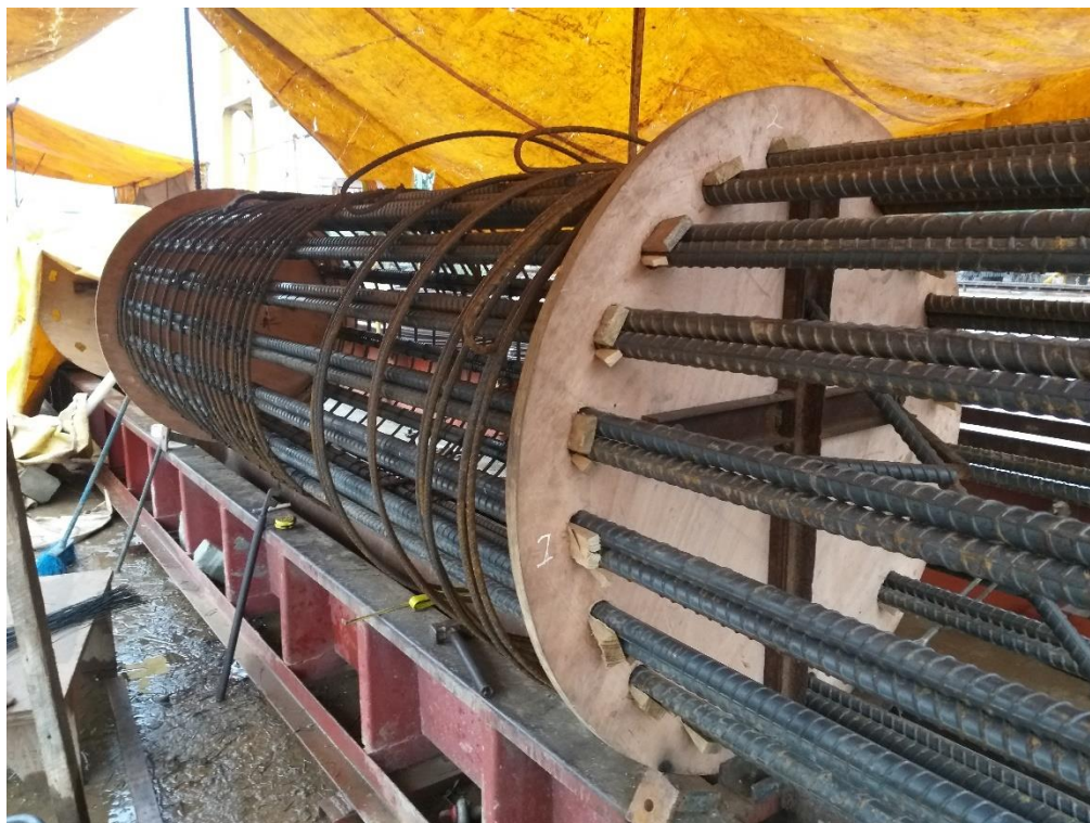
Ilustración 38 Armado de Columna Capitel
