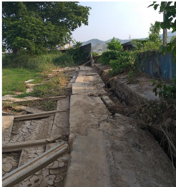
Ilustración 9 Muro Caído
