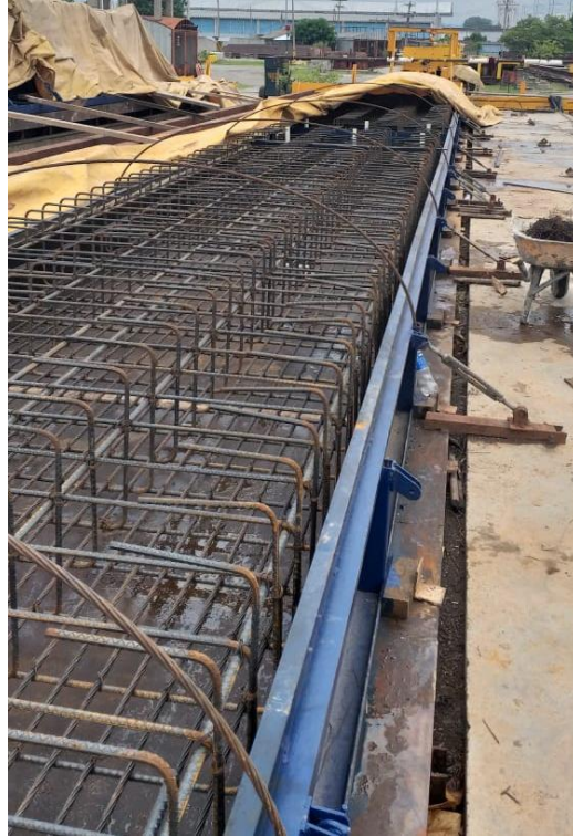
Ilustración 6 Vista del Armado de las Losas Prefabricadas
