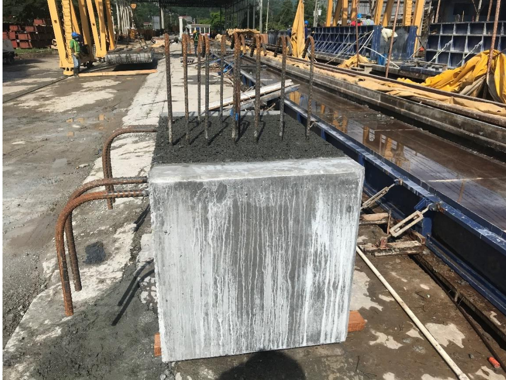
Ilustración 28 Desmolde de Viga CB-1
