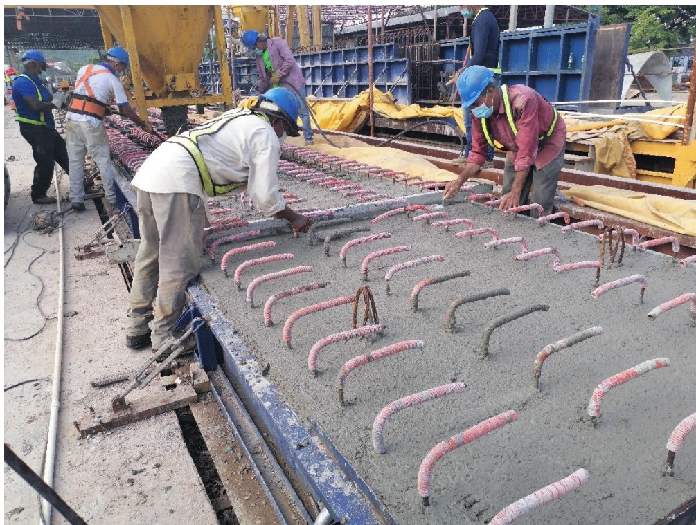
Ilustración 12 Acabado inicial de Losas
