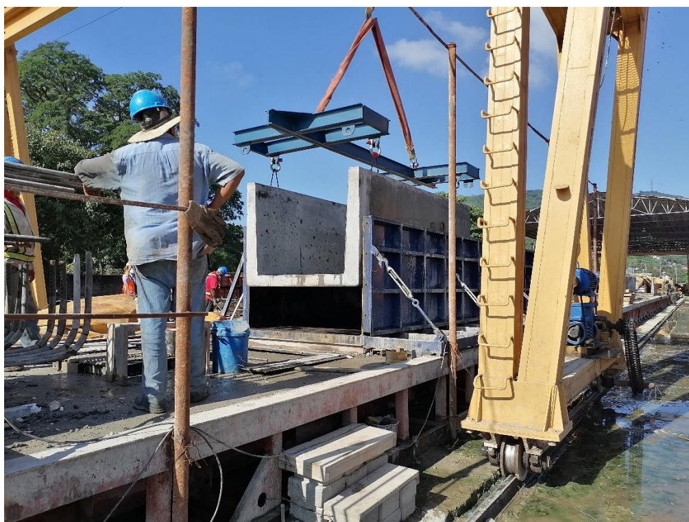
Ilustración 35 Desmolde de Viga U
