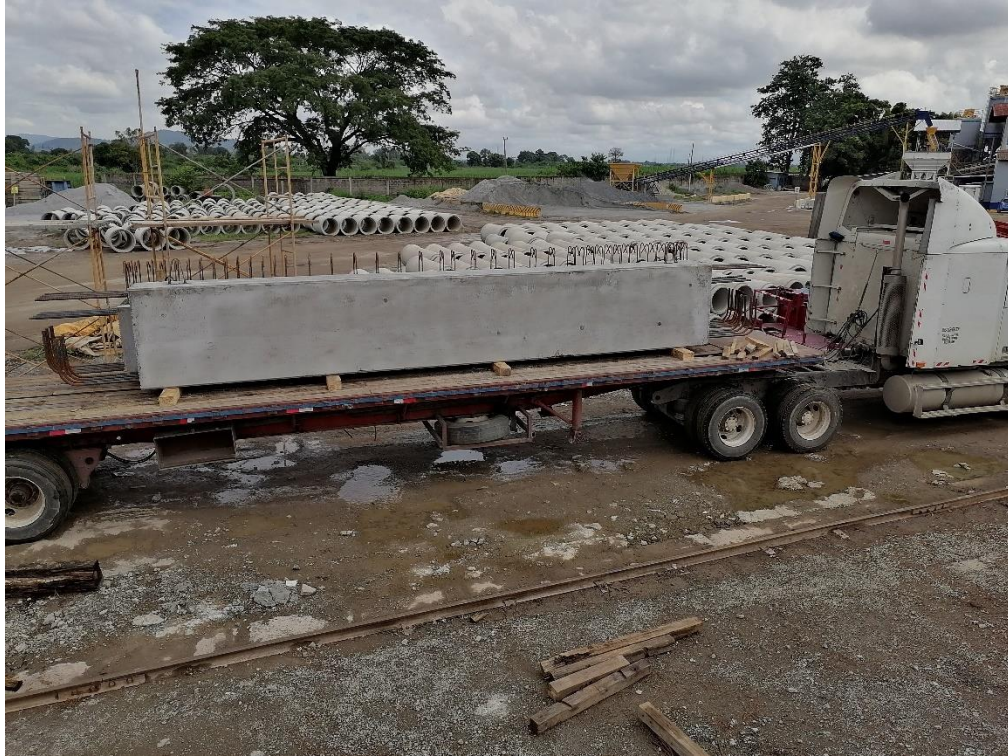
Ilustración 22 Transporte de vigas a patio de curado
