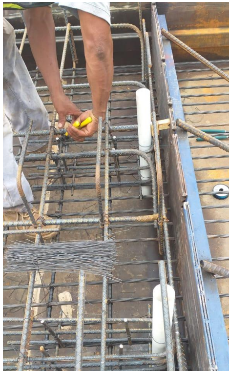
Ilustración 7 Colocación de Alambre de Amarre y tubos de PVC
