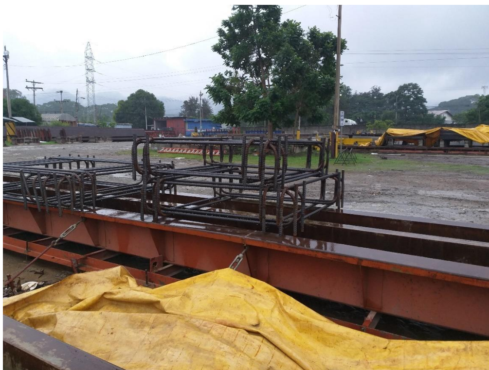
Ilustración 39 Armado de losa de capiteles
