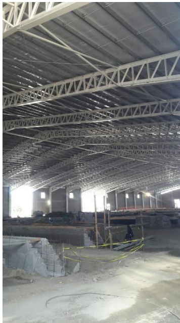
Ilustración 26- Visita a la nave industrial de CASW 2
