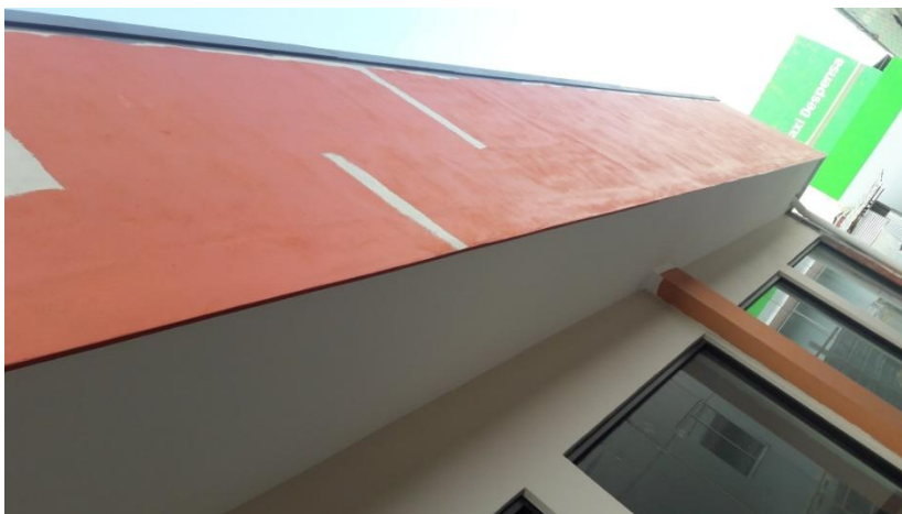
Ilustración 10- Estructura de fascia en Mall Las Américas
