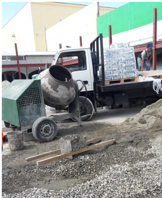
Ilustración 9- Reconstrucción de nuevos locales en Mall Las Américas
