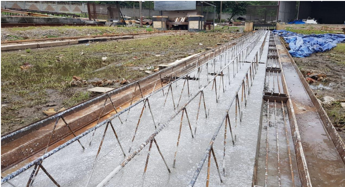
Ilustración 12. Fabricación de viguetas pretensadas.
