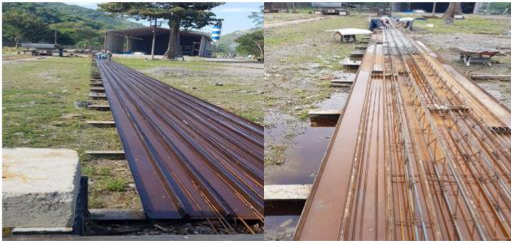
Ilustración 1. La fotografía de la izquierda es la limpieza de la bancada y de la derecha colocación de armado.
