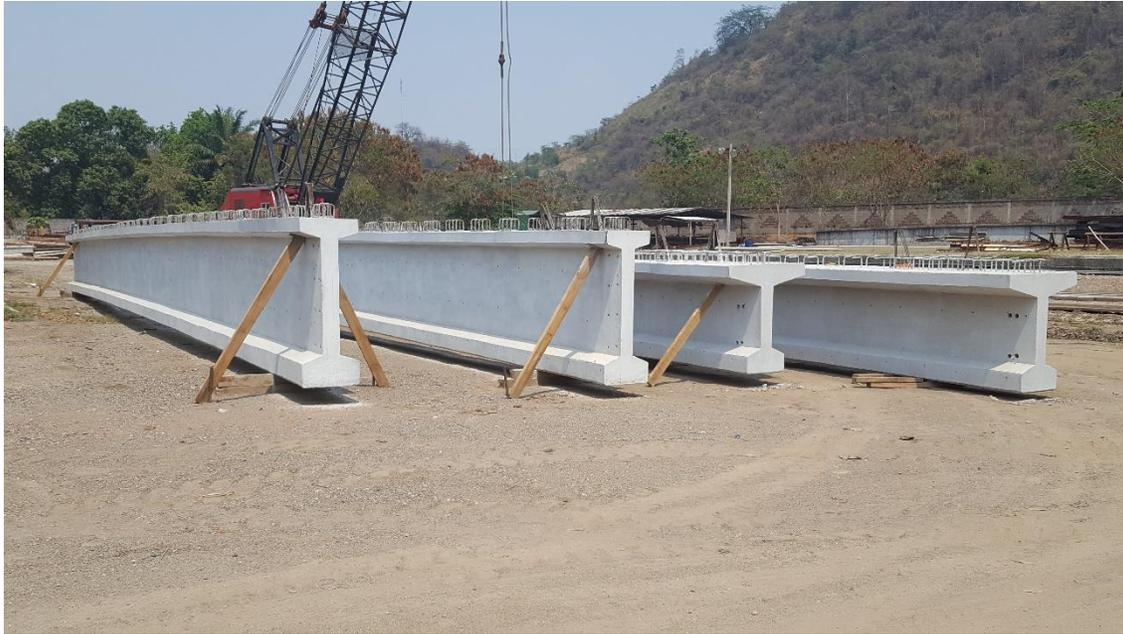
**Ilustración 5. Vigas pretensadas finalizadas y lista para transporte**
