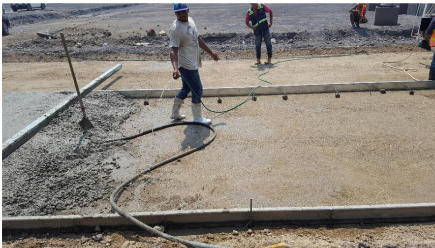
**Ilustración 30. Preparación de zona previo a colocación del concreto**
