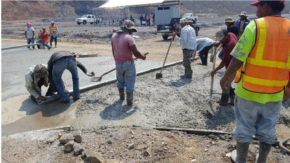
**Ilustración 31. Colocación de concreto**
