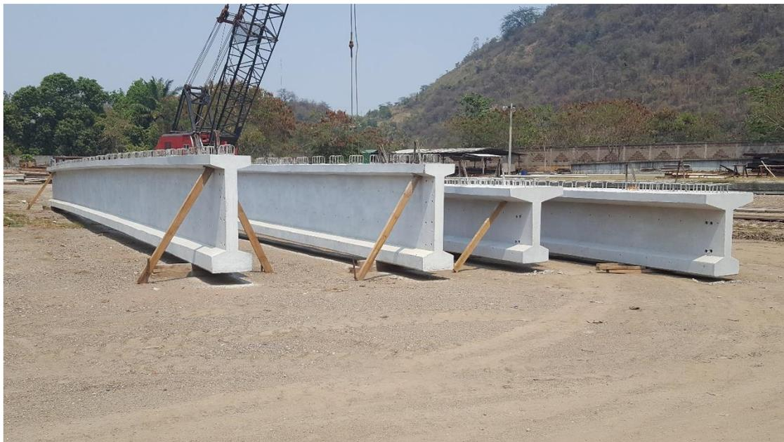
**Ilustración 109. Vigas prefabricadas terminadas y listas para enviar**
