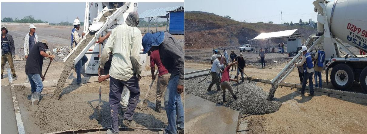
**Ilustración 33. Colocación de concreto**
