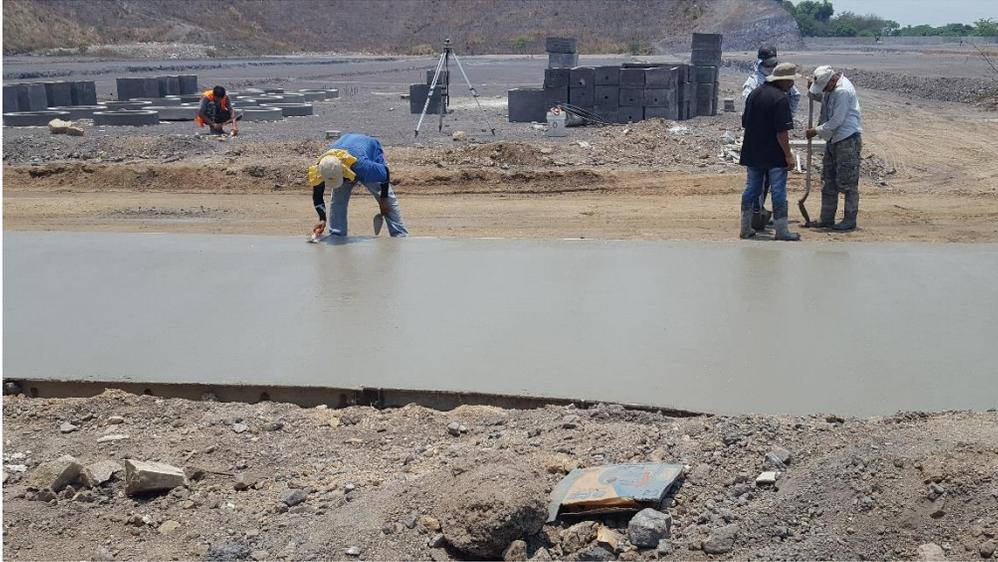
**Ilustración 32. Resane de la orilla de la fundición**
