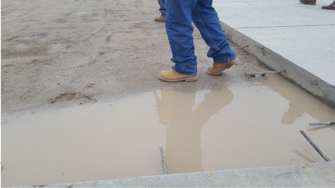
**Ilustración 118. Mala preparación de sitio para fundición**
