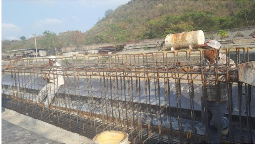
**Ilustración 100. Armado del acero para las vigas pretensadas**
