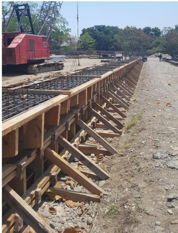
**Ilustración 6. Vigas encofradas listas para fundición**
