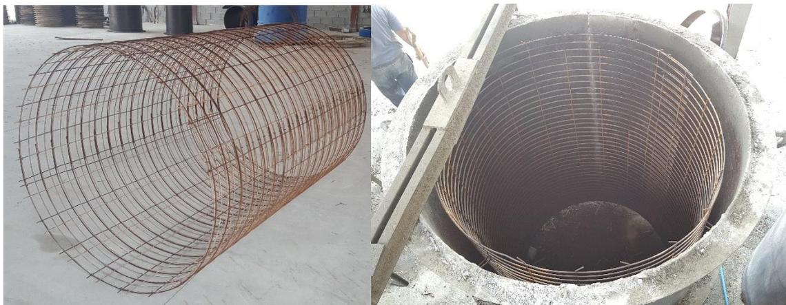
**Ilustración 7. Armado y encofrado de tubo de concreto diámetro 42"**
