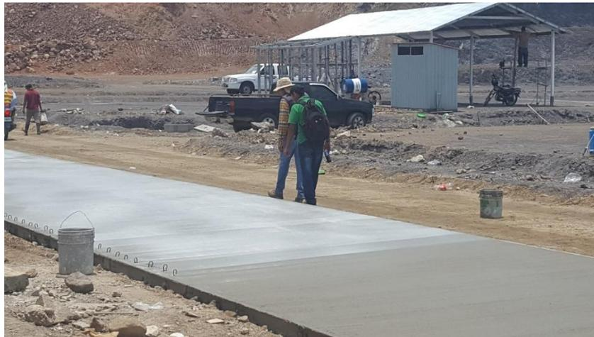
**Ilustración 29. Curado del concreto**
