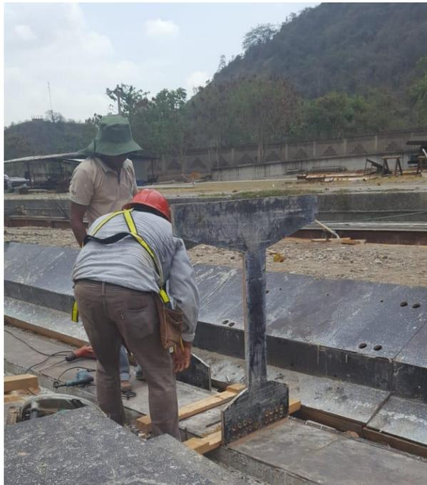
**Ilustración 101. Colocación de tableros laterales para el encofrado de plywood**
