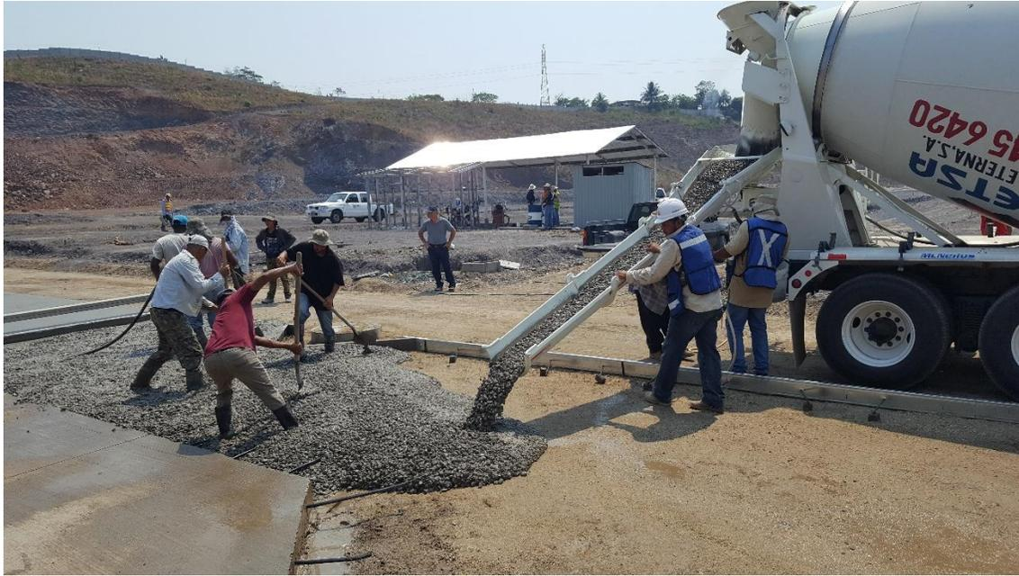
**Ilustración 116. Fundición de concreto Valle Escondido**
