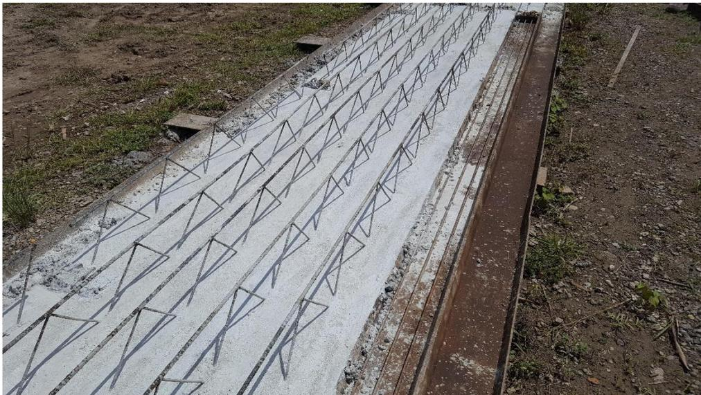
**Ilustración 94. Viguetas recién curadas con antisol**
