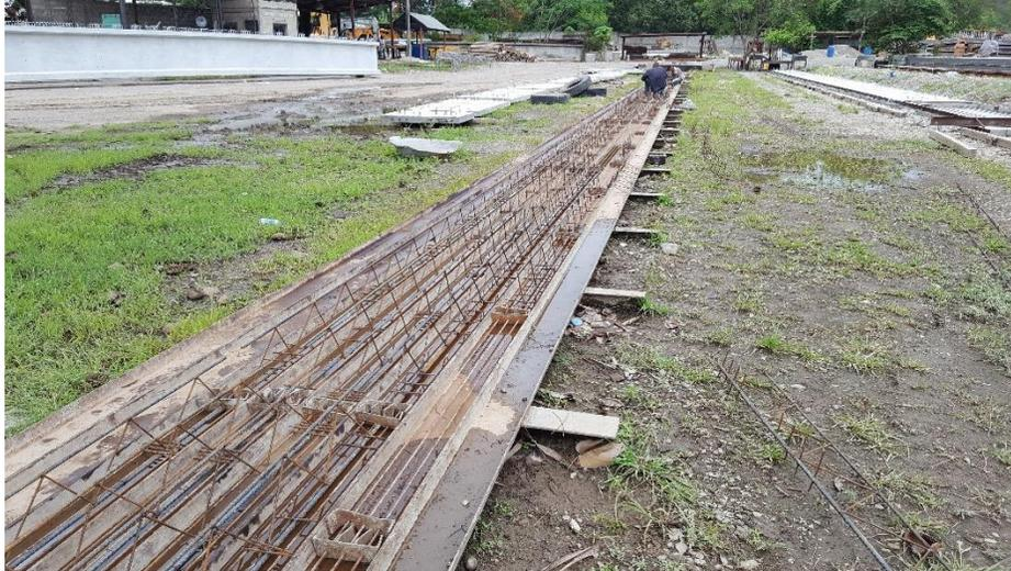
**Ilustración 91. Tensado y armado de las viguetas**
