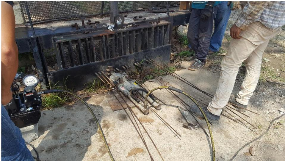
**Ilustración 92. Tensado de los cables para las viguetas**
