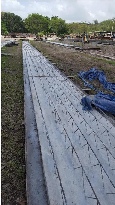
**Ilustración 95. Viguetas prefabricadas finalizadas**
