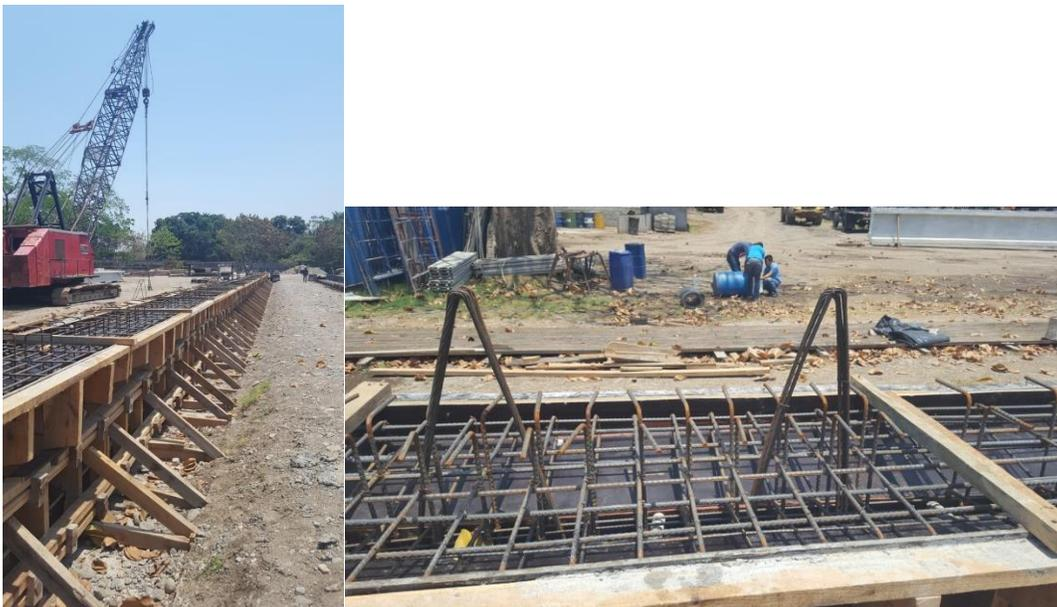
**Ilustración 103. Encofrado de las vigas con la utilización de plywood y madera como refuerzo**
