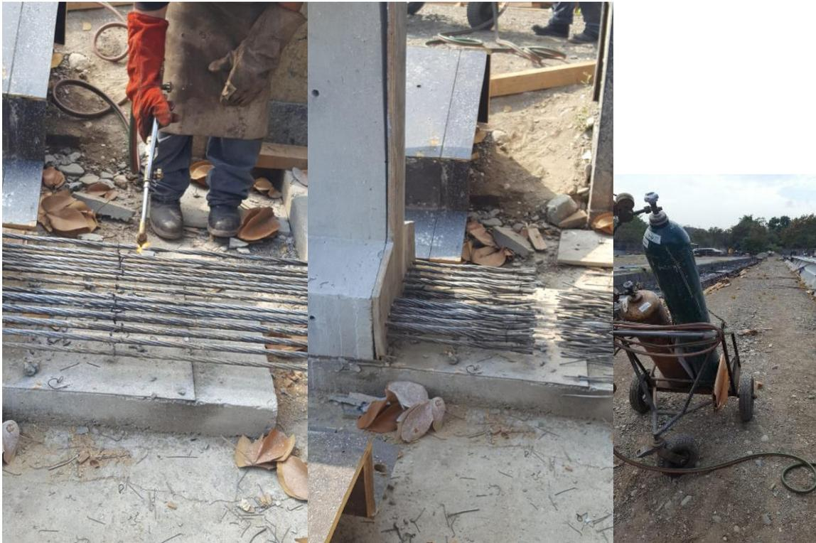
**Ilustración 104. Corte de los cables con oxígeno y acetileno de las vigas**
