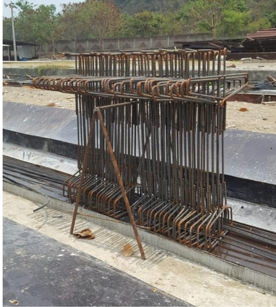
**Ilustración 98. Preparación del acero para las vigas pretensadas.**
