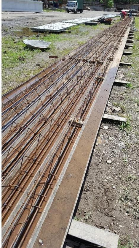
**Ilustración 93. Armado de acero de las viguetas prefabricadas**
