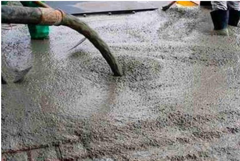
**Ilustración 10. Manejabilidad del concreto**
