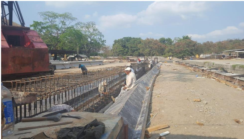
**Ilustración 99. Preparación de viga prefabricada**
