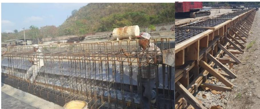
**Ilustración 14. Armado y encofrado para vigas de concreto**
