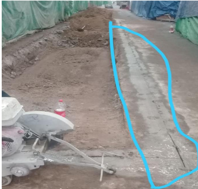
Figura 9. Cortes de junta fría.
