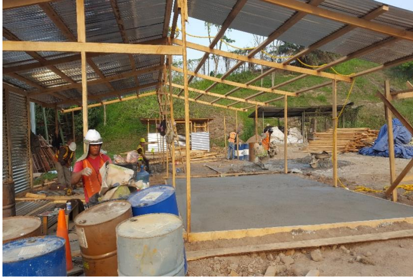
Figura 14. Fundición de piso y techado.
