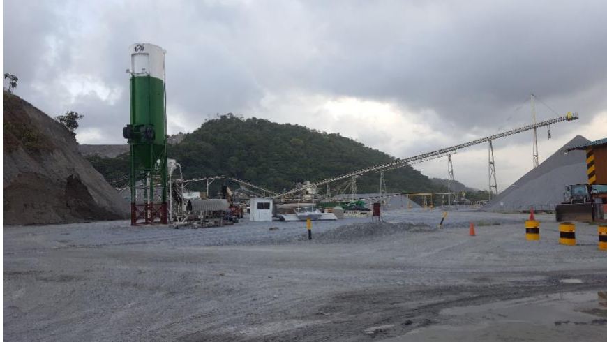
Figura 26. Planta de agregados AGRECASA.
