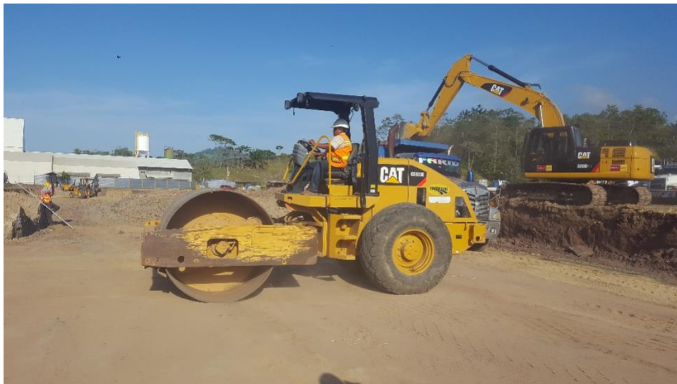
Figura 21. Maquinaria de terracería.
