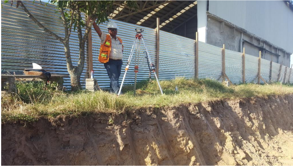
Figura 22. Cuadrilla topográfica de nivelación.
