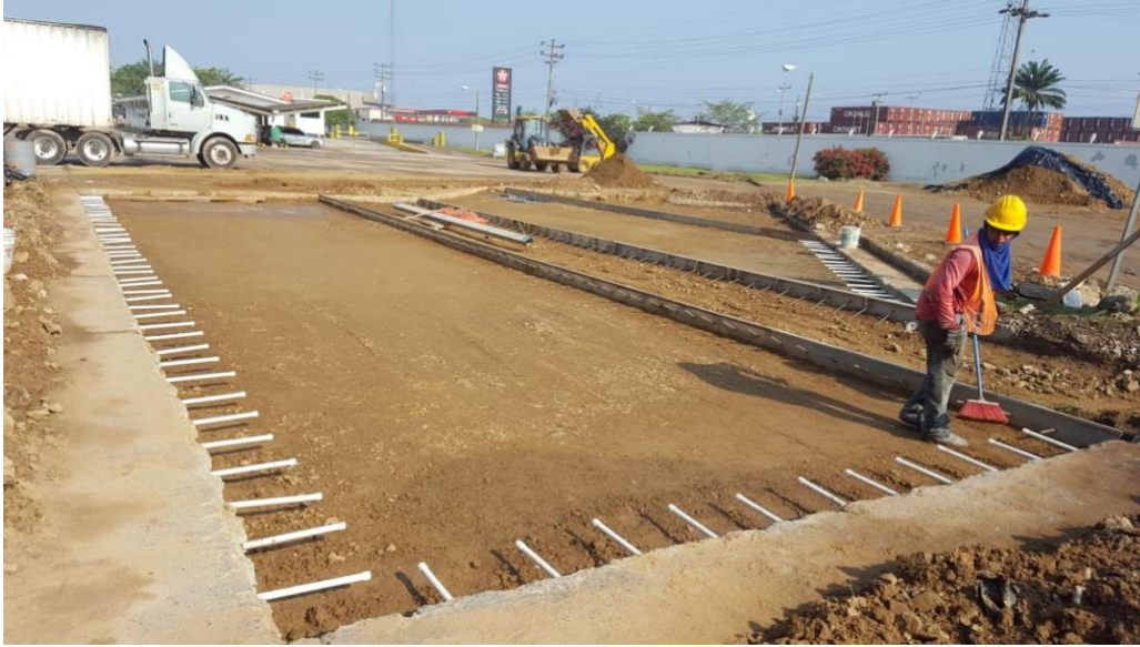
Figura 4. Identificar la zona de fundición.
