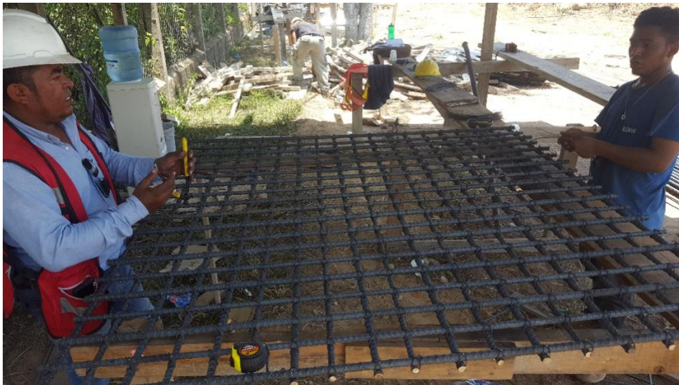
Figura 23. Cama de acero para zapata.
