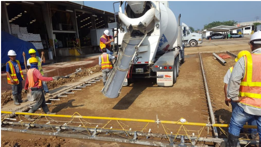
Figura 3. Fundición de pastillas de concreto.
