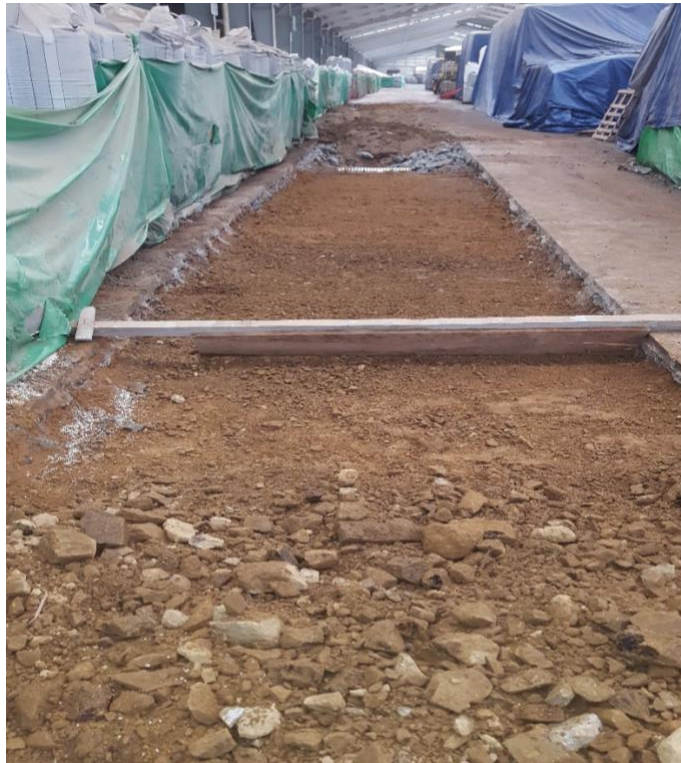
Figura 7. Demolición de pavimento interno de la nave.
