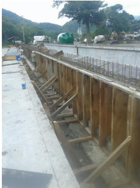
Ilustración 3. Encofrado de Viga WS-100.
