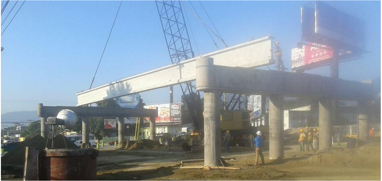
Ilustración 12. Colocación de Viga WS-100.
