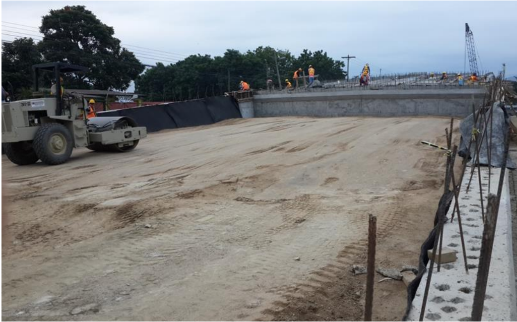
Ilustración 16. Rellenando y Compactando en el Muro.
