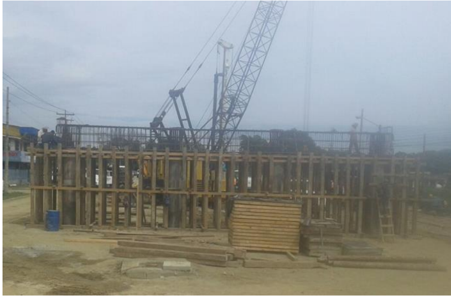
Ilustración 8. Armado de Capitel.
