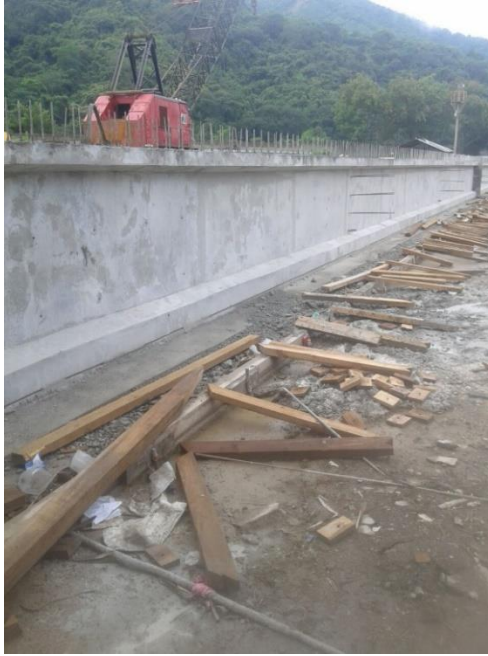
Ilustración 2. Viga WS-100 Fundida.
