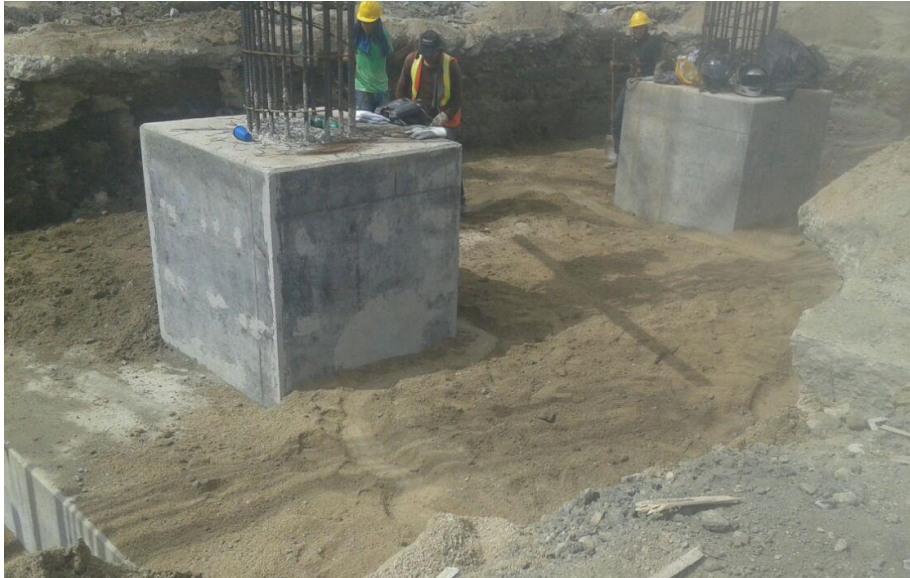
Ilustración 4. Construcción de Pedestales.
