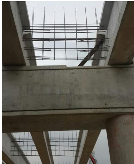
Ilustración 15. Armado de los Diafragmas.
