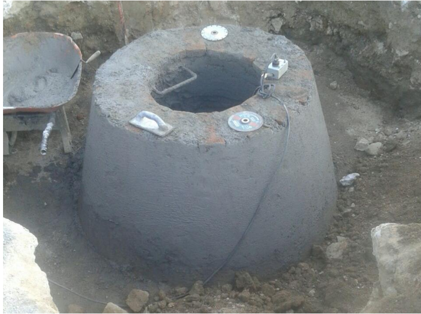
Ilustración 10. Construcción de Pozo de Inspección.
