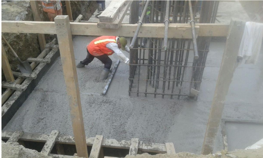
Ilustración 6. Fundición de Zapata Aislada
