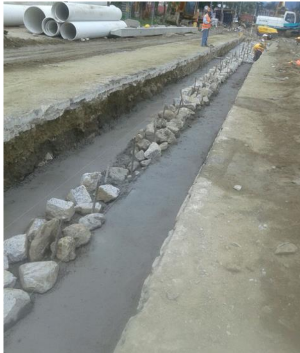
Ilustración 9. Construcción de Muro.
