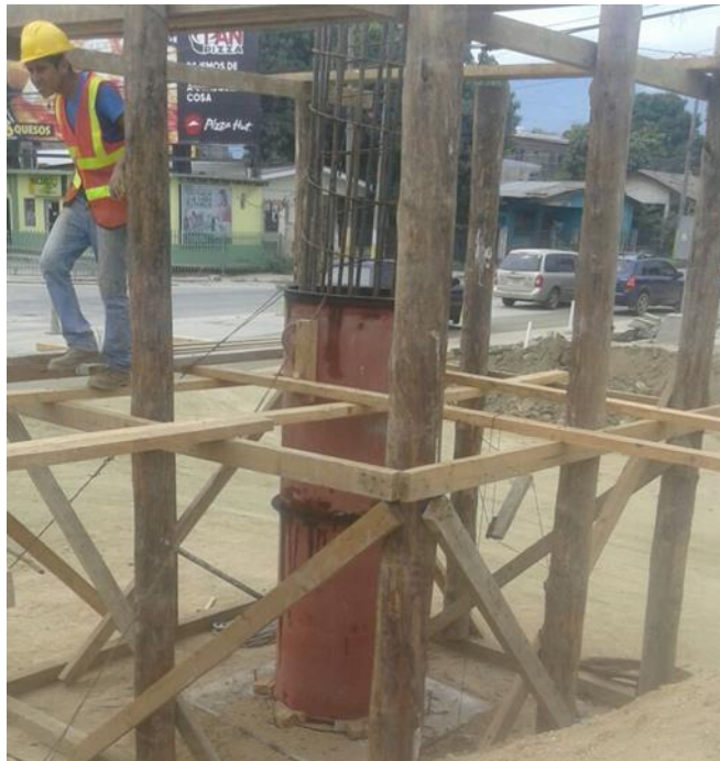
Ilustración 7. Encofrado de Pilastra.
