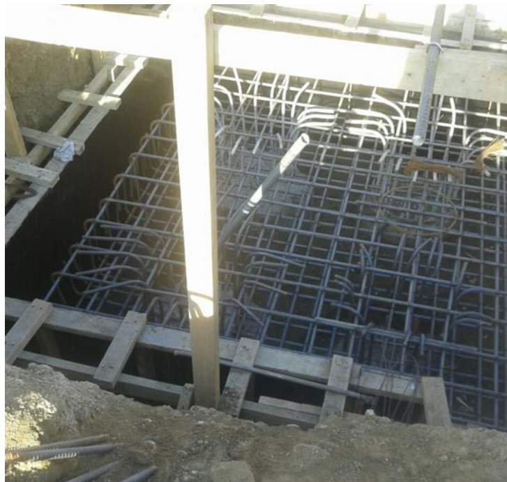
Ilustración 5. Armado de Zapata Aislada.
