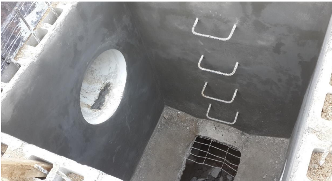
Ilustración 17. Construcción de Tragante para Aguas Lluvias.
