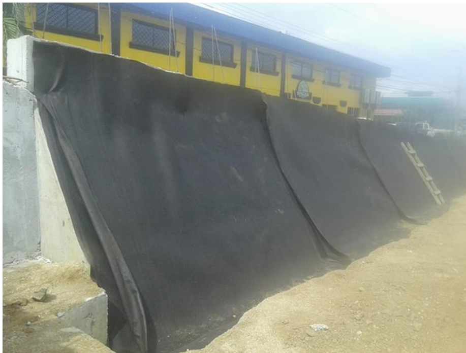
Ilustración 13. Colocación de Geomembrana en Muro.
