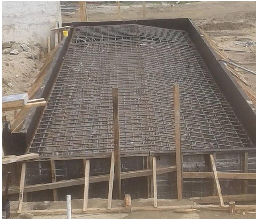
Ilustración 11. Armado de Estribo #2
