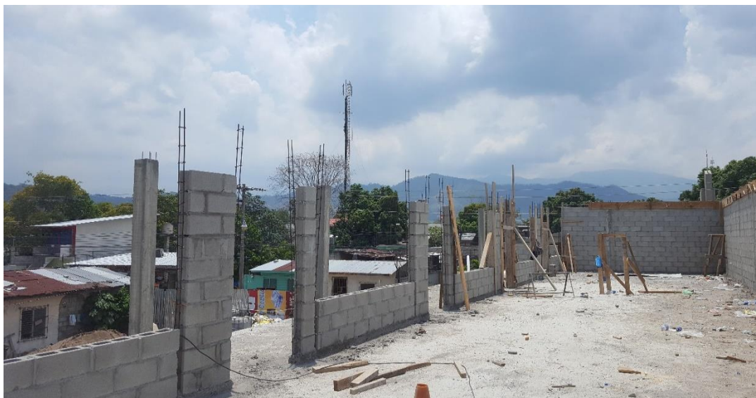
Ilustración 3. Jambas de puertas y ventanas
