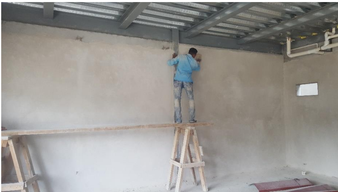
Ilustración 16. Lijado de paredes
