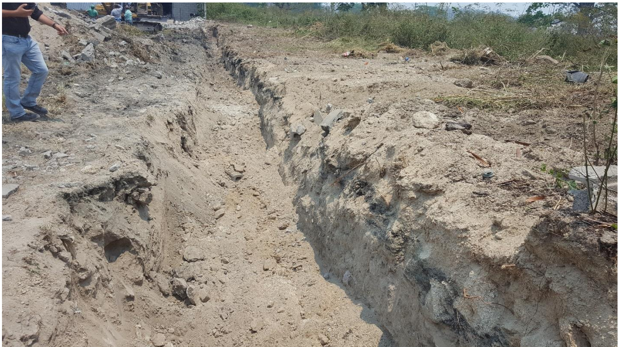
Ilustración 4. Demolición del cemento corrido
