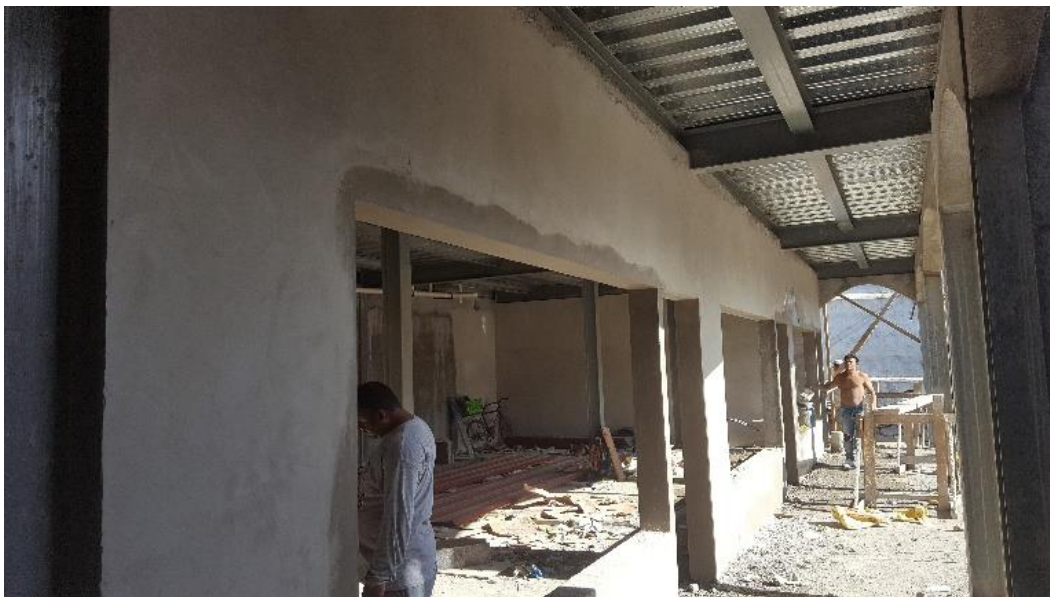
Ilustración 11. Pulido de puertas y ventanas
