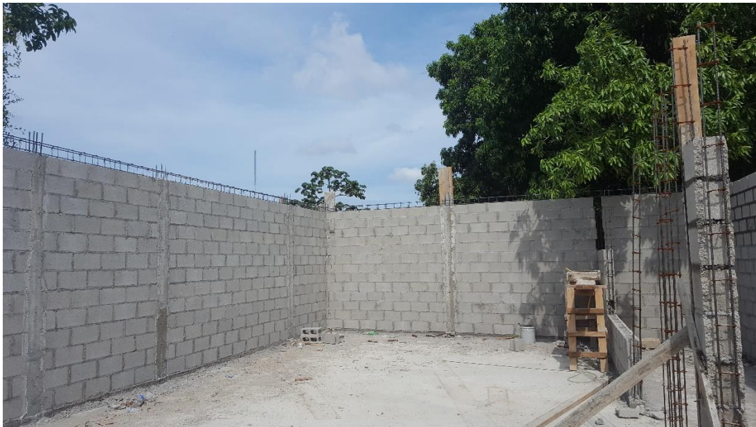
Ilustración 2. Solera Superior
