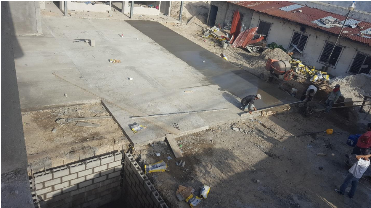
Ilustración 22. Fundición del Pavimento
