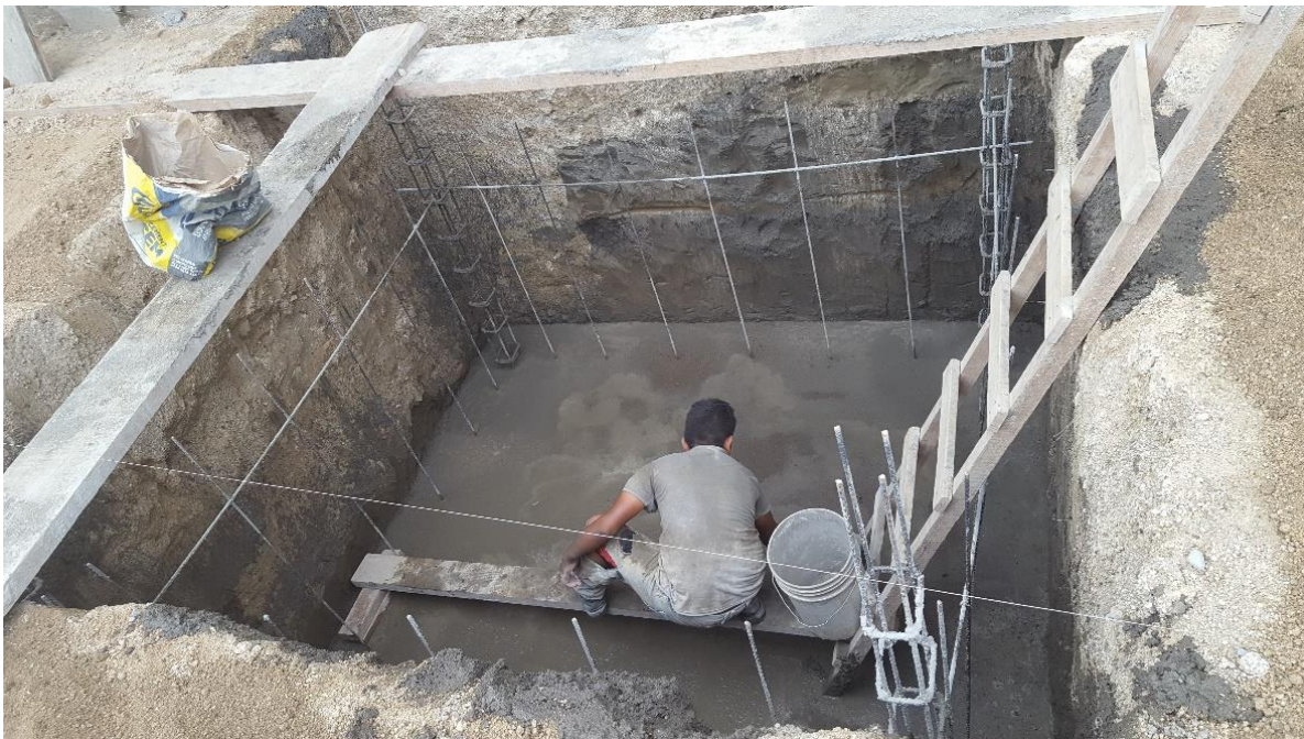
Ilustración 21. Fundición del piso
