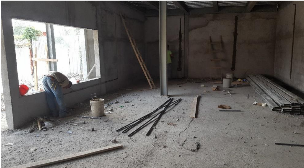
Ilustración 10. Ranuras de tomas e interruptores
