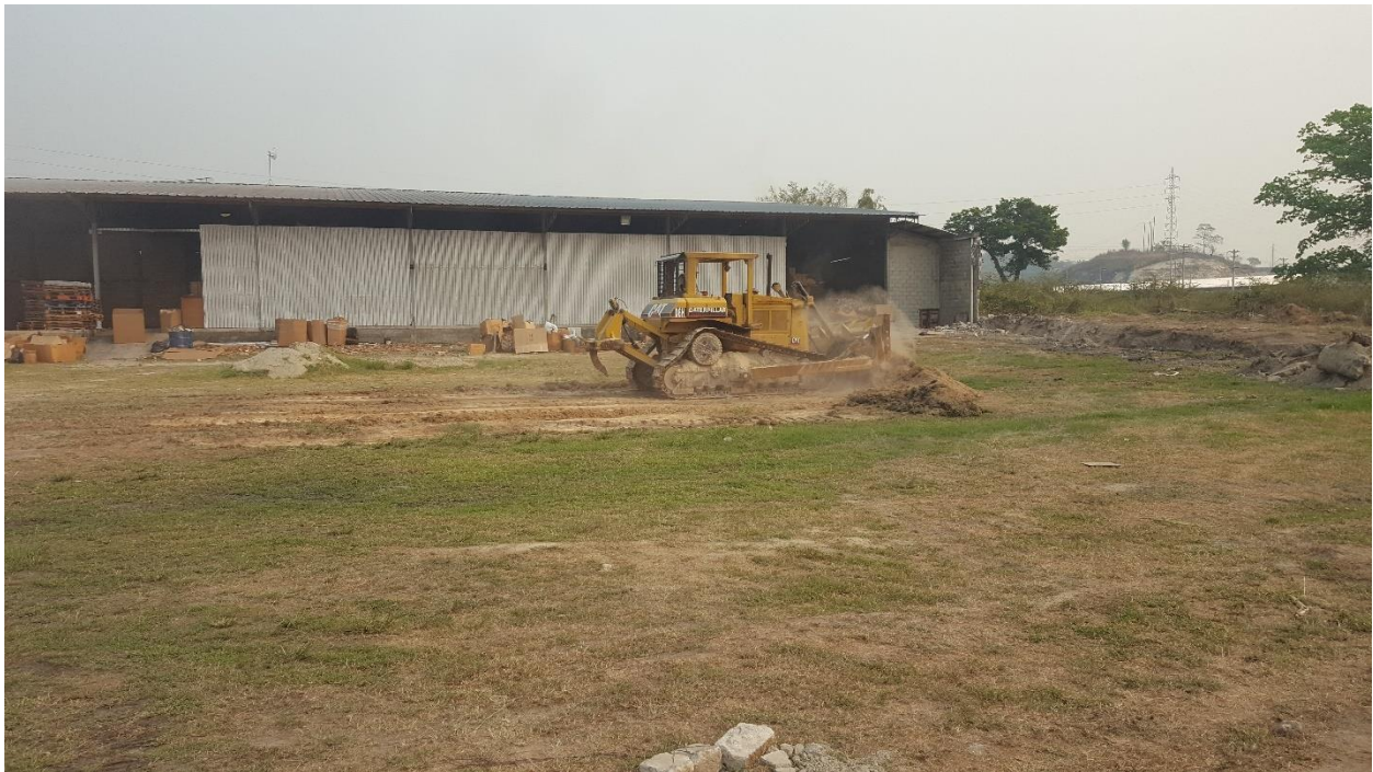
Ilustración 7. Descapote de la capa vegetal
