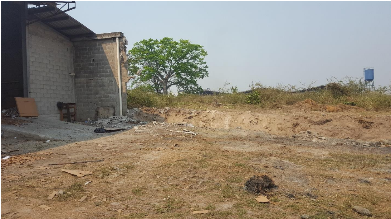
Ilustración 6. Demolición total del muro
