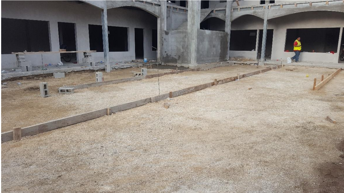
Ilustración 20. Encofrado de las pastillas
