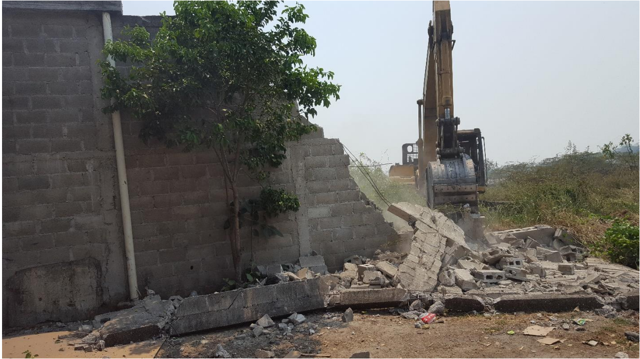
Ilustración 5. Demolición del muro
