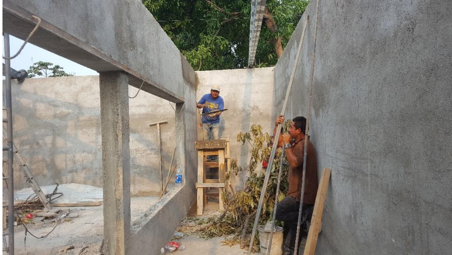
Ilustración 8. Finalización del repello
