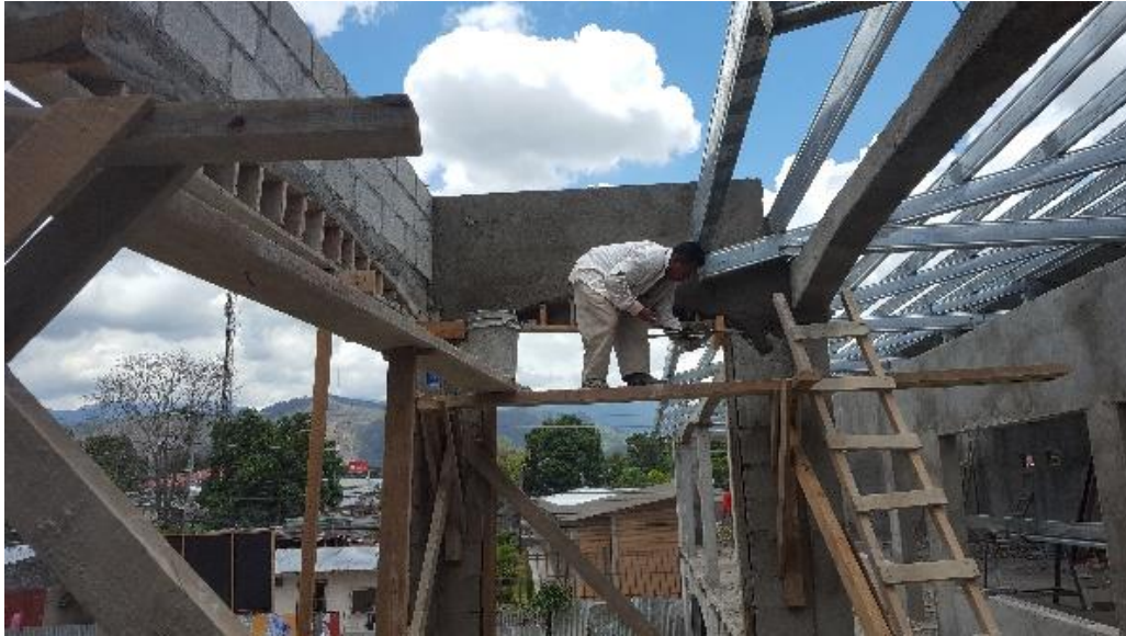
Ilustración 12. Repello del cubículo de escaleras
