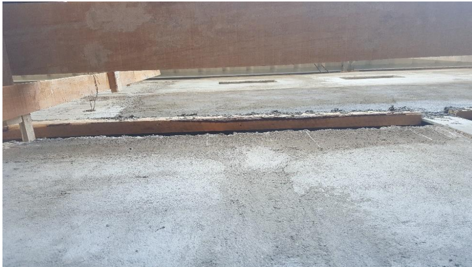
Ilustración 14. Repello del segundo nivel
