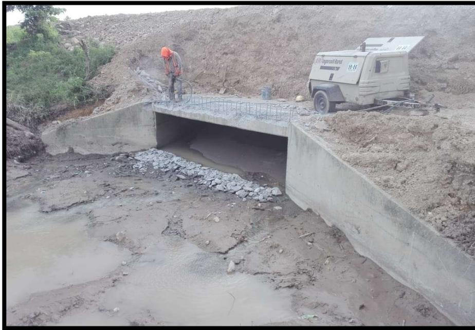
**Figura 12. Demolición de Cabezal. Estación: 209+120**
