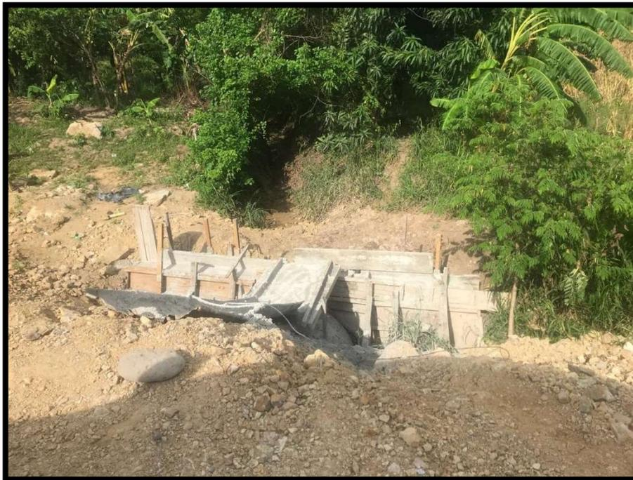
**Figura 11. Fundición de Cabezal, Tubería Diámetro 36. Estación: 209+805.19**
