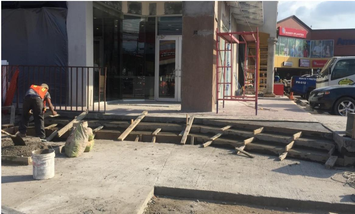
Ilustración 19 fundición de gradas
