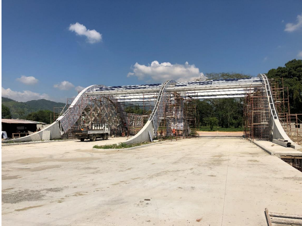
Ilustración 5. Pórtico de la entrada principal del parque (nave CASW)
