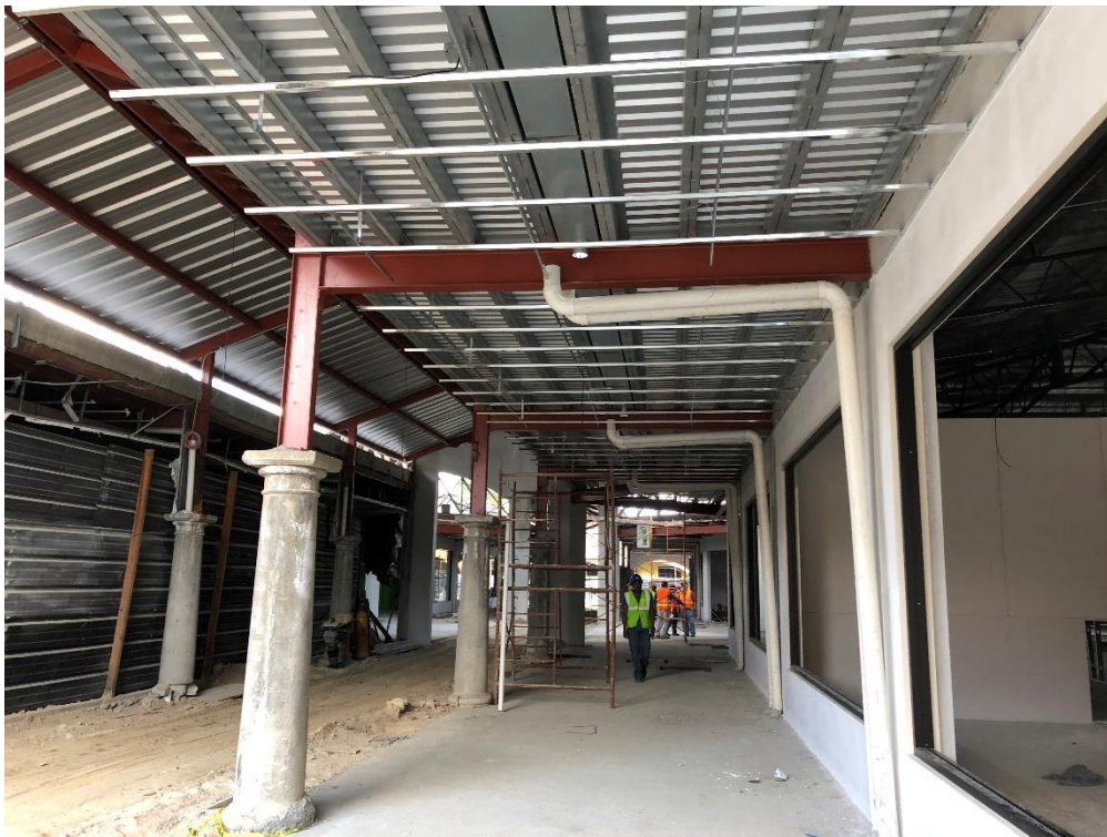
Ilustración 14. Avances en Mall Las Américas: estructura de techo
