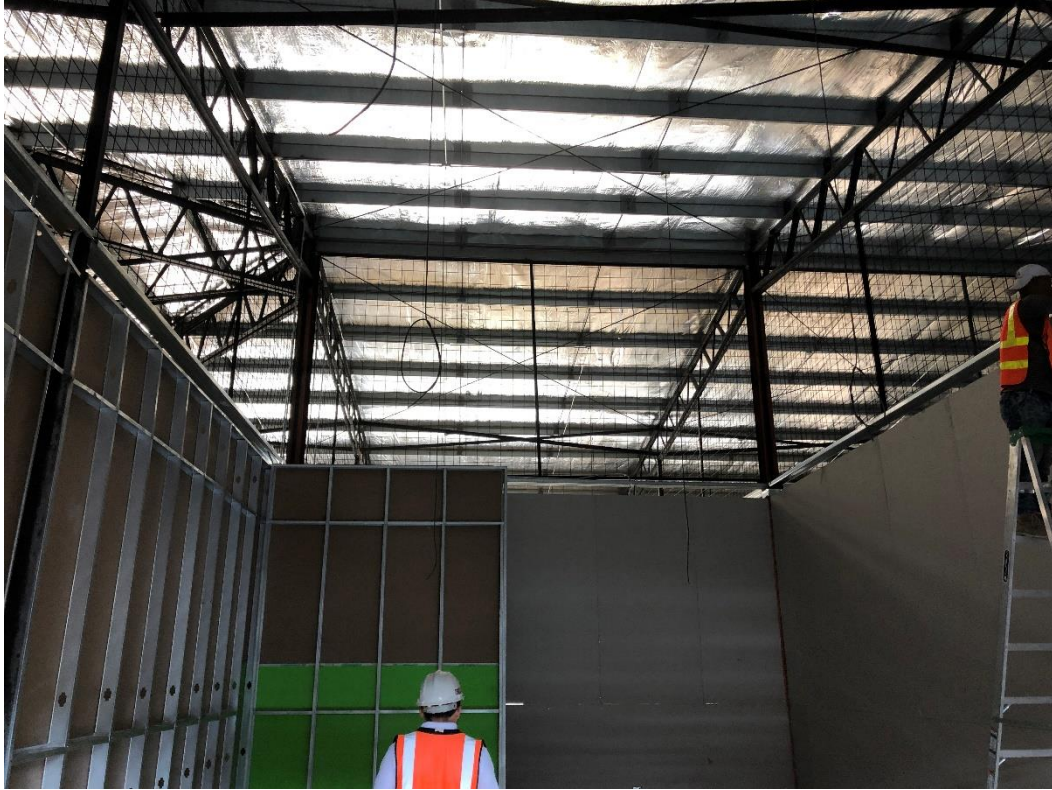
Ilustración 15. Avances en Mall Las Américas: tabla yeso, malla ciclón y techo.
