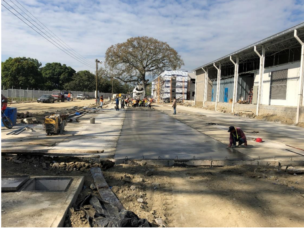
Ilustración 3. Fundición de pavimento en nave CASW
