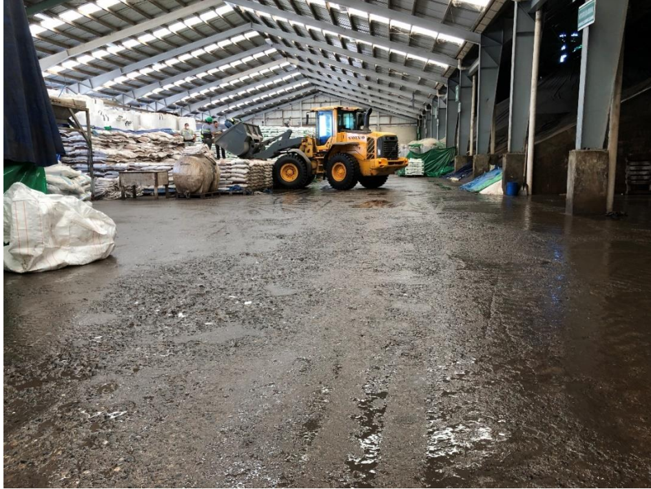
Ilustración 21. Estado actual de pavimento en Disagro
