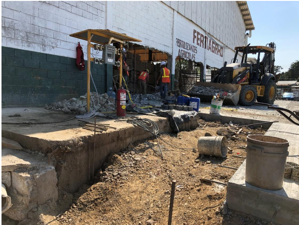
Ilustración 20. Remodelación en Fertiagrho
