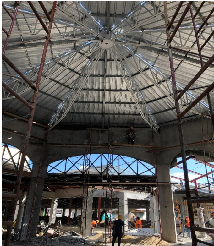
Ilustración 6. Estructura metálica de techo en Mall Las Américas
