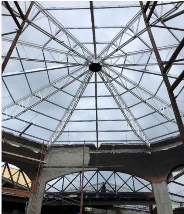
Ilustración 1. Estructura metálica para techo en Mall Las Américas
