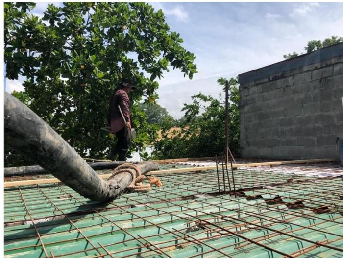
Figura 3. Fundición de losa de entepiso para apartamentos utilizando bomba de presión.
