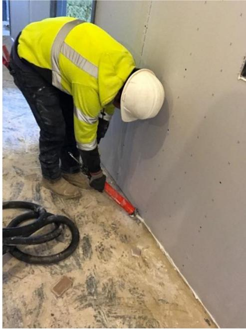
*Figura 20. Aplicación de sellador parte inferior*
