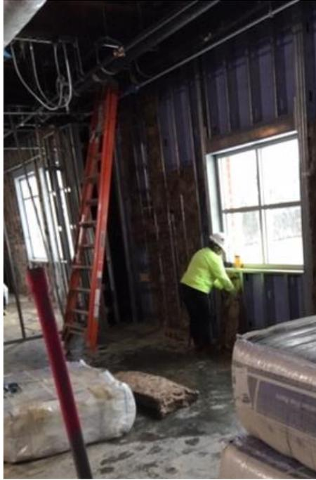
*Figura 18. Colocación de lana de vidrio*
