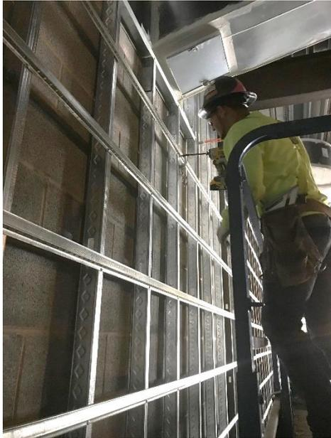
*Figura 26. Instalación de perfiles omega*
