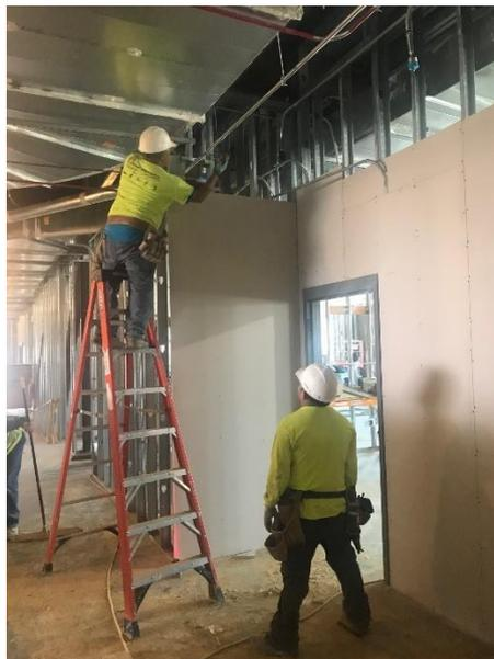
*Figura 23. Colocando cubiertas superiores*
