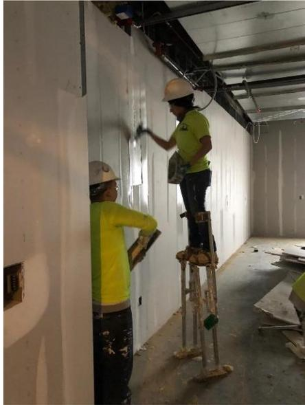
*Figura 22. Aplicando compuesto con zancos*
