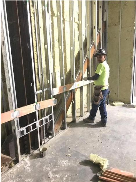
Figura 28. Colocando rigidizado de madera
