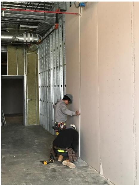
*Figura 27. Colocación de paneles de yeso*
