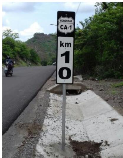
**Figura 18. Señalización vertical informativa de kilometraje colocada en el la estación 30+300.**
