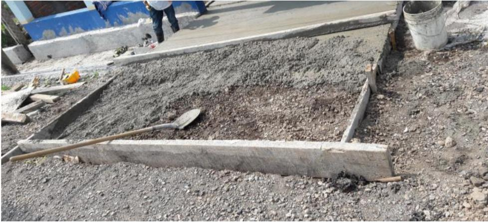
**Figura 27. Fundición de losa vehicular, de 15 cm. de espesor.**
