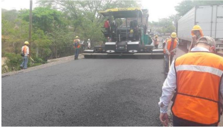
**Figura 4. Colocación de capa de mezcla asfáltica de  $\frac{3}{4}$  de pulgada de tamaño máximo nominal.**
