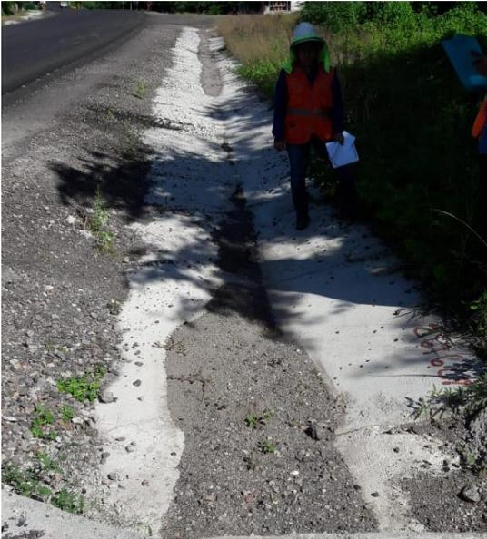
**Figura 46. Enchape de cunetas sucias identificadas en la inspección de niveles de servicio.**
