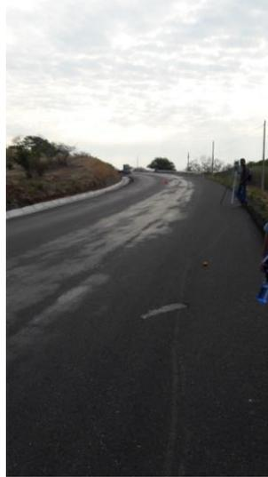
**Figura 15. Levantamiento topográfico en áreas de la carpeta que presentaban exudación.**
