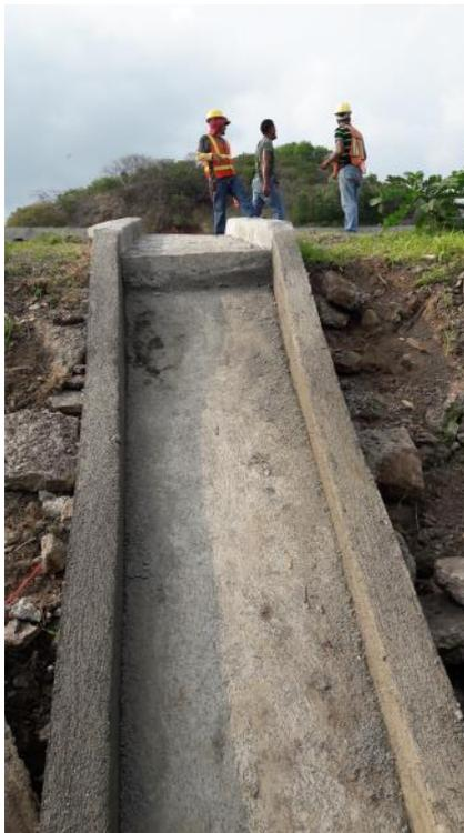
**Figura 30. Bajante de aguas lluvias.**
