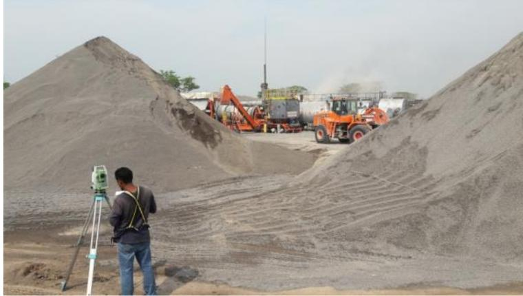
**Figura 10. Levantamiento topográfico realizado para cálculo de volúmenes de agregado existente.**
