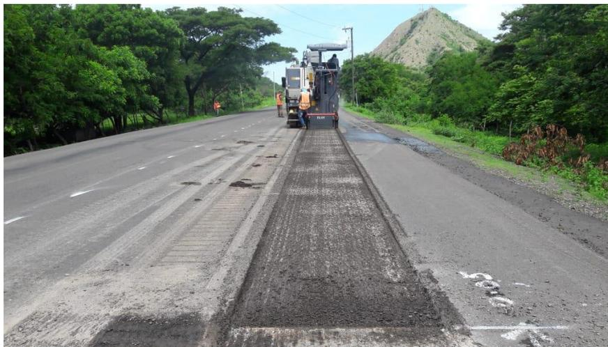
**Figura 42. Fresado de áreas exudadas, en un espesor de 0.05 m.**
