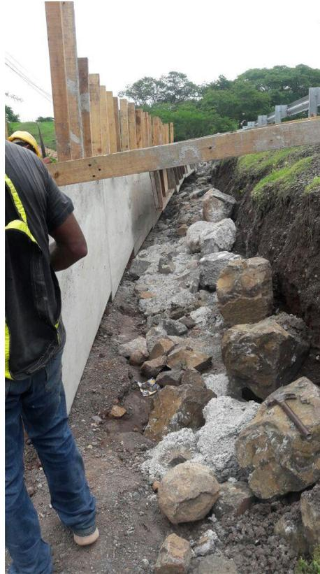
**Figura 39. Medición de muro de concreto ciclópeo para contención de relleno.**
