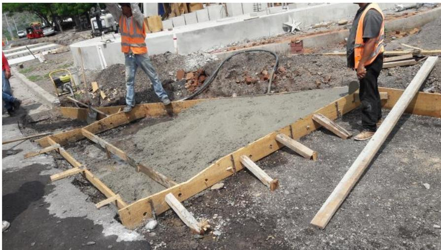
**Figura 24. Fundición de losas en las bahías ubicadas en el paisajismo con espesor de 26 cm. y pendiente de 2%.**
