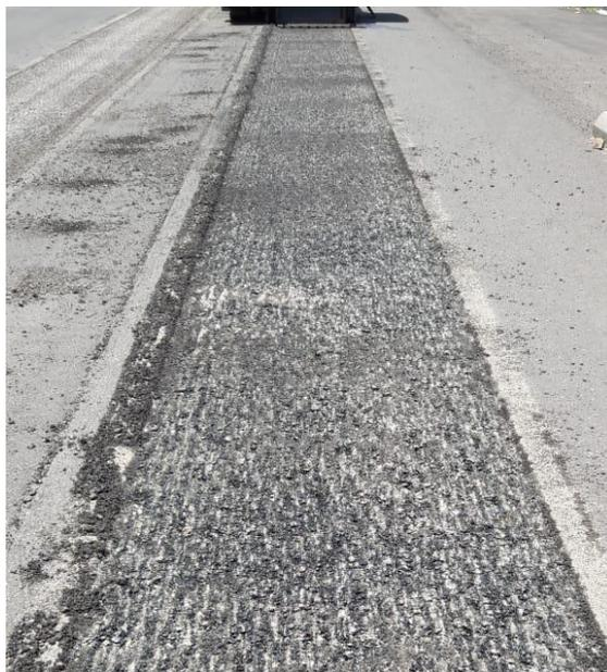
**Figura 43. Capa inferior de la superficie de carpeta de rodadura presentando daño considerable, con alto contenido de asfalto.**
