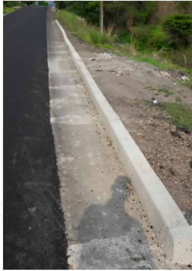
**Figura 31. Bordillo de concreto hidráulico, altura de 25 cm.**
