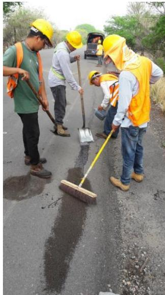
**Figura 12. Relleno y sellado de grietas en carpeta asfáltica existente.**
