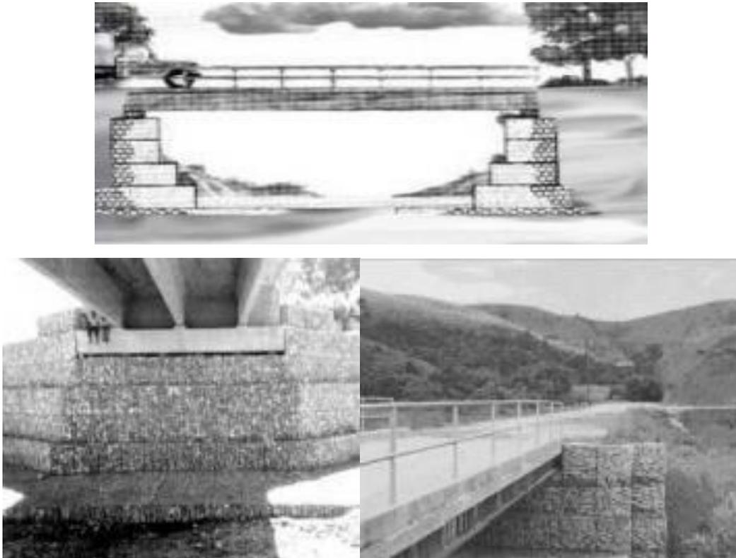
**Ilustración 57 - Ejemplos de estribos construidos en mampostería de piedra**
