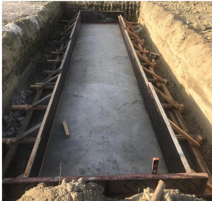
**Ilustración 7:** Losa fundida por los albañiles
