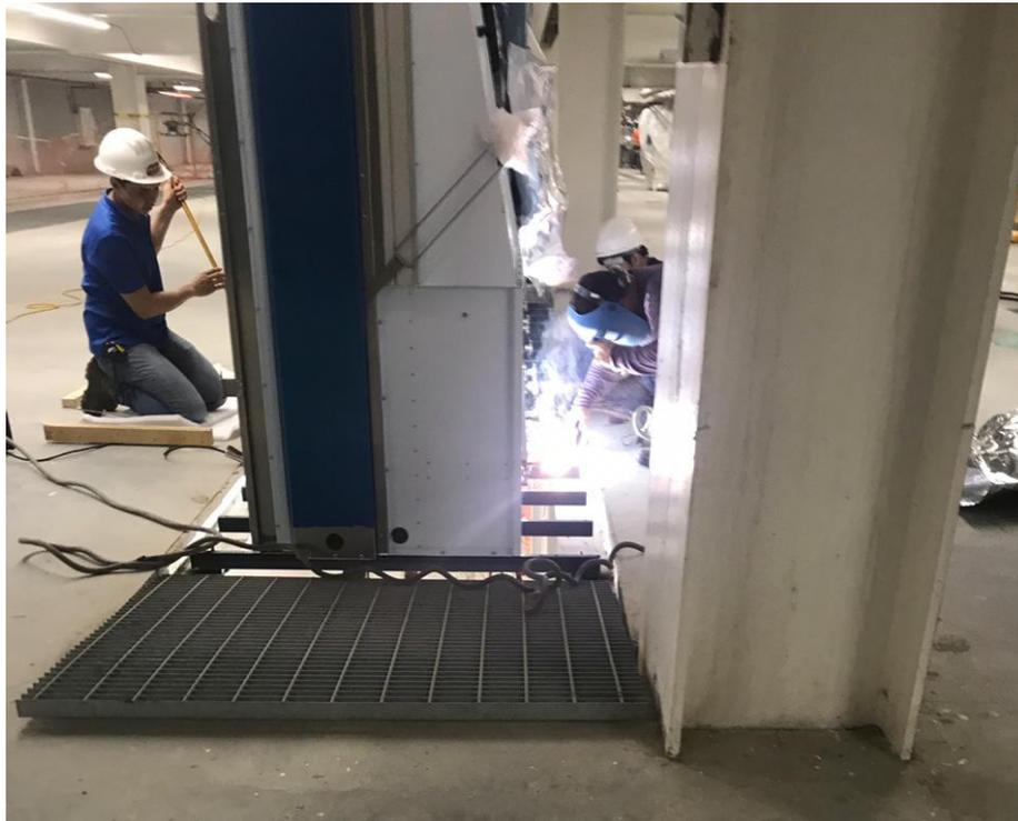
**Ilustración 11:** *Soldadura de perfilera metálica*
