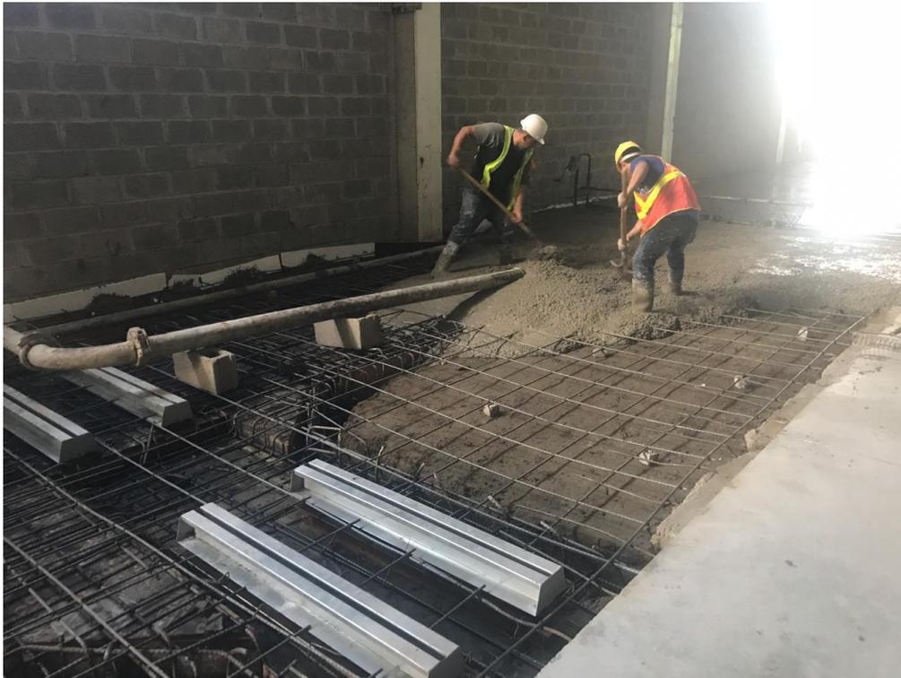
**Ilustración 5:** *Fundición de firme de concreto*
