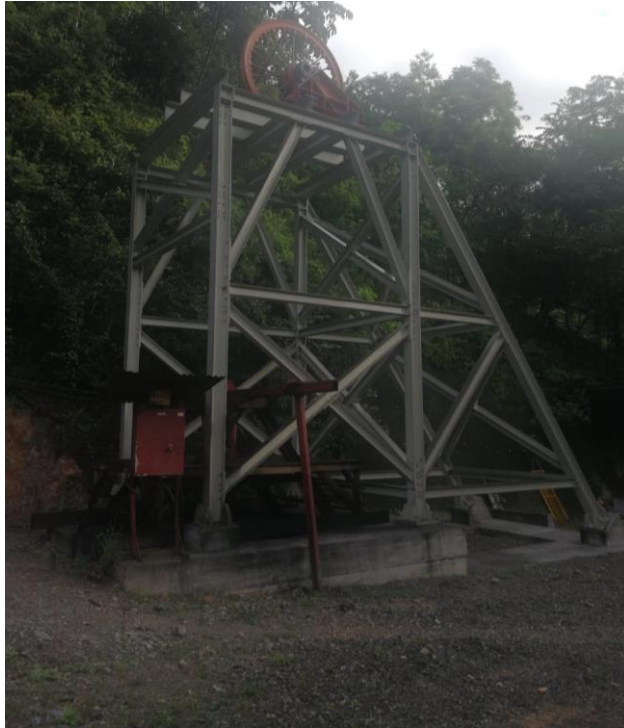
Ilustración 8: Torre y polea nueva en Bonanza.
