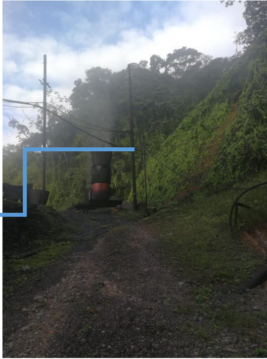
Ilustración 12: Talud a estabilizar, predio Bonanza
