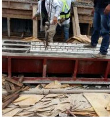
**Figura 11. Vigueta 16J, desmolde de elementos.**
