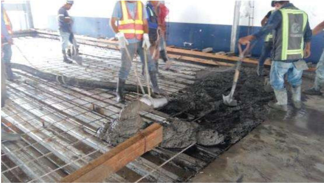
**Figura 35. Megamall, fundición losa.**
