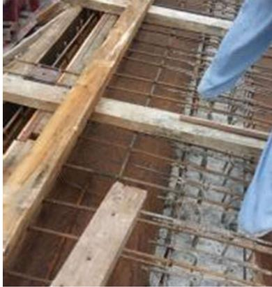
**Figura 22. Viga puente peatonal, armado losa.**
