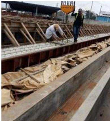
**Figura 10. Vigueta 16J, proceso para sacar elementos de bancada.**
