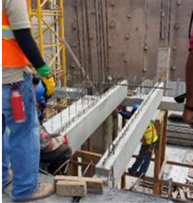
**Figura 18. Viguetas 16J, colocación final.**
