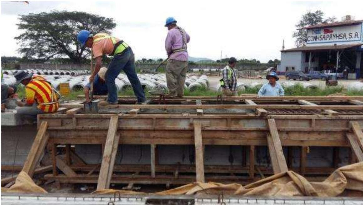
**Figura 26. Viga puente peatonal, colado de losa.**
