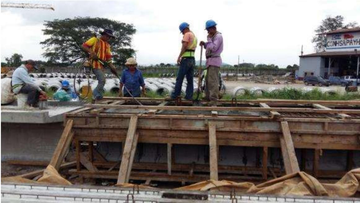
**Figura 27. Viga puente peatonal, vibrado de losa.**
