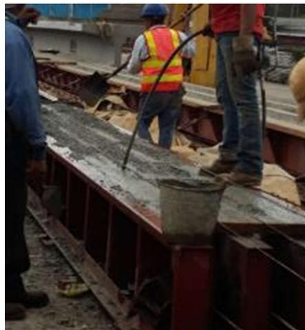
**Figura 4. Vigueta 16J, vibrado del elemento.**
