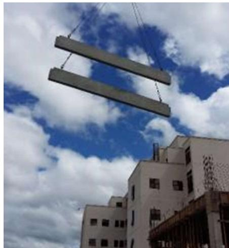
**Figura 15. Viguetas 16J, transporte de elementos con grúa.**
