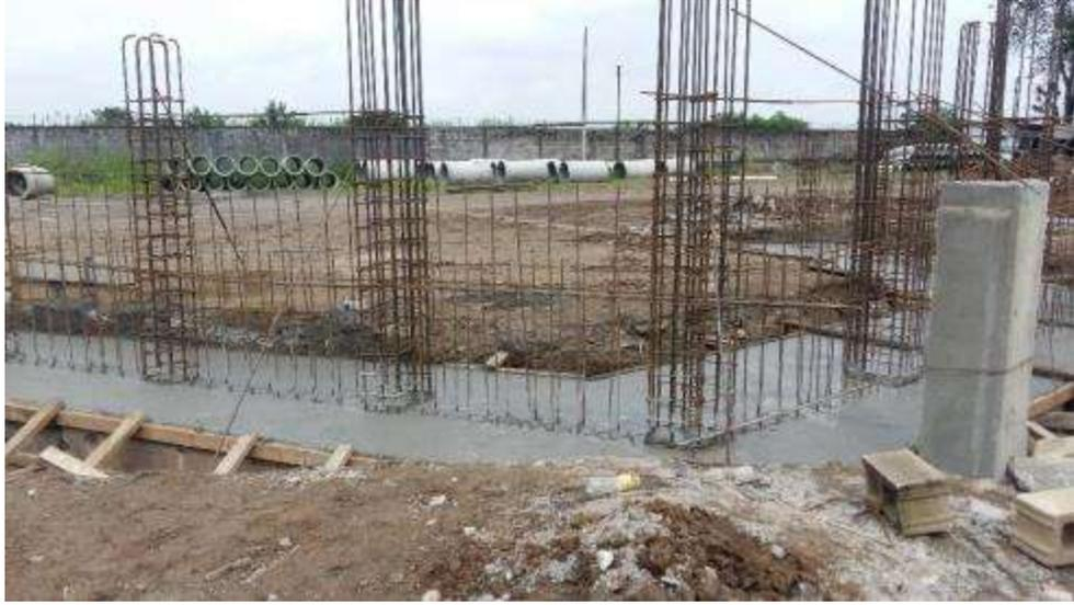
**Figura 31. Muro de contención de agregados.**
