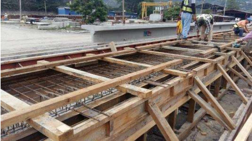
**Figura 25. Viga puente peatonal, armado y encofrado de losa.**
