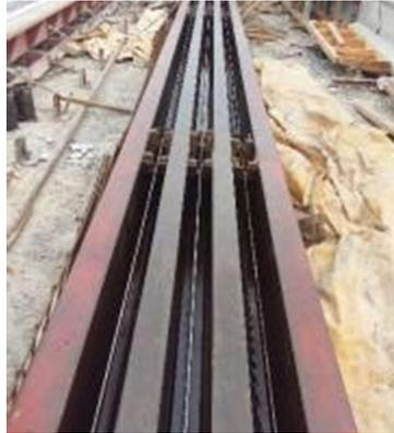
**Figura 2. Vigueta 16J, preinspección.**
