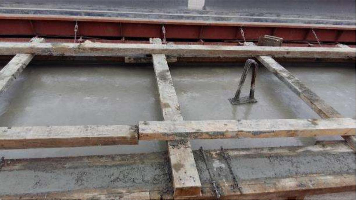
**Figura 29. Viga puente peatonal, gancho de levante.**
