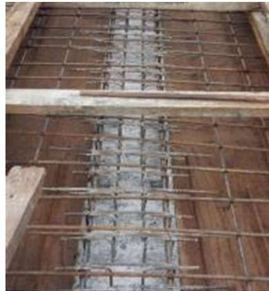
**Figura 23. Viga puente peatonal, revisión armado losa.**
