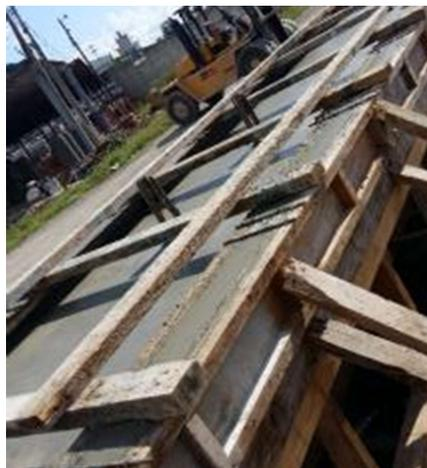
**Figura 30. Viga puente peatonal, fundición terminada.**
