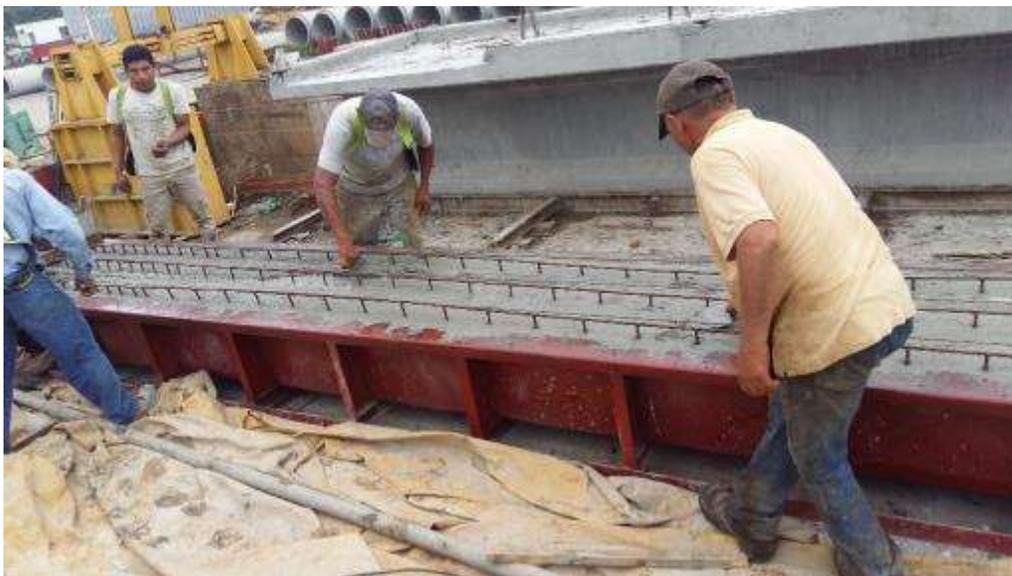
**Figura 6. Vigüeta 16J, acabado con cuchara y amarre del armado.**
