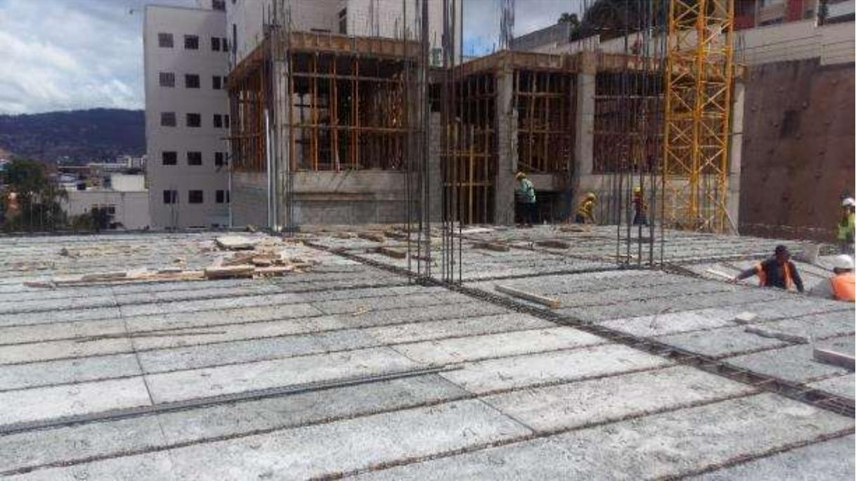
**Figura 45. Losas, colocación final.**
