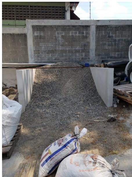
Figura 9 Banco de agregado grueso.
