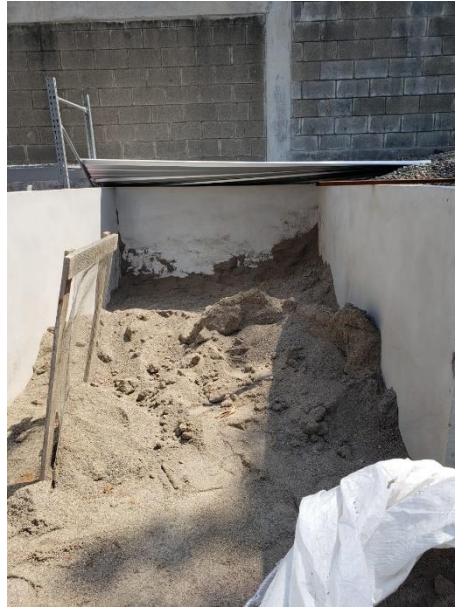
Figura 16 Banco de agregado fino
