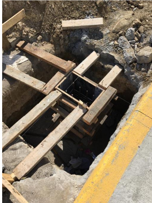
Figura 7. Encofrado del pedestal C-1 de el parqueo de motos
