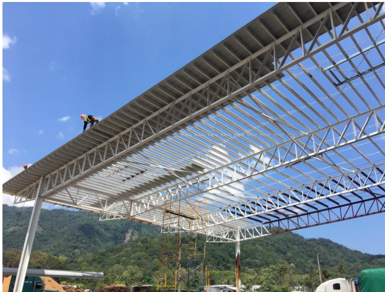
Figura 26. Montaje de láminas Aluzinc cal. 26 Biomasa
