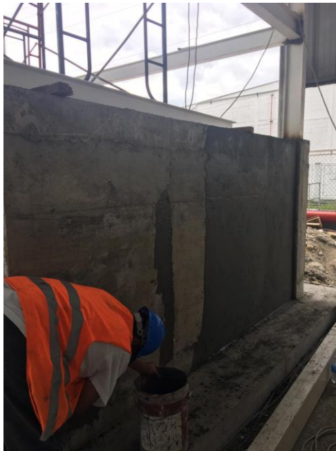
Figura 38. Repellado de las paredes del tanque en Heat Recovery
