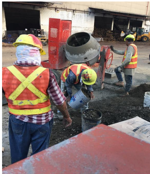
Figura 4. Fundido de la zapara B-1 en Biomasa
