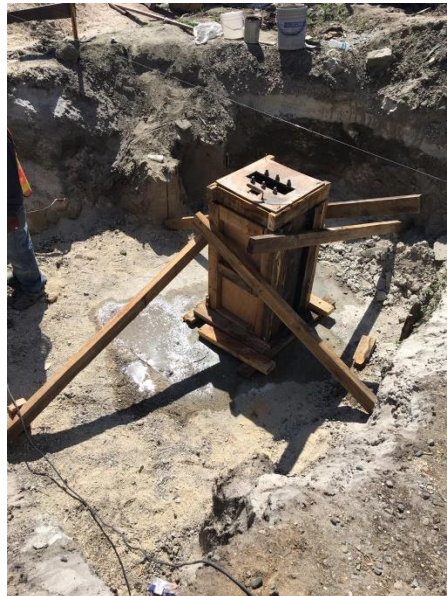
Figura 10. Encofrado para el pedestal ubicado en la zapata A-1 Biomasa
