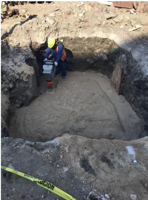
Figura 6. Compactado con bailarina de la zapata A-1 para encofrar
