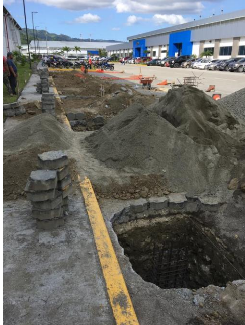
Figura 3. Vista del parqueo de motos con todo el material removido.
