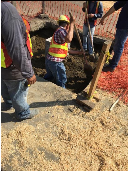
Figura 5. Distribución de material selecto en la zapata B-1 Biomasa
