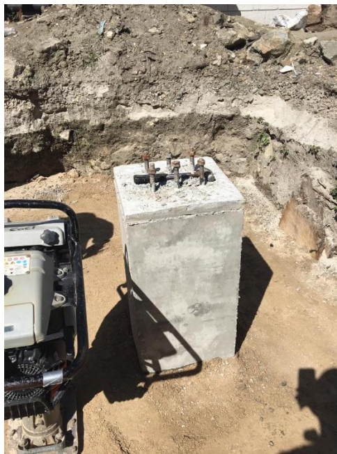
Figura 14. Desencofrado del pedestal Zapata A-1 Biomasa
