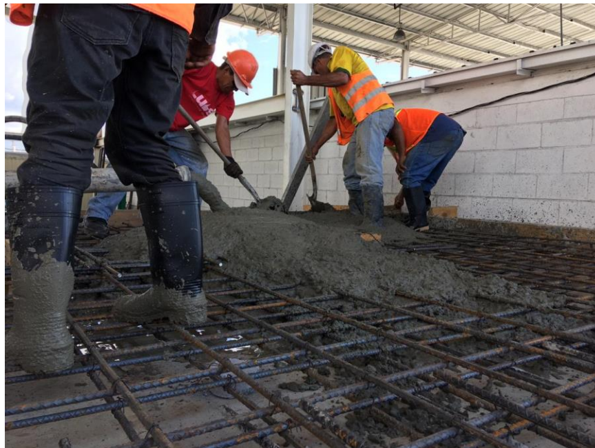
Figura 34. Vertido del concreto en Heat Recovery
