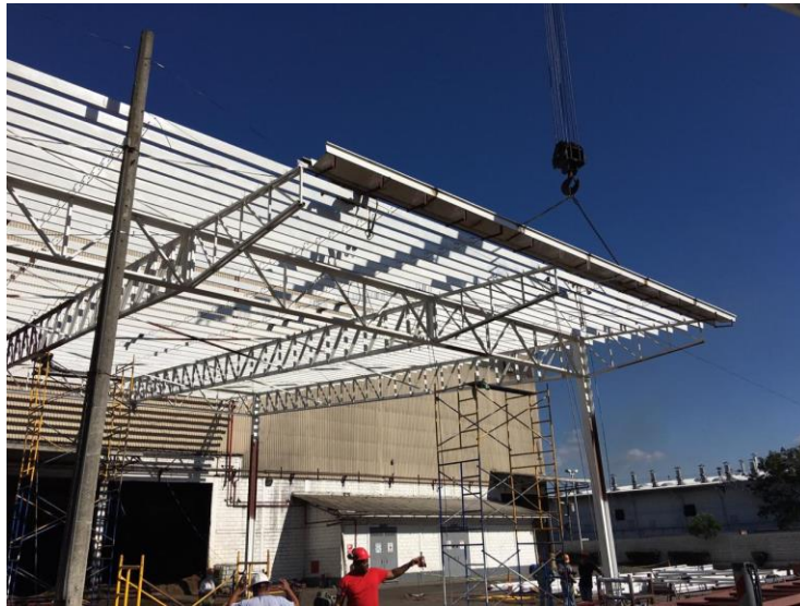
Figura 24. Instalación de canal de aguas lluvia Biomasa
