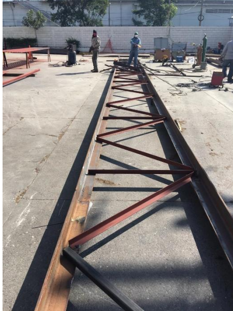
Figura 13. Joist-J1 de molde para los demás Joist Biomasa
