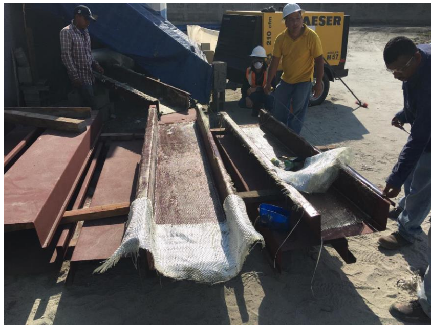
Figura 22. Pegado de la fibra de vidrio para protección del canal de aguas lluvia Biomasa
