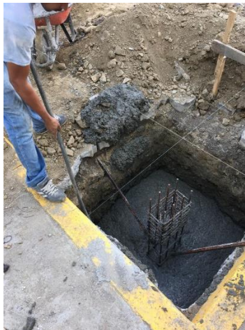
Figura 2. Vertido de concreto para la zapata A-1 en el parqueo de motos
