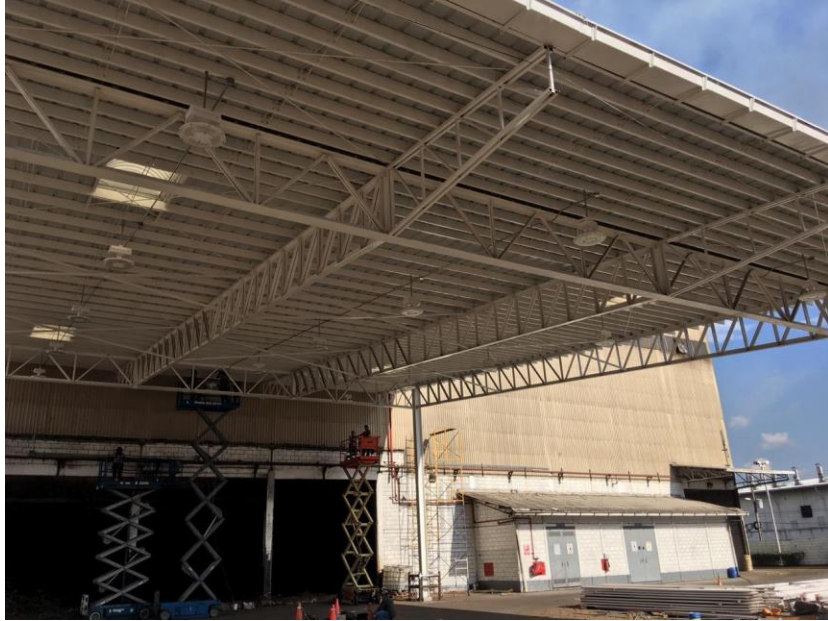
Figura 37. Instalación del sistema de iluminación Biomasa
