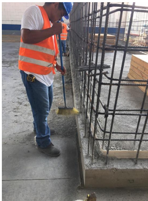
Figura 20. Preparación para empezar el encofrado del tanque.
