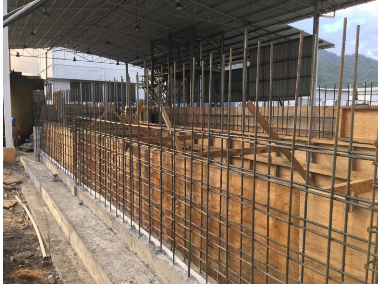
Figura 21. Encofrado para los muros del tanque
