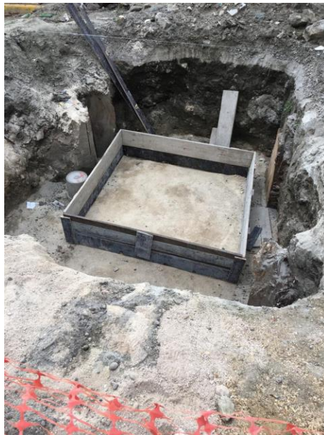
Figura 8. Encofrado para la zapata A-1
