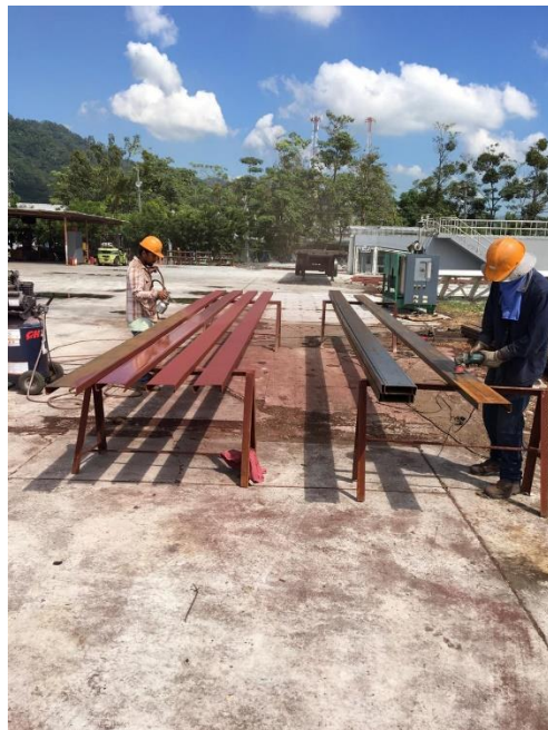
Figura 18. Pintado y pulido de canaletas Biomasa
