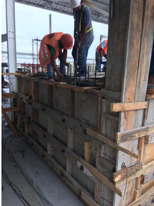
Figura 27. Vibrado mientras se funde las paredes de Heat Recovery
