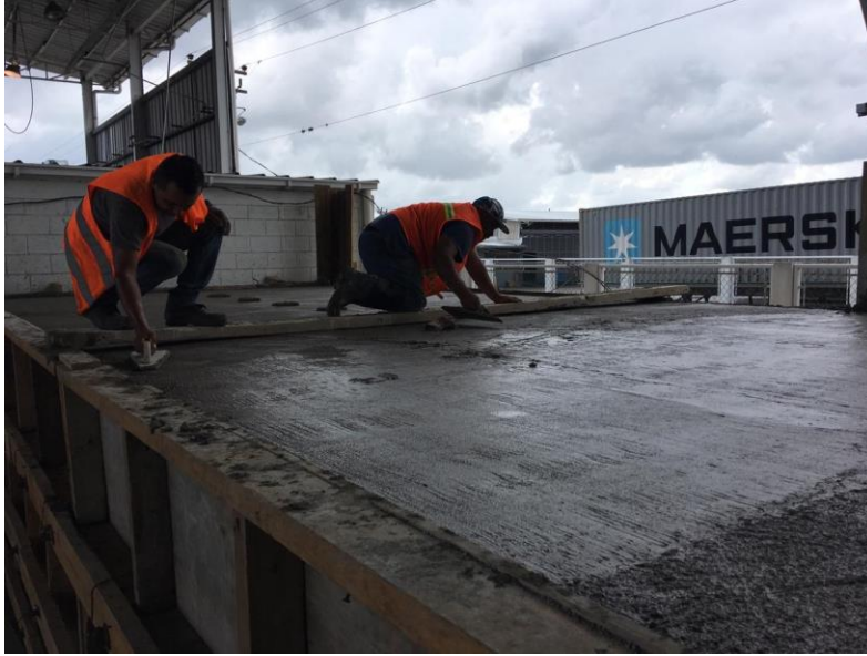
Figura 35. Enrasado de la losa sobre el tanque en Heat Recovery
