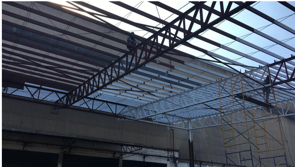
Figura 19. Pintado del techo en Biomasa con pintura blanca
