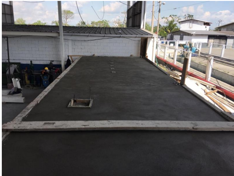
Figura 36. Losa sobre tanque Heat Recovery Terminado
