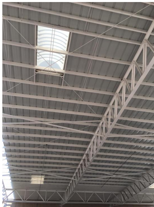
Figura 32. Instalación completa de Skylights Biomasa
