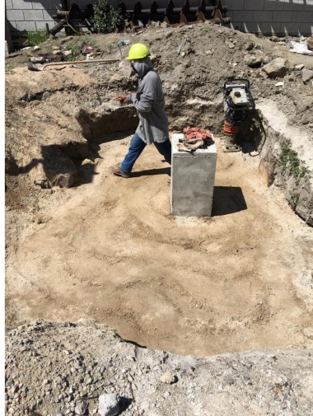
Figura 15. Compactado con bailarina sobre Zapata A-1 Biomasa
