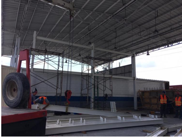
Figura 25. Instalación de las vigas en Heat Recovery
