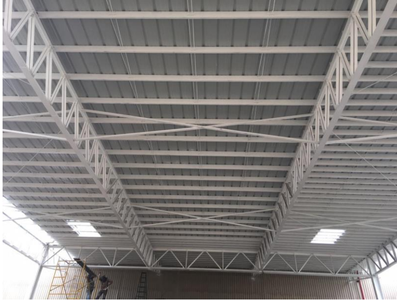
Figura 29. Foto del techo de Biomasa ya pintado
