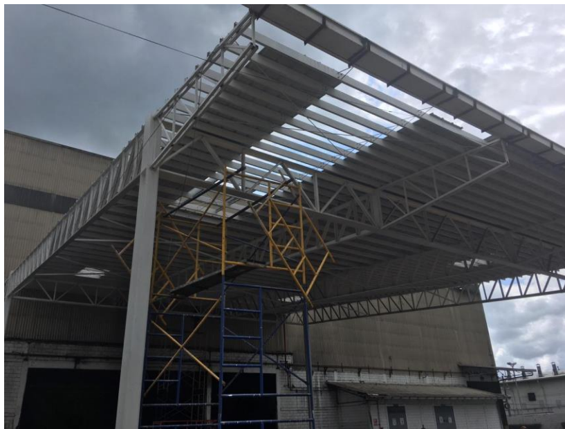
Figura 30. Último tramo a colocar láminas en Biomasa
