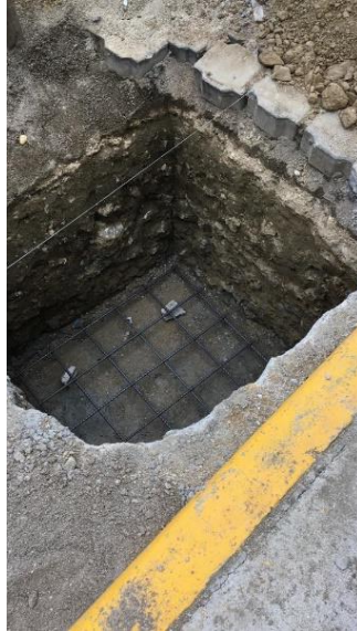
Figura 1. Colocación de Refuerzo para zapata A-1 en el parqueo de motos
