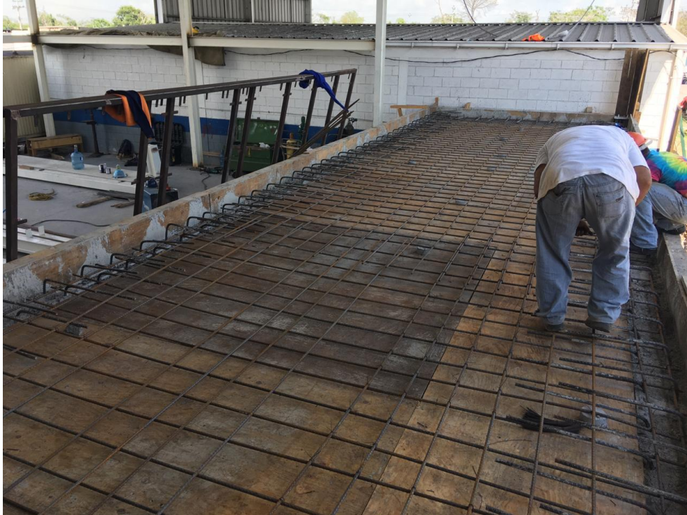
Figura 33. Armado del refuerzo para Heat Recovery
