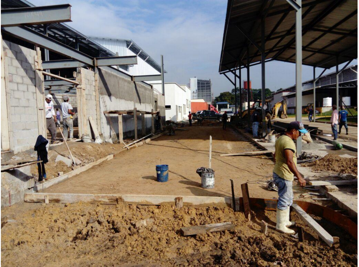
Ilustración#4. Oficinas Administrativas de dos niveles y pavimentación de parqueo.
