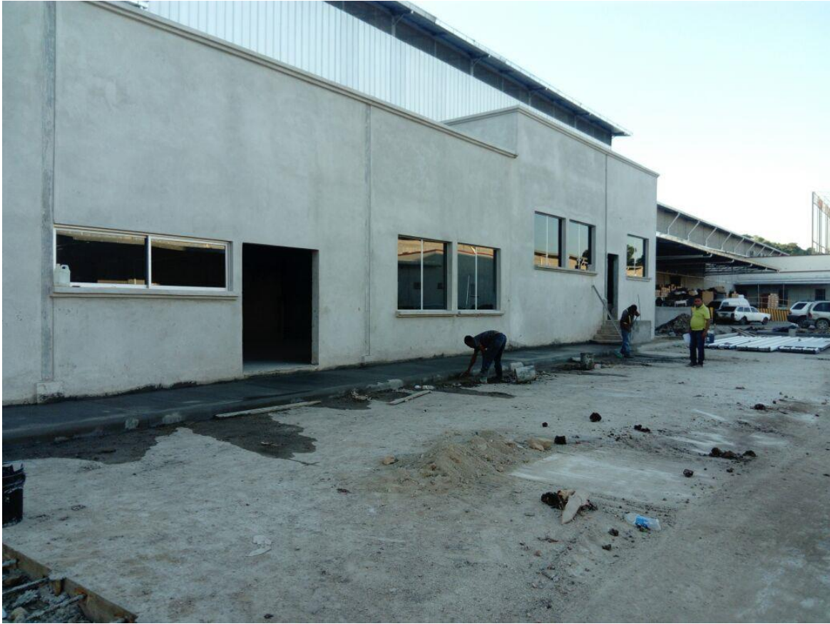
Ilustracion#3. Cafeteria y Oficinas de Bodegas terminadas en un 95%.
