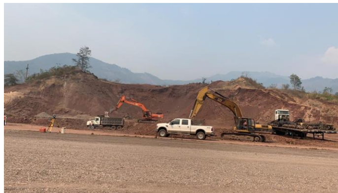
Ilustración 37. Supervisión de movimiento de tierra en el plantel
