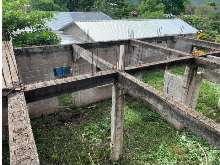
Ilustración 47. Levantamiento de vivienda parte 2.
