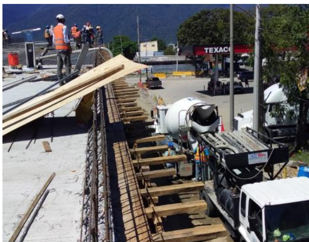
Ilustración 44-Colado de losa 29m 3 de concreto 4000 psi
