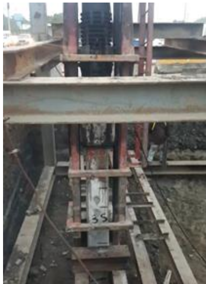
Ilustración 17-Hincado de pilote en el puente del intercambiador de la 27 calle SPS
