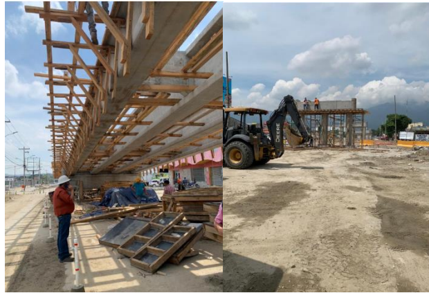
Ilustración 34-Fotografía de evidencia de inspección día 1
