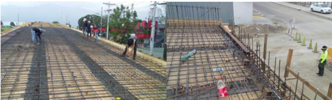
Ilustración 39-Revisión de encofrado para el tramo 2 del puente.
