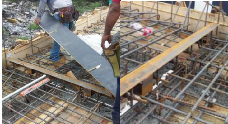
Ilustración 42-Colocación del ángulo para las juntas de losas
