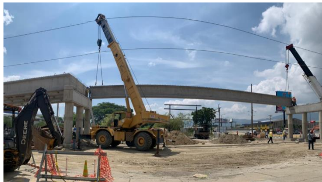
Ilustración 37-Vigas 1 colocada en el proyecto de las segunda calle.
