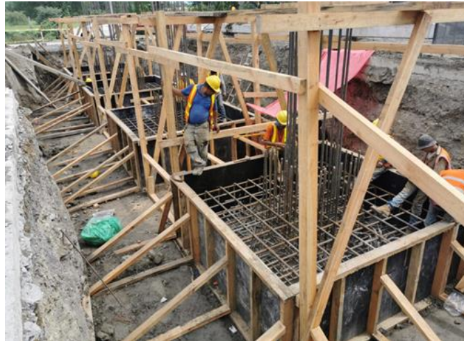
Ilustración 13-Ejemplo de excavación estructural para las zapatas del puente de la 27 calle
