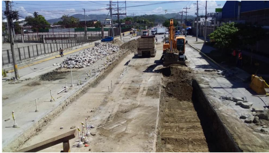
Ilustración 48-Estabilización del suelo con suelo cemento.
