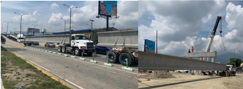
Ilustración 36-Entrega y colocación de vigas para el proyecto de la 2da calle.
