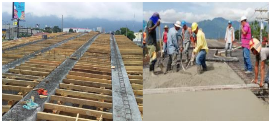
Ilustración 43-Izquierda. Encofrado de losa de fondo. Derecha. Fundición de losa
