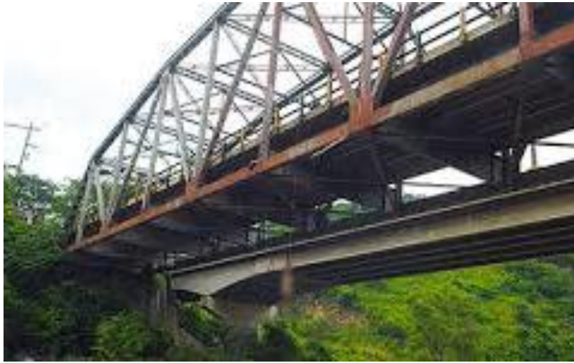
Ilustración 3-Puente de Armadura en Chamelecón, SPS
