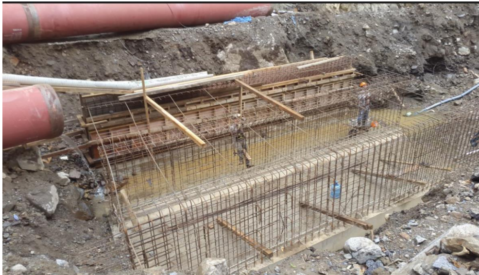
Ilustración 8. Armado de acero caja puente portal de salida
