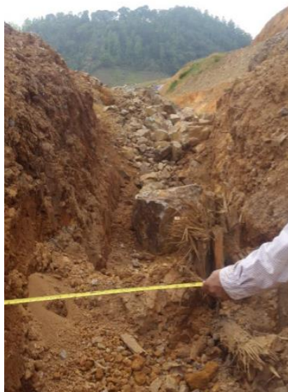
Ilustración 12. Filtro lateral del talud
