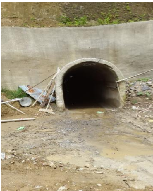
Ilustración 9. Túnel de 510 metros de longitud
