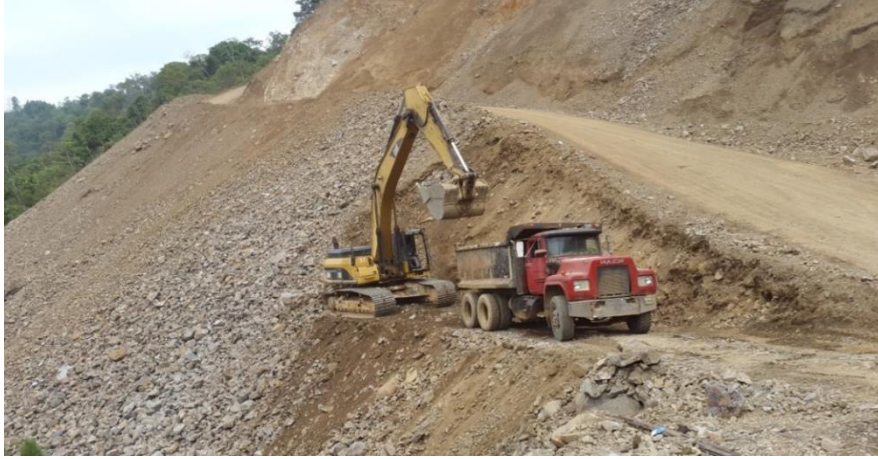
Ilustración 13. Acarreo de material grueso.
