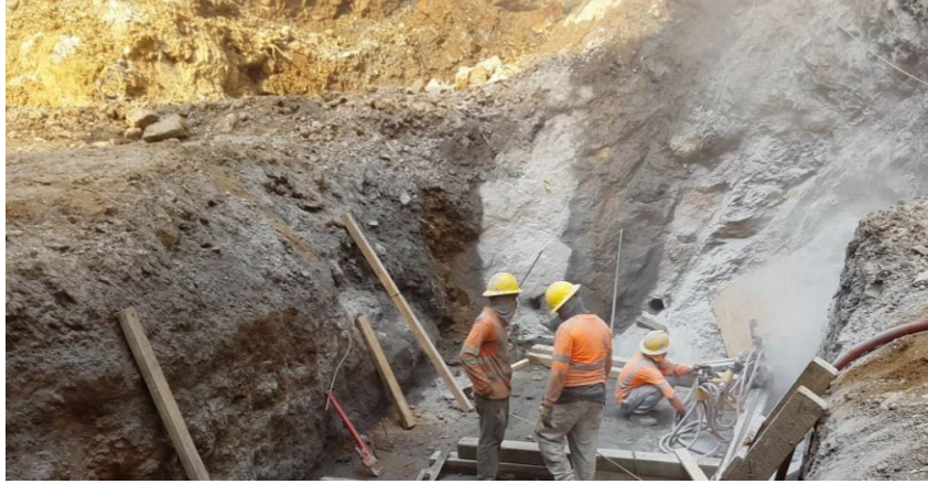
Ilustración 16, Perforación anclajes PI 7
