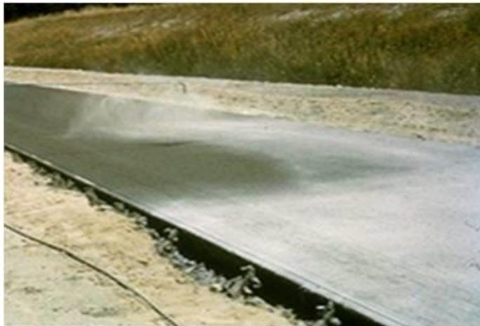
**Ilustración 5. Curado de Concreto Pigmentado**
