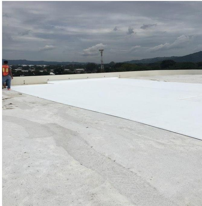
**Ilustración 20. Membrana TPO.**
