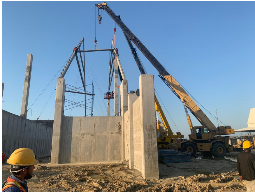
Figura 9. Montaje de marcos metálicos.
