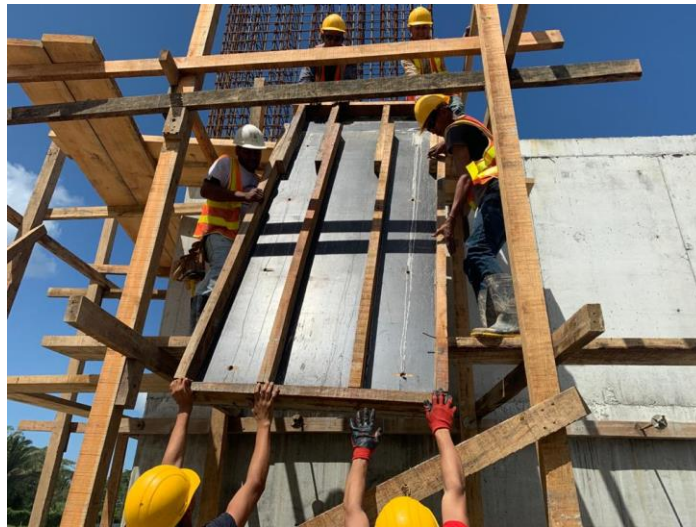
Figura 5. Tableros de lámina HBO para encofrado de muros.
