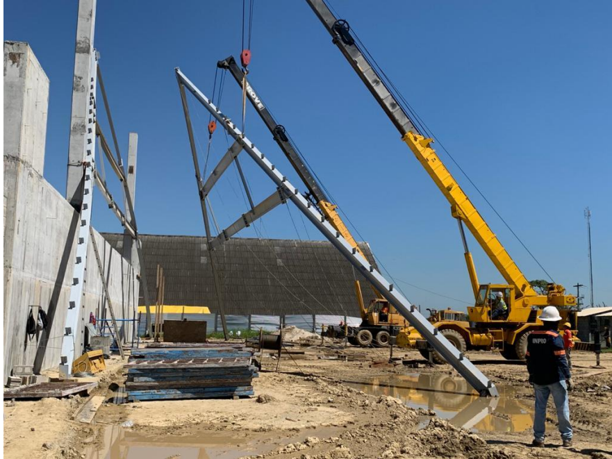
Figura 8. Montaje de marcos metálicos.
