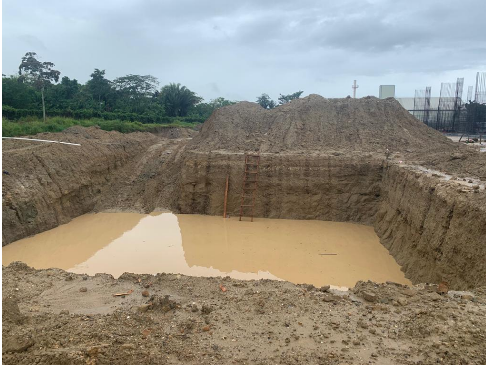
Figura 2. Cimentación de la torre de Mezclado.
