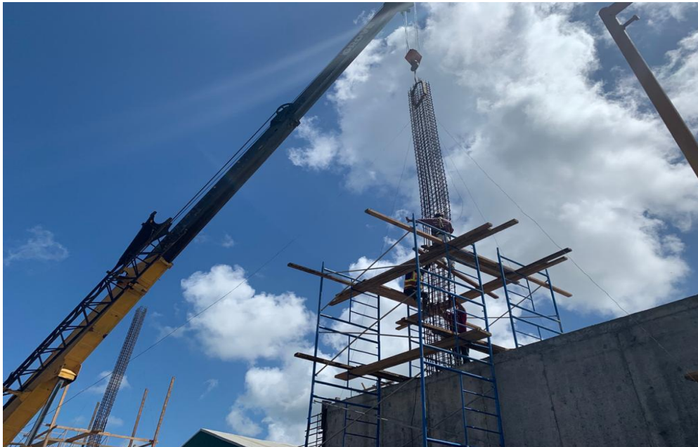
Figura 3. Colocación de armado de acero de la columna C-3 en el eje B.
