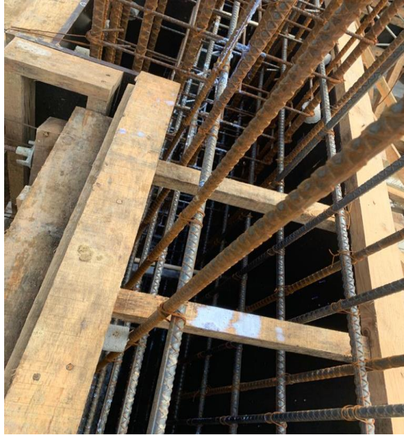
Figura 6. Encofrado y Armado de muros listos para fundir.
