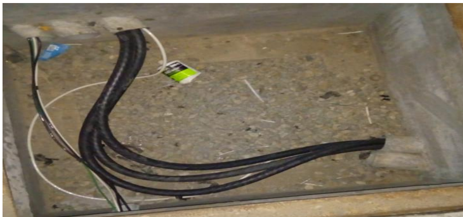
FIGURA 11. CABLE XLP (ALTA TENSIÓN SUBTERRÁNEA).
