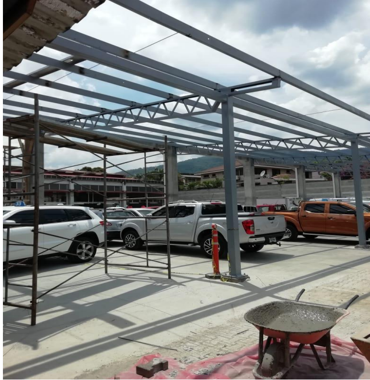
FIGURA 10. NAVE DE TALLERES GRUPO Q.
