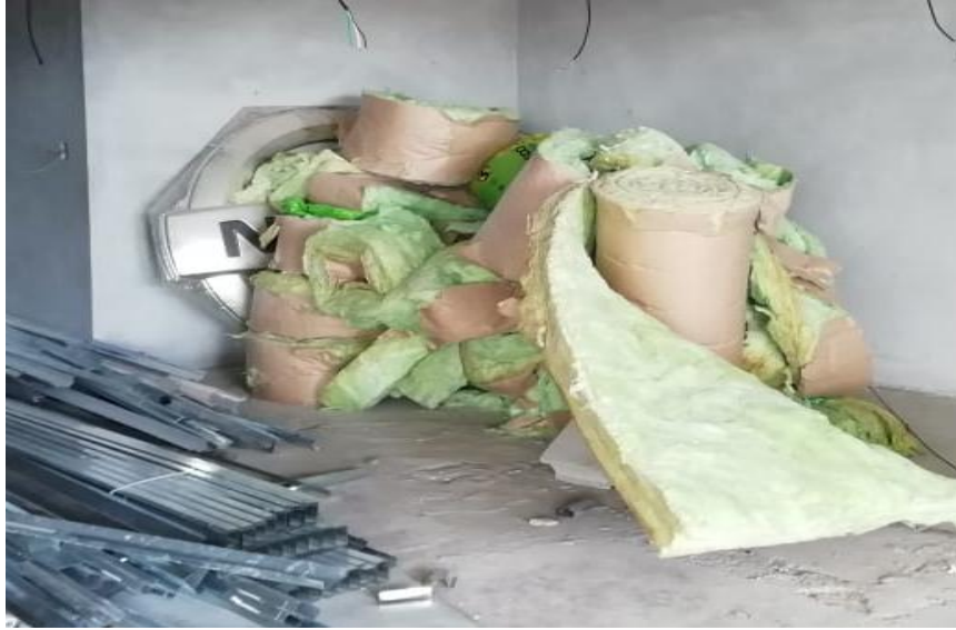
FIGURA 18. AISLANTE DE CALOR COLOCANDO EN EL CIELO FALSO DEL SHOWROOM.
