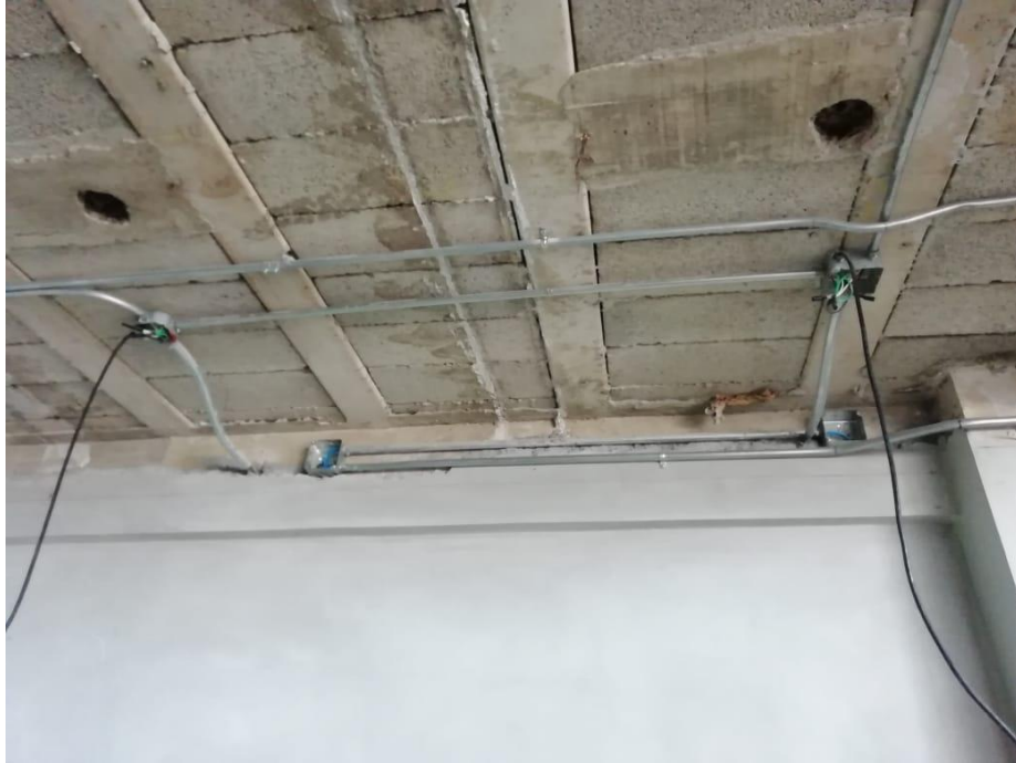
FIGURA 16. INSTALACIÓN DE TUBERÍA Y CAJAS ELÉCTRICAS.
