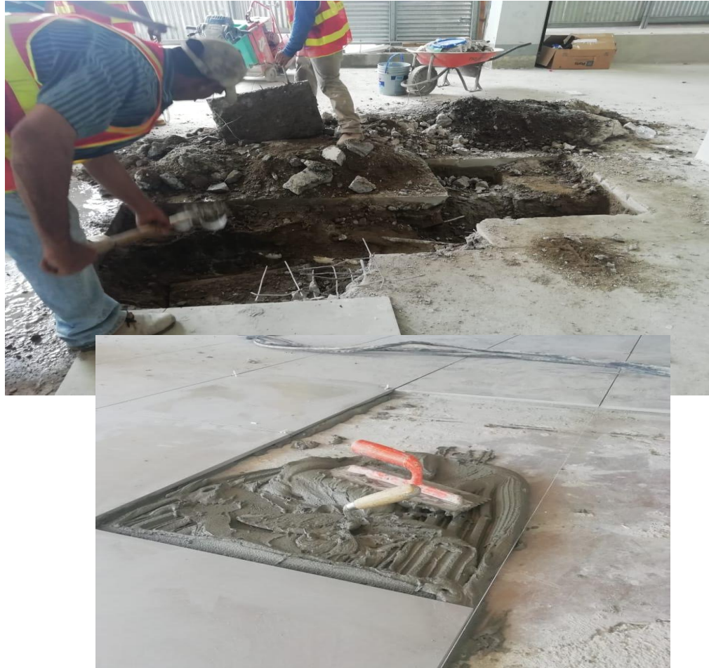
FIGURA 7. COLOCACIÓN DEL PORCELANATO EN EL ÁREA DEL SHOWROOM.
