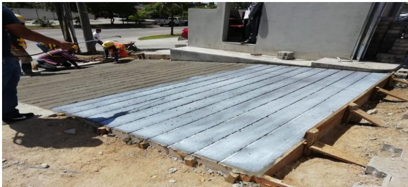
FIGURA 1. APLICACIÓN DE CURADOR EN RAMPA DE ACCESO PRINCIPAL AL EDIFICIO.
