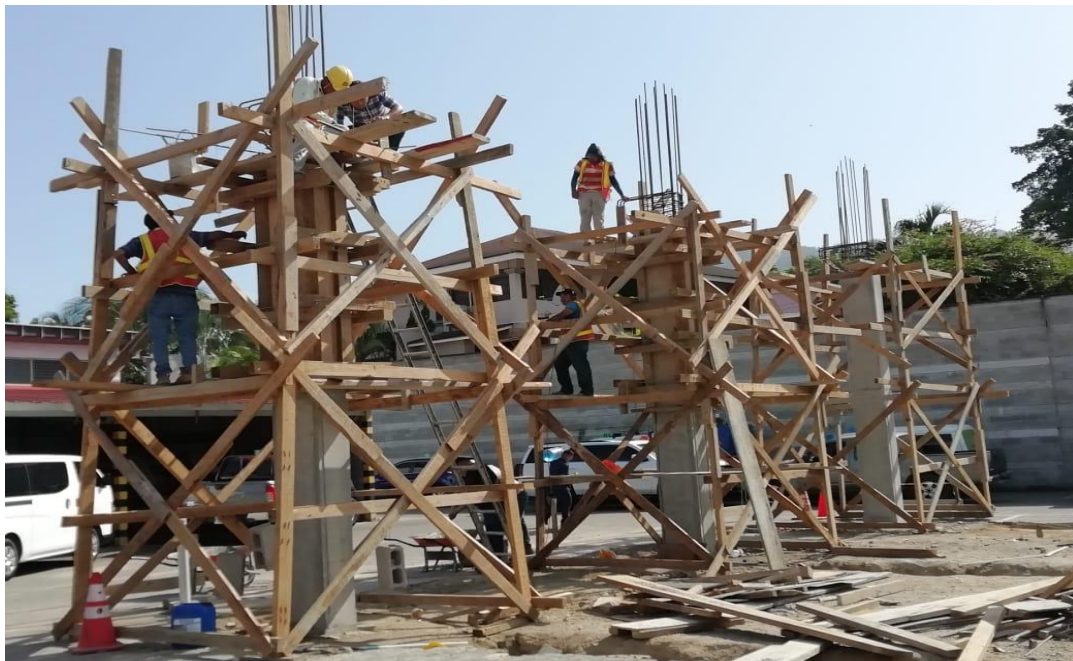
FIGURA 21. ENCOFRADO DE LAS COLUMNAS DE CONCRETO PARA LA NAVE DE TALLER.
