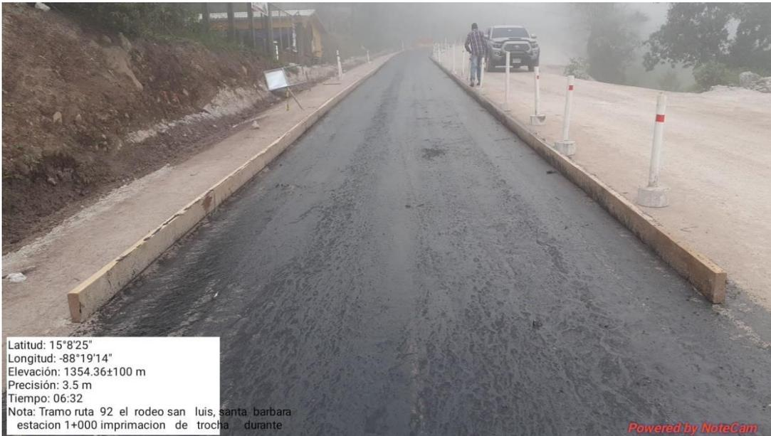
**Ilustración 7. Imprimación MC\_70**
