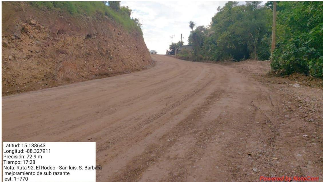
**Ilustración 14. Corte de talud finalizado**
