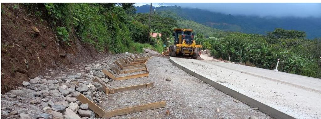
**Ilustración 28. Encofrado para cuneta tipo "V"**
