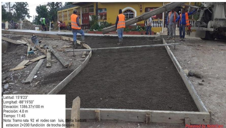
**Ilustración 30. Colocación de concreto en acceso**
