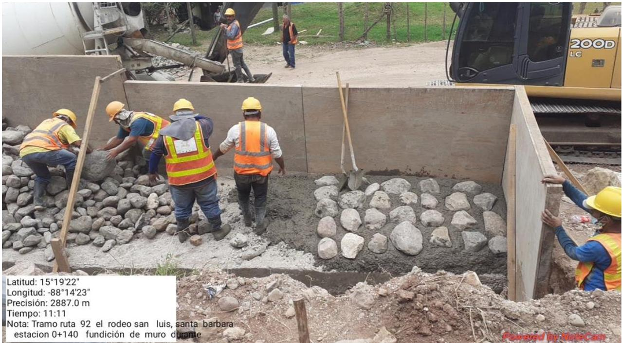
**Ilustración 47. Fundición en muro de contención**
