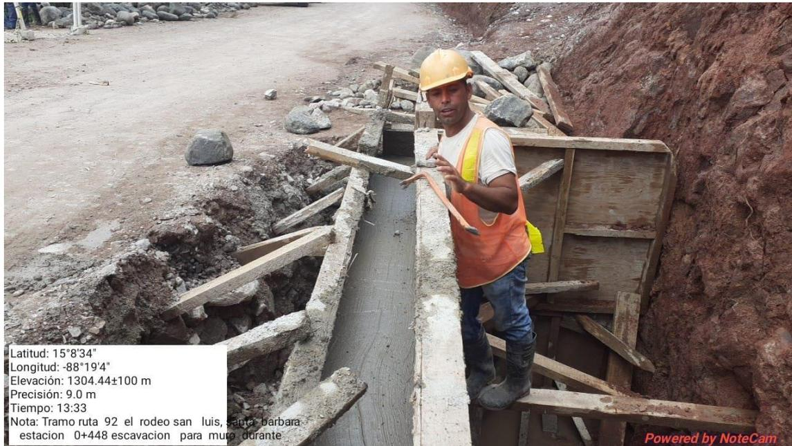
**Ilustración 23. Muro cabezal tipo "L"**
