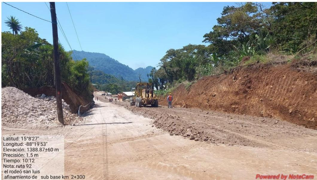
**Ilustración 19. Colocación de subbase**
