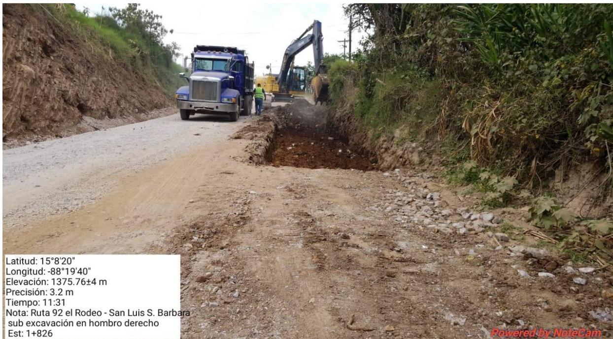
**Ilustración 48. Sub excavación de hombros**
