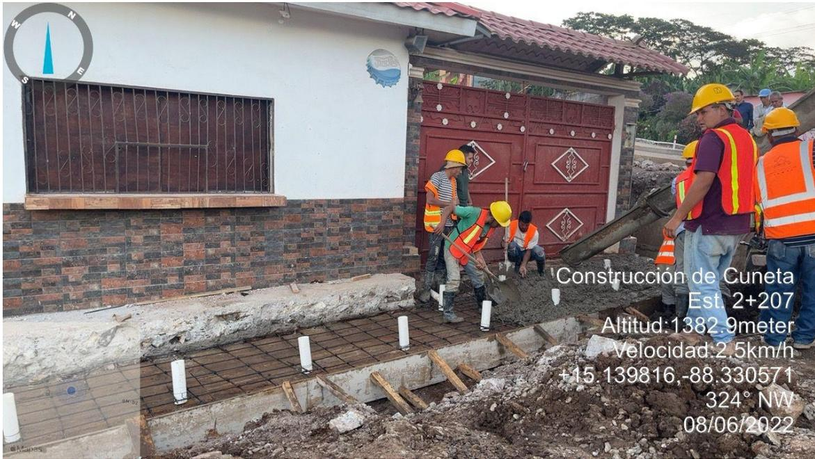
**Ilustración 37. Colado de concreto en acceso**
