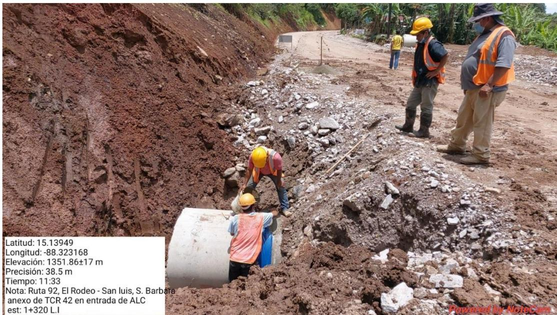
**Ilustración 25. Colocación de TCR 36"**
