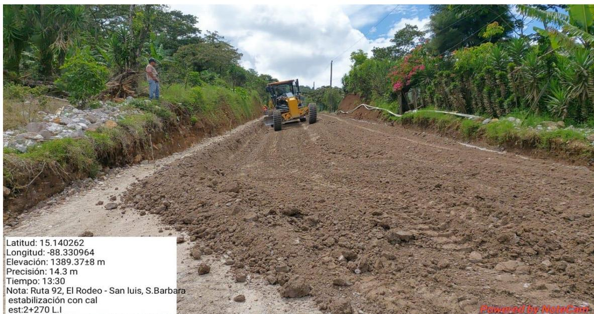
**Ilustración 27. Estabilización con cal**
