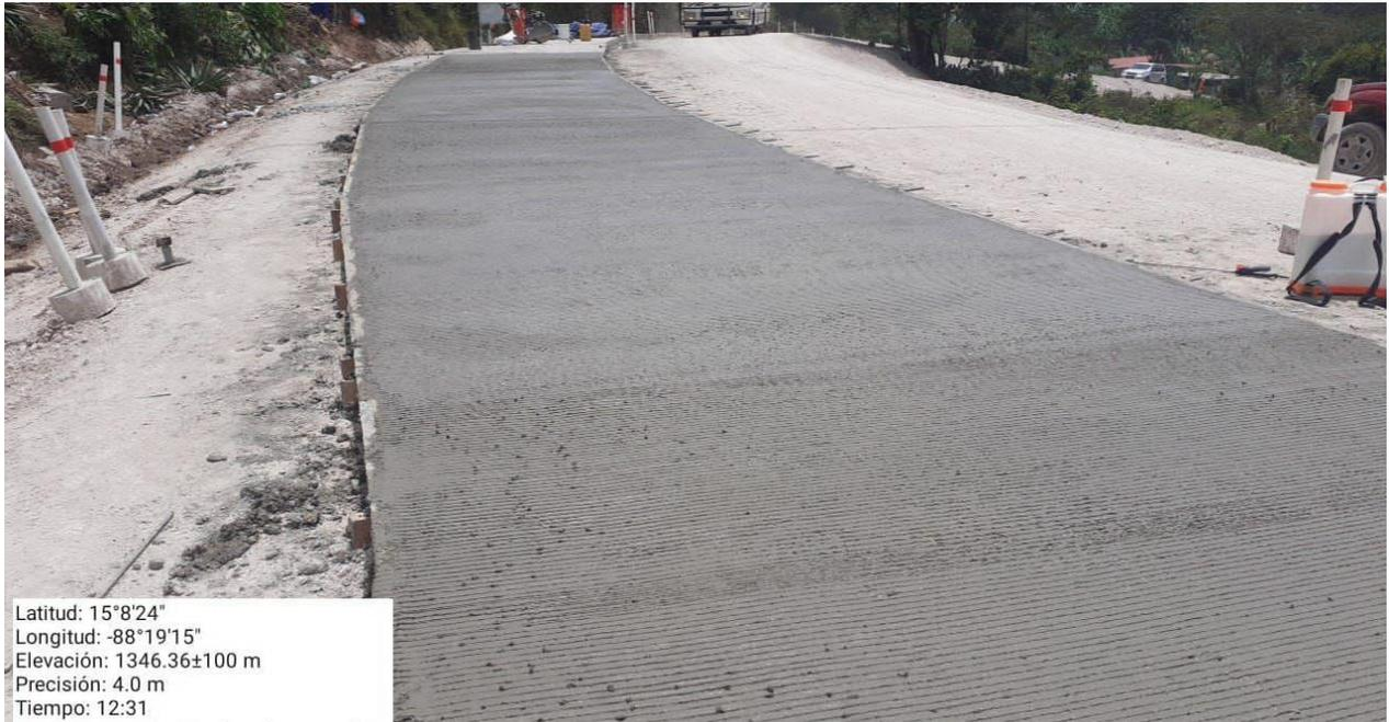
**Ilustración 46. Fundición de concreto para carretera**
