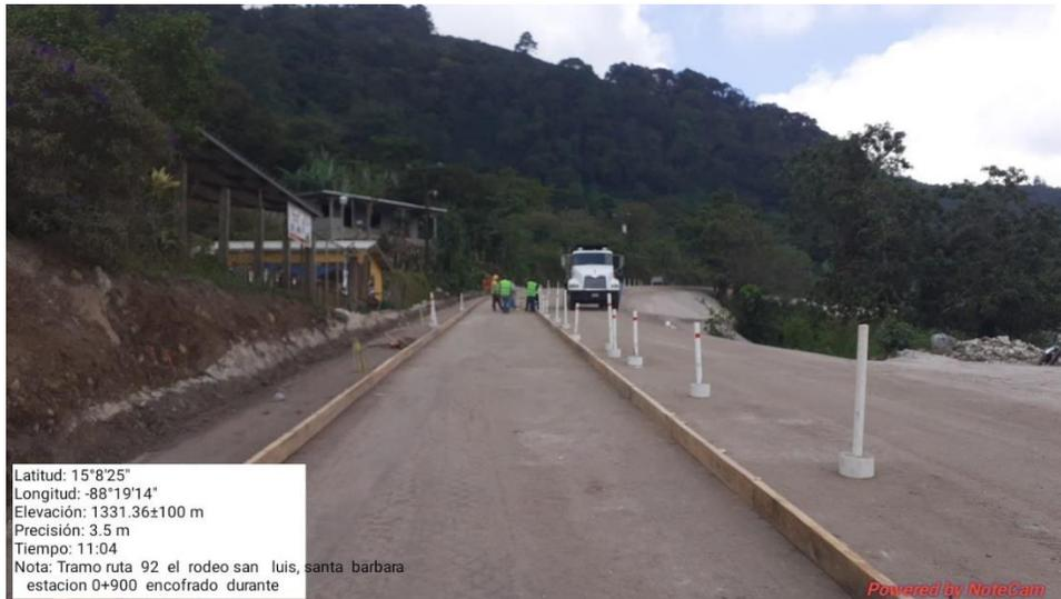
**Ilustración 6. Encofrado previo al colado**
