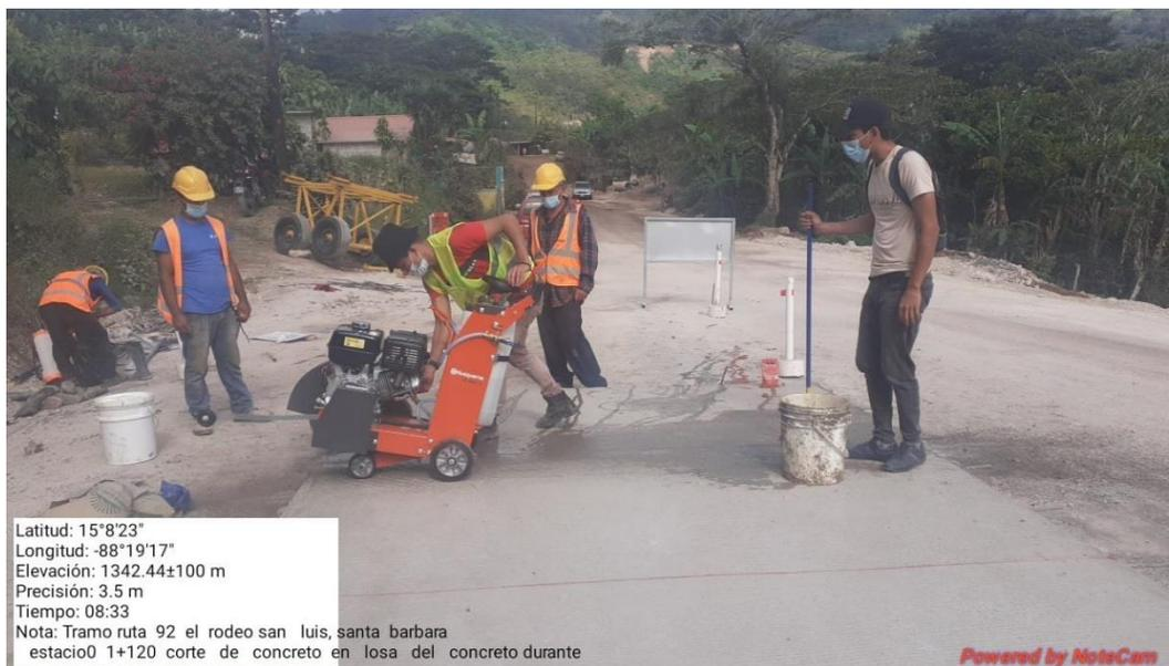
**Ilustración 10. Cortes transversales**
