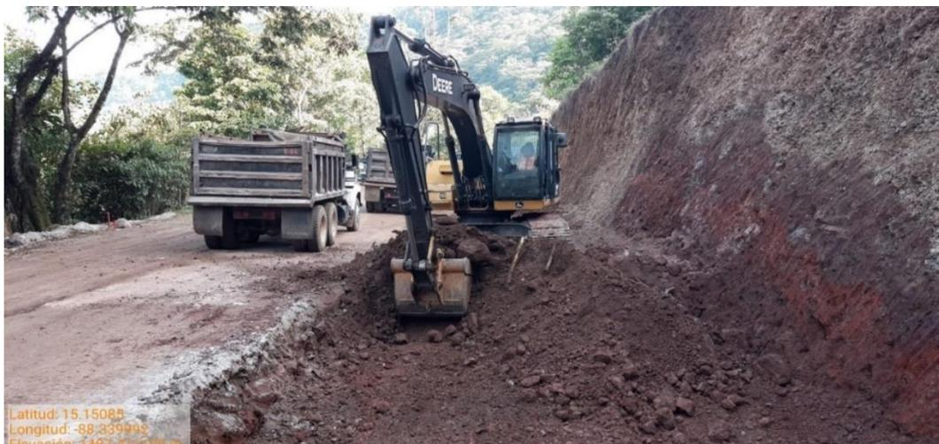
**Ilustración 16. Subexcavaciones en el lado derecho**
