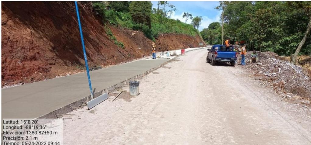
**Ilustración 29. Colocación de concreto**
