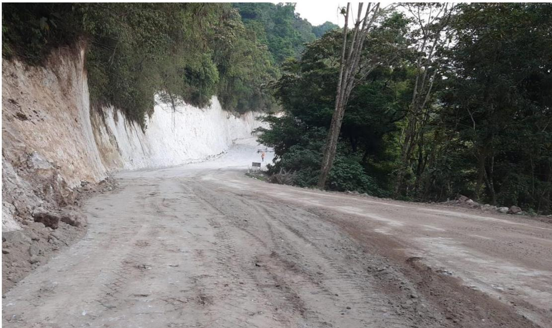
**Ilustración 15. Corte de talud finalizado**
