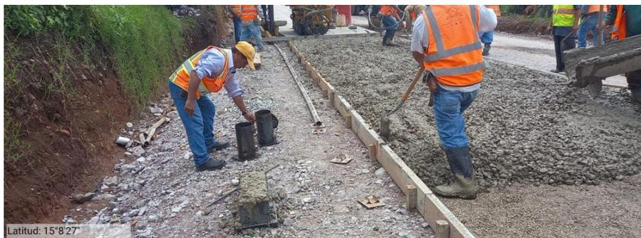
**Ilustración 32. Elaboración de cilindros para ensayo**
