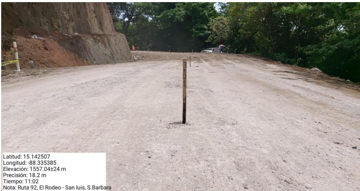
**Ilustración 26. Marcaje para nivelación de subrasante**
