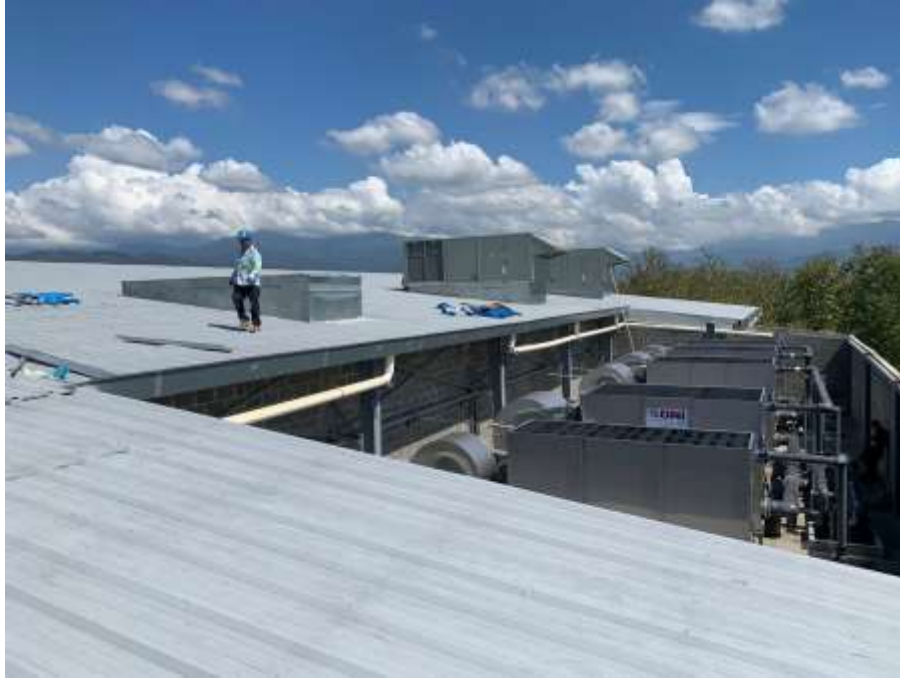
Ilustración 81 – Mezzanine del techo de COFICAB
