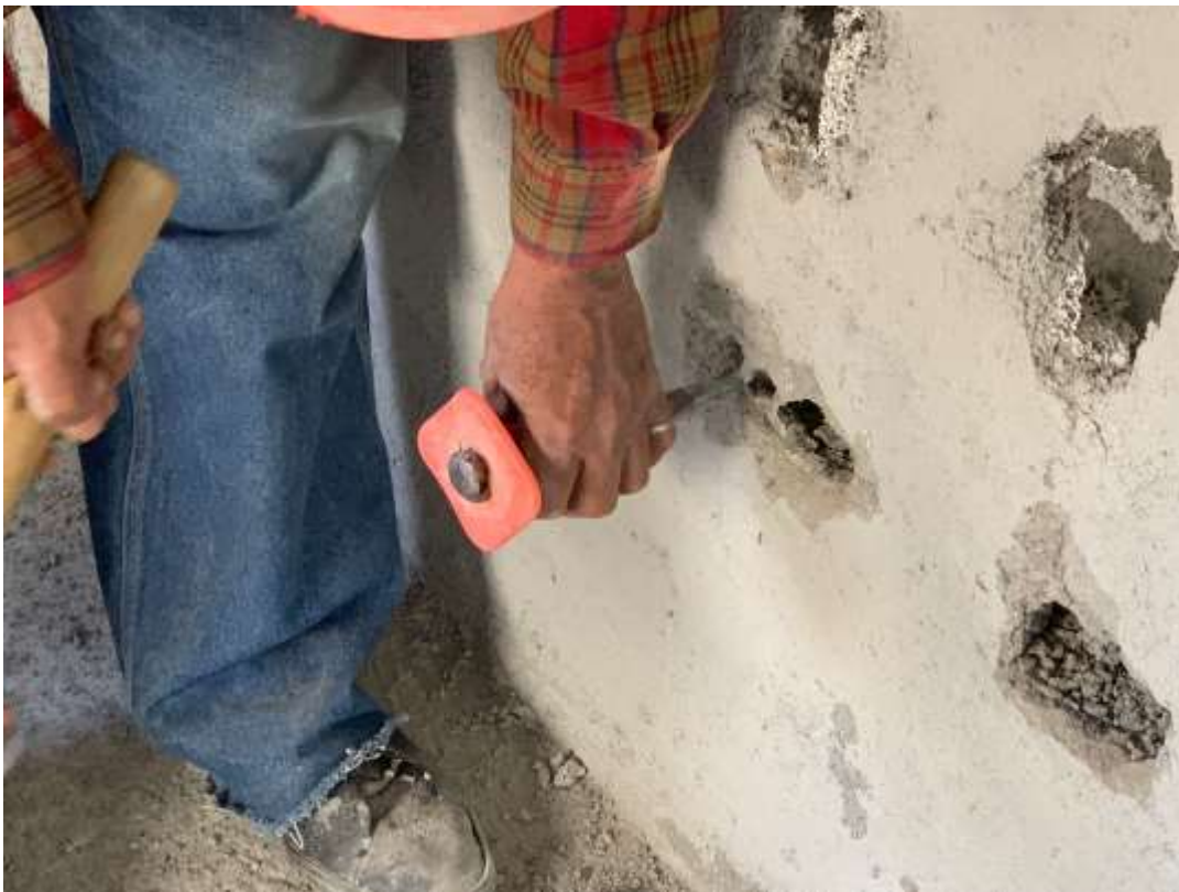
Ilustración 28 – Picado de las paredes pulidas con cincel y martillo
