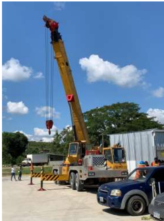
Ilustración 20 – Grúa marca Grove anclada al pavimento
