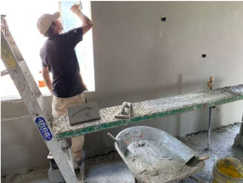
Ilustración 22 – Proceso de pulido y tallado de paredes repelladas
