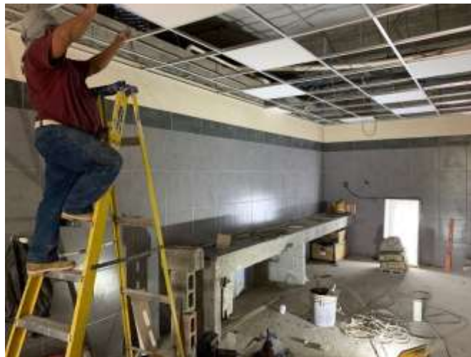
Ilustración 46 – Posicionamiento del techo de fibra mineral
