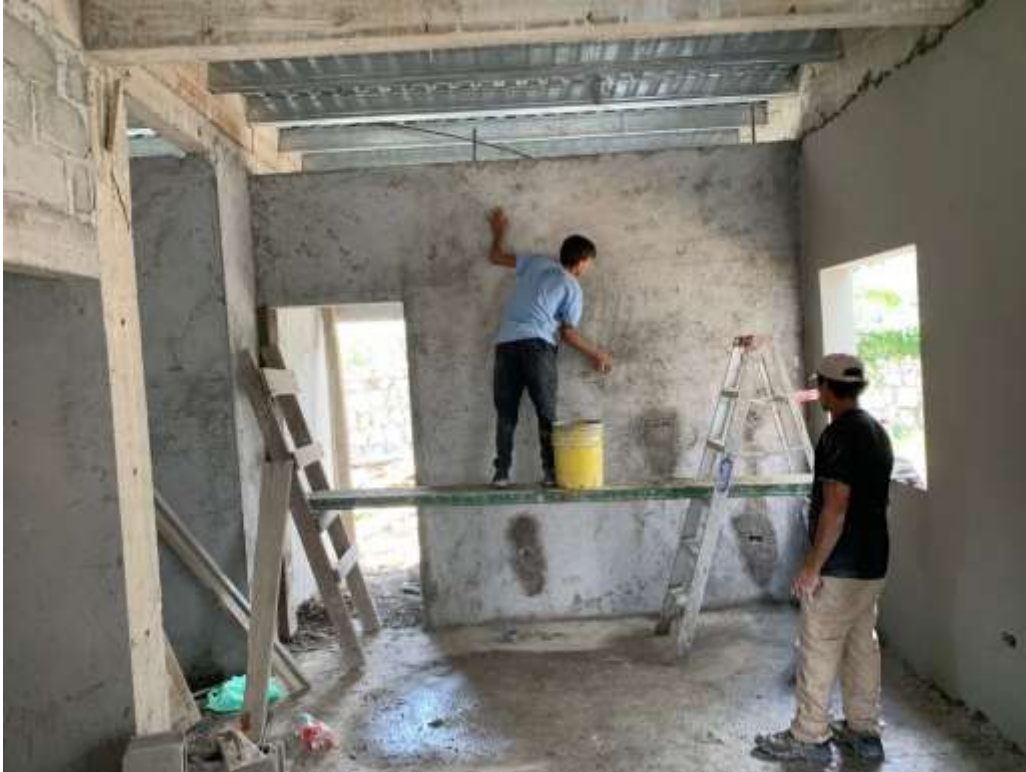
Ilustración 29 – Preparación de la pared previo a su pulido
