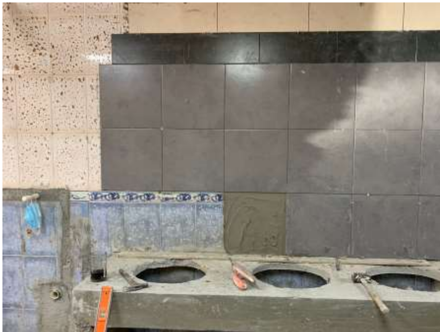
Ilustración 35 – Posicionamiento de las cerámicas en las paredes de los baños
