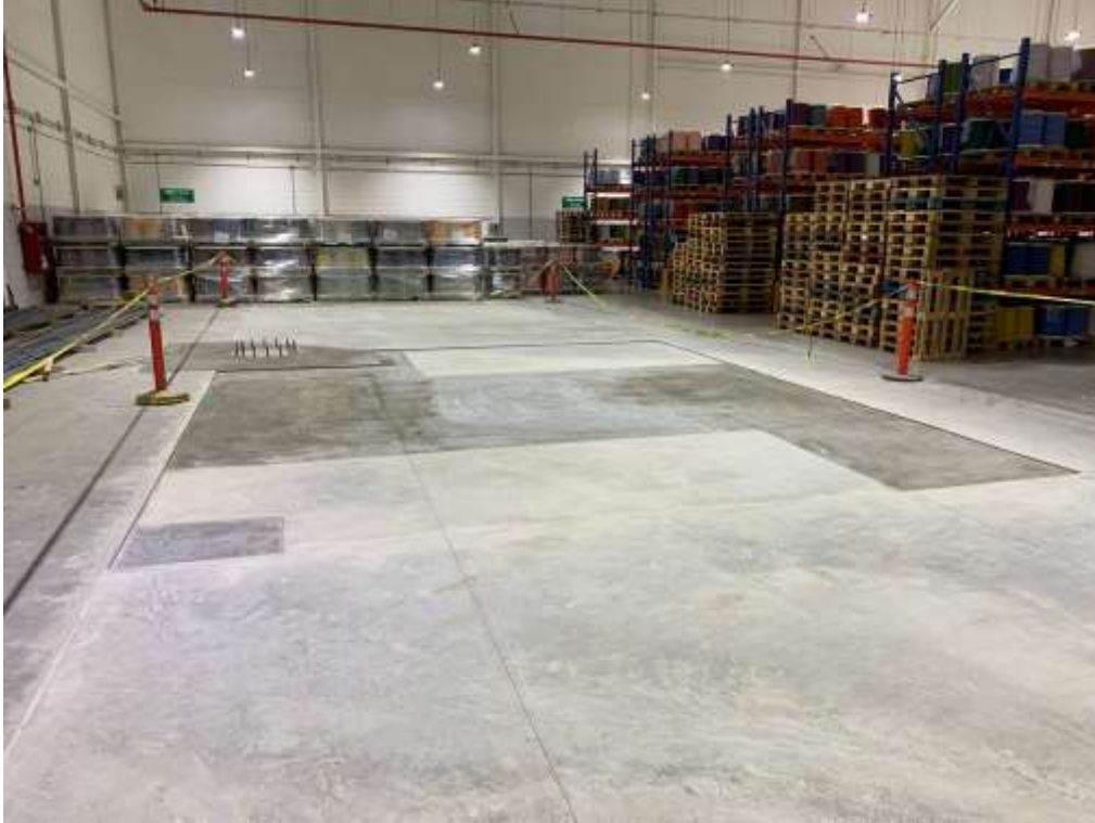
Ilustración 48 – Losa de COFICAB finalizada
