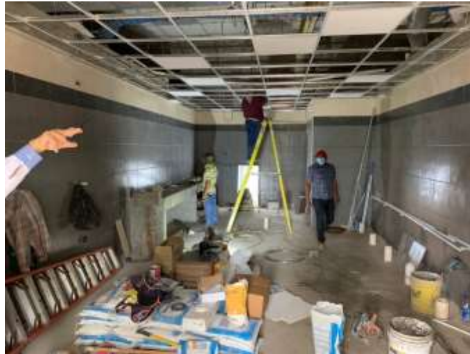
Ilustración 45 – Avance en los baños de Lear, Naco
