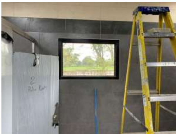
Ilustración 63 – Boquete sellado con un marco de aluminio
