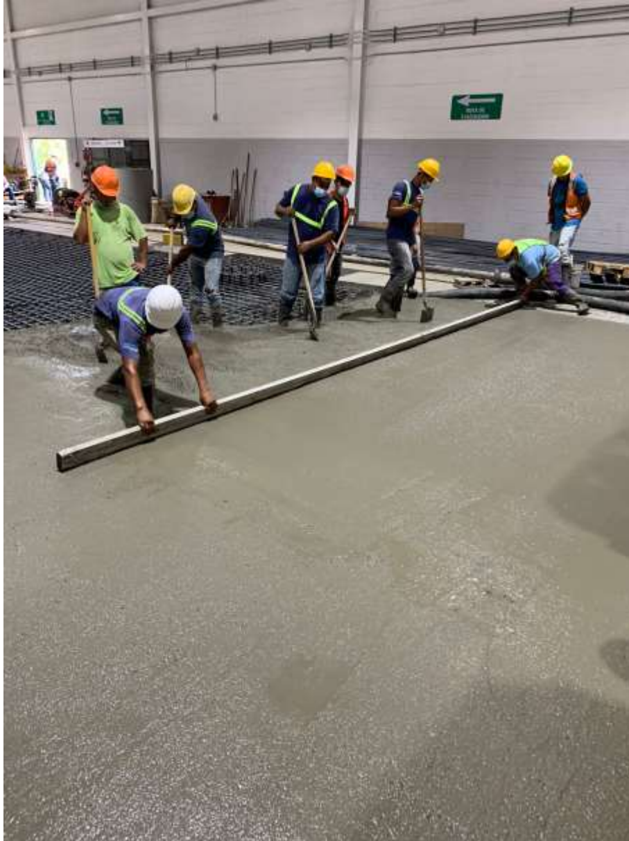
Ilustración 38 – Nivelación de la losa con rastra de aluminio
