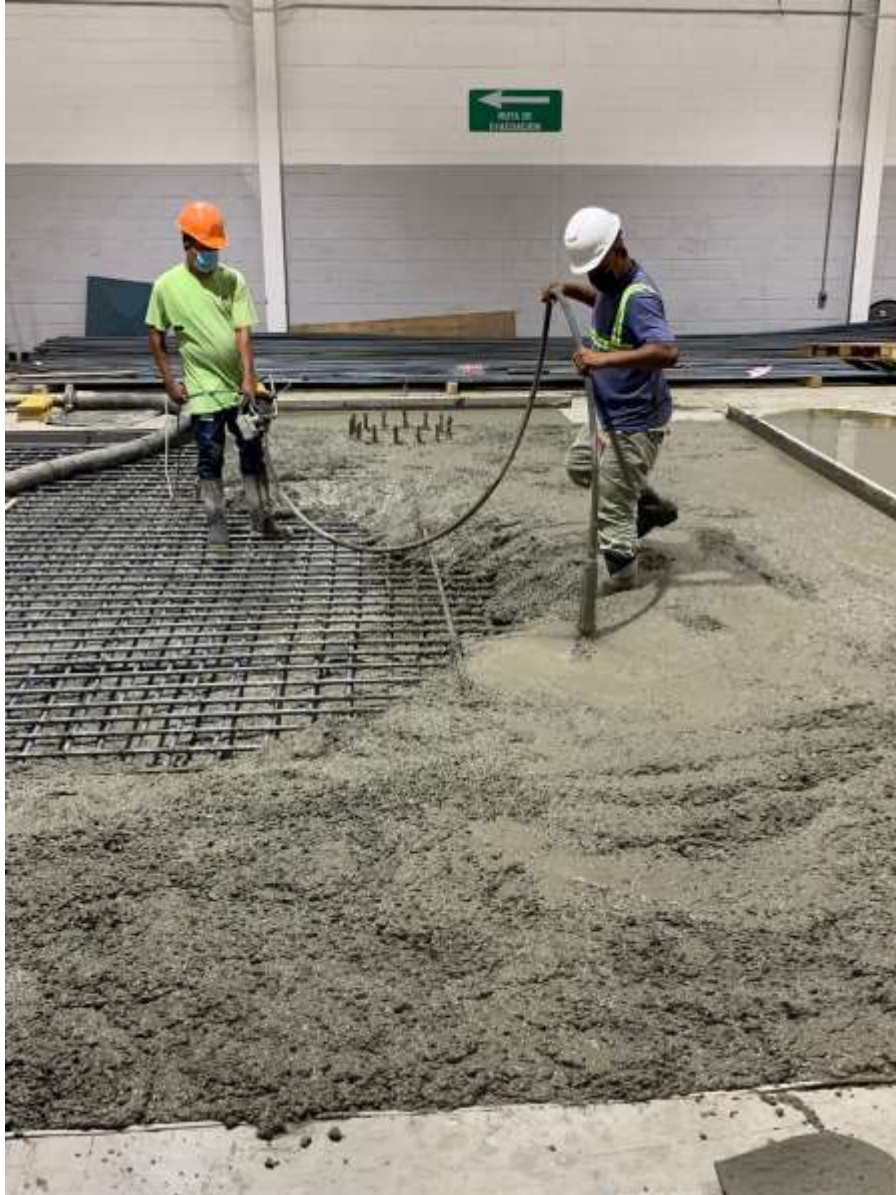
Ilustración 37 – Vibrado del concreto con maquina
