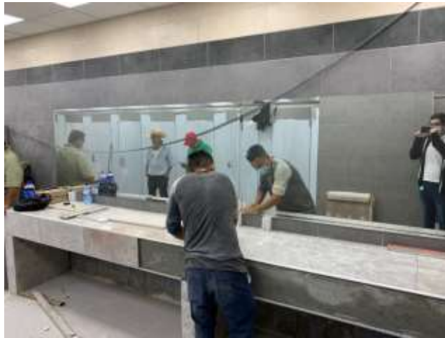
Ilustración 62 – Instalación del espejo en el baño de hombres
