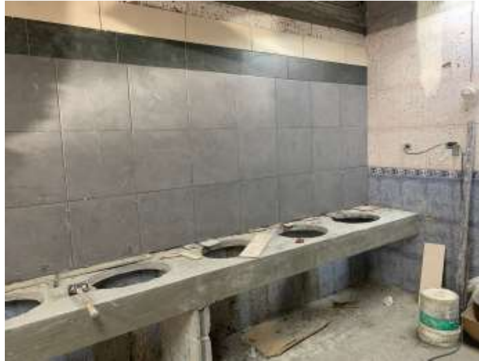
Ilustración 39 – Cerámica en pared izquierda (baño de LEAR)
