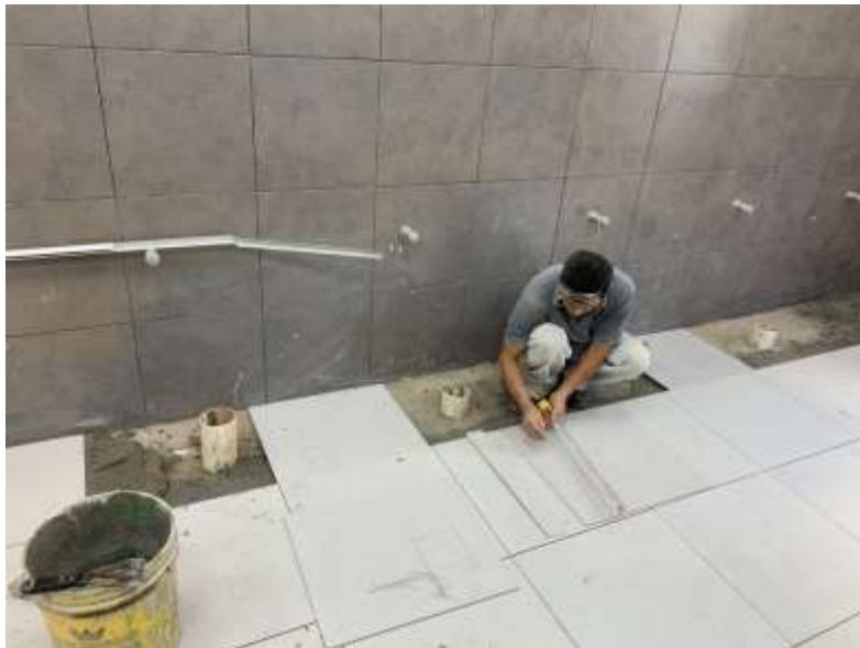
Ilustración 95 – Remodelación del piso del baño de hombres de Lear
