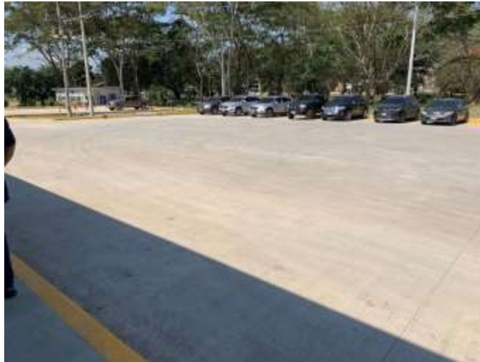
Ilustración 75 – Trocha de concreto a cortar para instalar tubería
