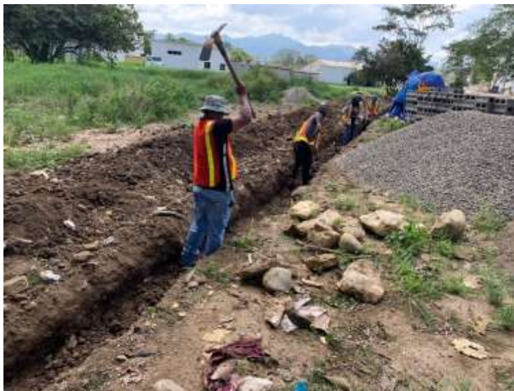
Ilustración 55 – Excavación para la fundición de la zapata corrida
