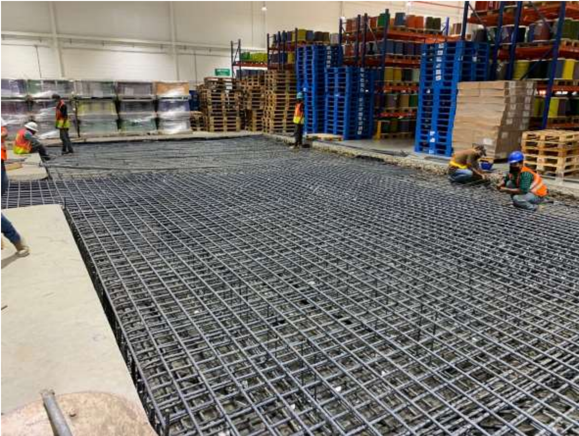
Ilustración 34 – Losa de COFICAB, armado final
