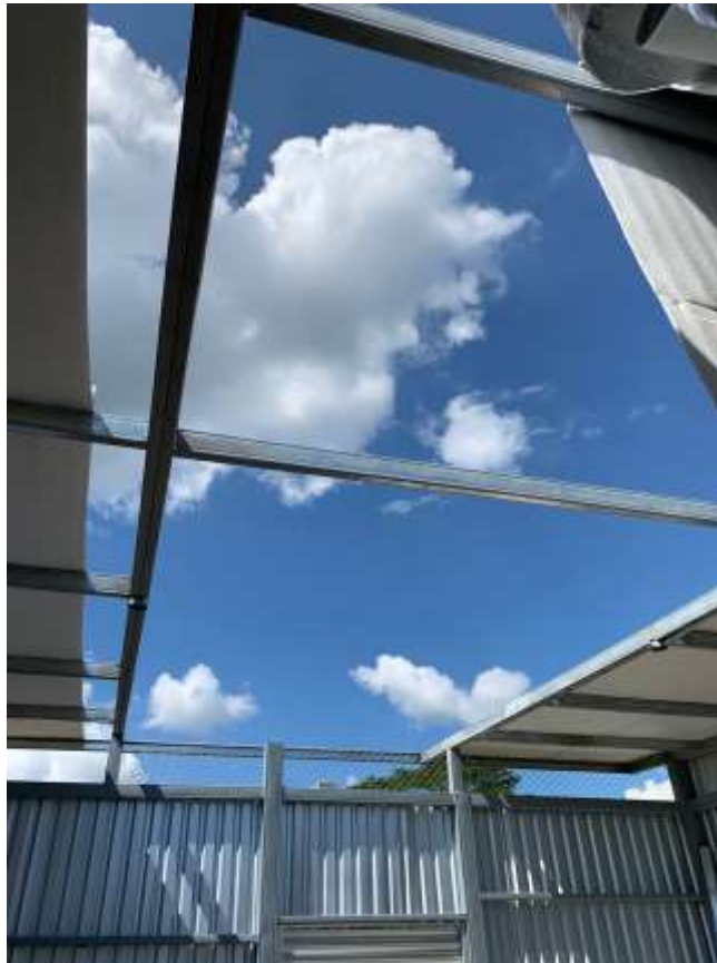
Ilustración 18 – Bodega de lámina metálica en la parte trasera de Lear
