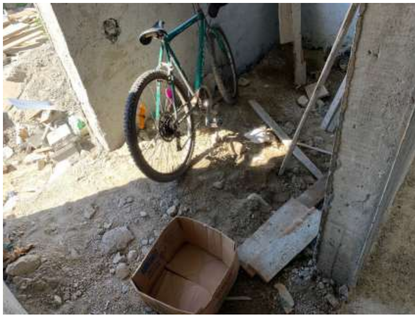
Ilustración 14 – Losa del cuarto de lavandería, proyecto en Jaraguá
