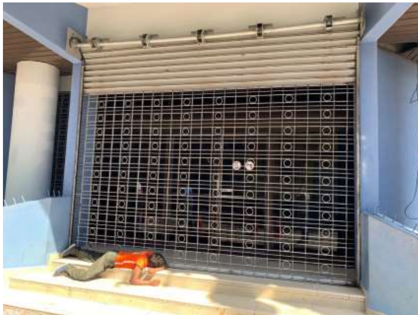
Ilustración 58 – Rejilla del BCH a darle mantenimiento
