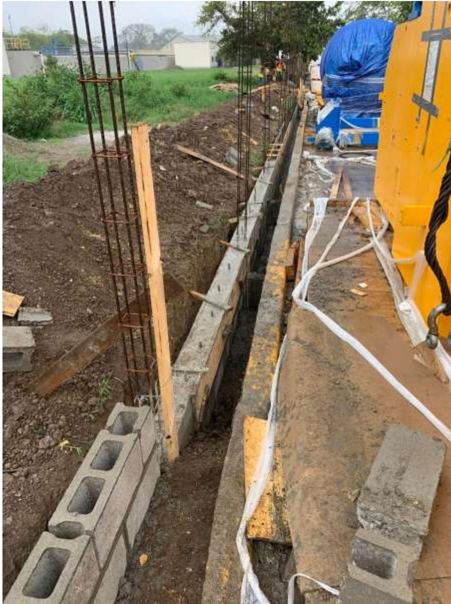
Ilustración 66 – Fundición de la solera inferior del muro de COFICAB
