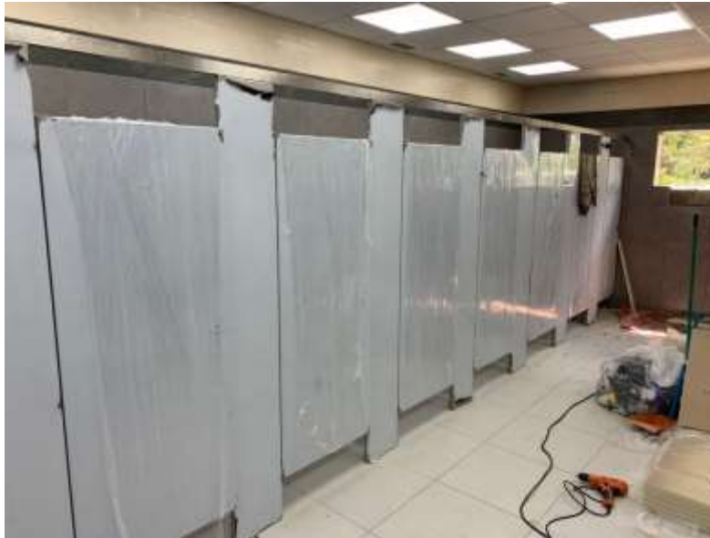
Ilustración 56 – Instalación de las mamparas en el baño de hombres
