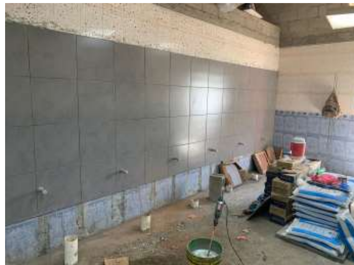
Ilustración 40 – Cerámica en pared derecha (baño de LEAR)
