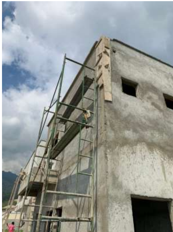
Ilustración 23 – Columna encofrada y fundida
