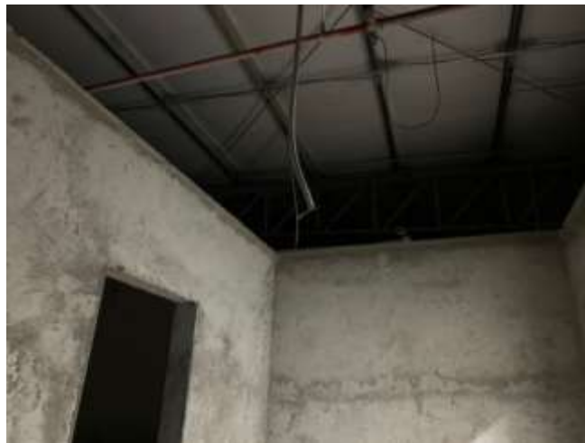
Ilustración 76 – Cuarto de enfriamiento a remodelar
