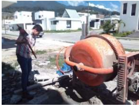
Ilustración 59 – Demolición del concreto alrededor de la mezcladora
