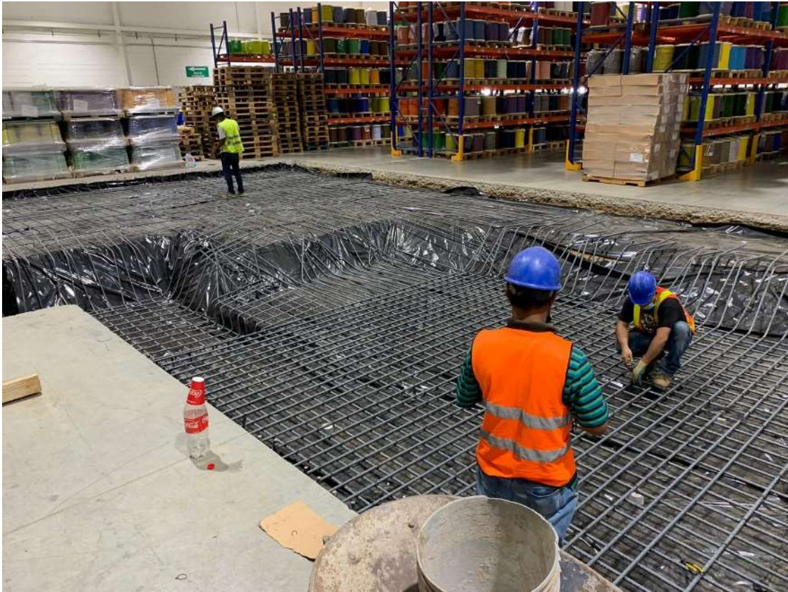
Ilustración 32 – Armado del hierro para la losa de COFICAB
