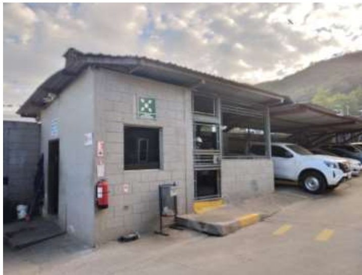
Ilustración 41 – Garita de seguridad a remodelar en CIGRAH
