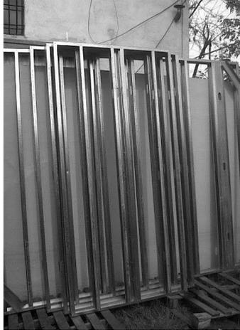
**Ilustración 23- Estructura para Steel framing.**
