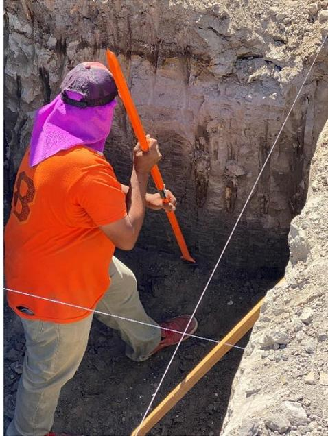
**Ilustración 40- Albañil utilizando una barra para darle perpendicularidad a la excavación de la zapata aislada.**
