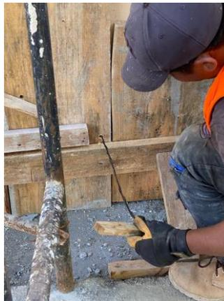
**Ilustración 18- Obrero muestra como insertar el bolillo en el encofrado de columna.**
