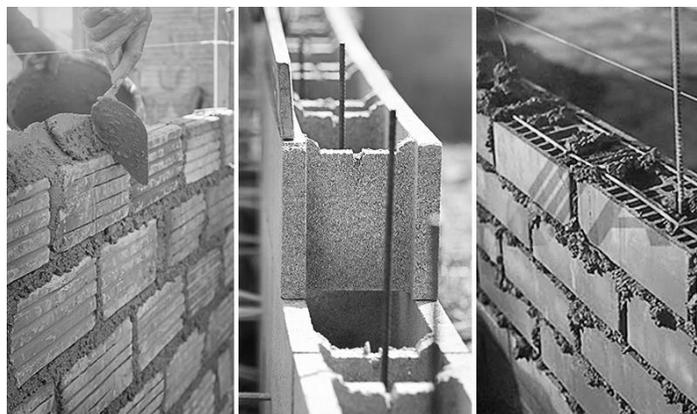
**Ilustración 10- Tipos de albañilería.**
