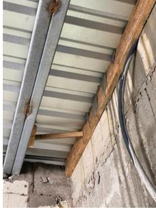
**Ilustración 16- Unión de la lámina de aluzinc con la viga solera intermedia.**
