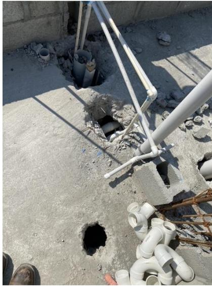
**Ilustración 37- Instalaciones hidrosanitarias atraviesan la losa de entrepiso.**
