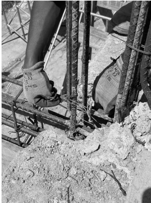
**Ilustración 27- Obrero realiza nudos con el alambre de amarre en la viga de cerramiento del voladizo.**
