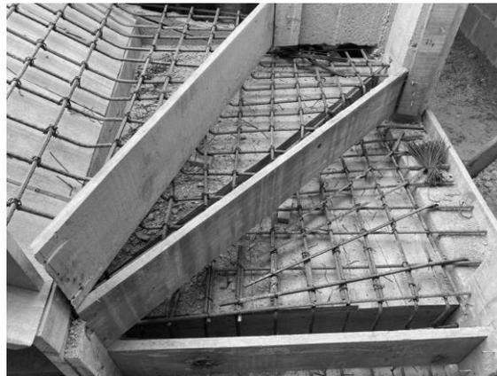
**Ilustración 25- Encofrado y refuerzo de acero para escaleras en acordeón.**
