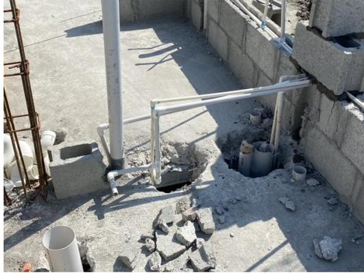
**Ilustración 38- Tubería para la instalación hidrosanitaria de PVC.**
