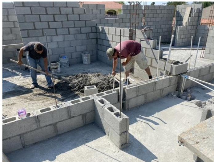
**Ilustración 34- Continuación del pegado de bloques en la segunda planta.**
