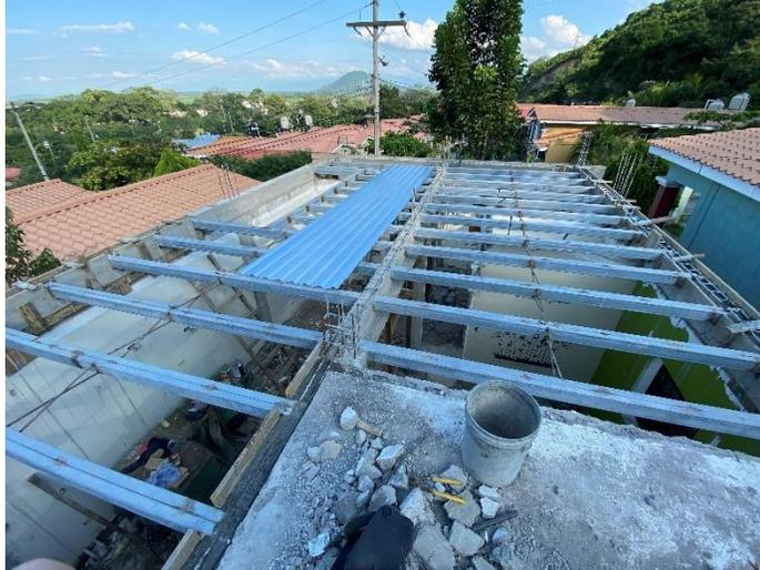
**Ilustración 44- Estructura metálica para la losa de entrepiso en vivienda familiar.**
