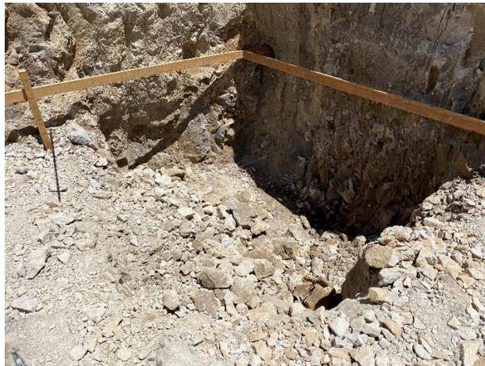
**Ilustración 41- Excavación de zapata aislada en suelo tipo laja.**
