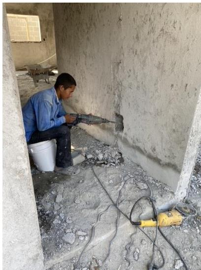
**Ilustración 36- Albañil realiza un pequeño boquete en la pared para las instalaciones eléctricas.**
