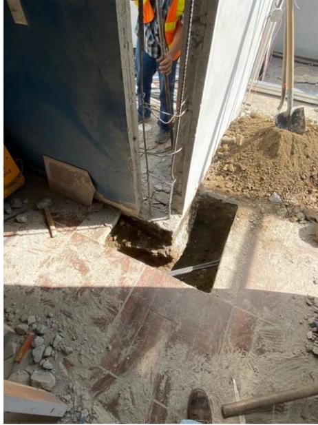
**Ilustración 15- Excavación de zapata para erigir columna K-2.**
