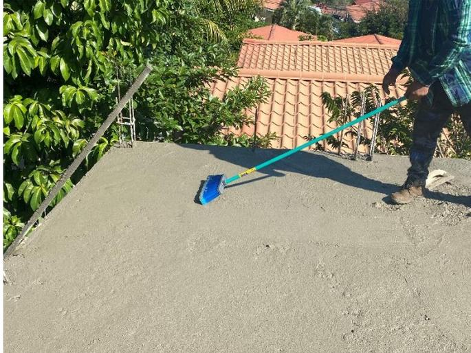
**Ilustración 42- Albañil utiliza una escoba para darle textura a la losa de concreto en entrepiso.**
