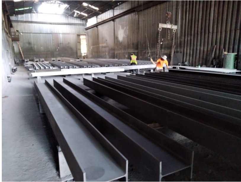
Figura 5: Se observa el área de pintura a cargo del supervisor Ing. Miguel Carranza donde se da el acabado final correspondiente de pintura necesaria dependiendo la estructura, forma de medición para las capas de pintura son en mils (milésima de pulgada 0.001”).
