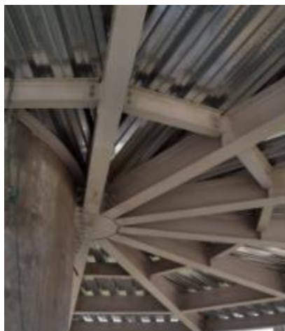
Figura 3: A continuación, se puede observar el soporte del entrepiso de uno de los pisos torre de control con el ensamblaje del mismo de con una buena calidad, en uno de los otros pisos se ve la ménsula con una pequeña inclinación, pero siempre cumpliendo su funcionalidad pero que no había manera de enderezarla con las vigas y placas así que lo mejor fue dejarlo con esa inclinación.
