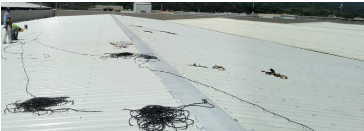
Figura 8: Aquí se ve una imagen general de como se ve el avance del techado de la nave industrial del proyecto de Caracolito, en Potrerillos, Cortés.
