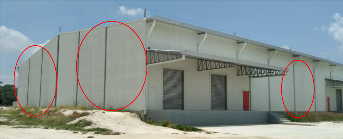
Figura 6: Aquí ya se ve de manera más general para identificar mejor las zonas donde las láminas tenían un distinto tono, por lo cual mejor se planifico una reunión con el proveedor de las láminas para saber que explicación tendría esto, ya que el cliente de este proyecto es bastante estricto por lo que no pueden quedar de esa forma.
