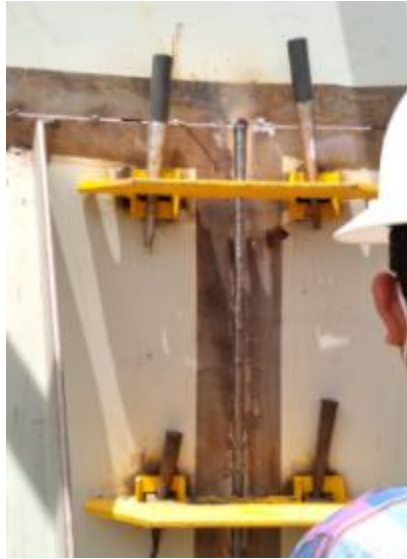
Figura 9: Aquí dentro del tanque siempre del proyecto de ELEC NOR con el aeropuerto de Palmerola con la OP-001-21, se logra observar una excelente calidad con respecto a la soldadura del cuerpo como esta unión en la cual no había ni necesidad de evaluarla de manera detallada y sin ningún tipo de profundidad.
