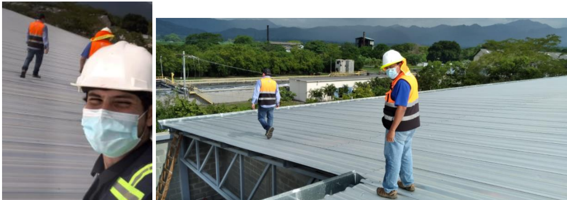
Figura 6: Aquí se puede observar imágenes cuando nos encontrábamos en el techo del proyecto de COFICAB en Green Valley para revisar las láminas que se logran ver en las fotos para verificar que el calibre era el correcto y que en efecto si era el calibre 26 y no el 28 que reviso un supervisor externo por parte del cliente.
