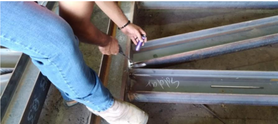
Figura 4: Aquí se puede ver como se deja señalado con una tiza identificando donde debe de haber reparaciones, soldar algunas partes específicas, limpiar, pulir, etc. Y en caso de que de que estén ocupados trabajando en otras cosas que tengan más prioridades nosotros mismos hacemos la debida limpieza con un foco para inspeccionar mejor las áreas oscuras y con un cincel limpiar la escoria de las soldaduras o cualquier salpicadura.
