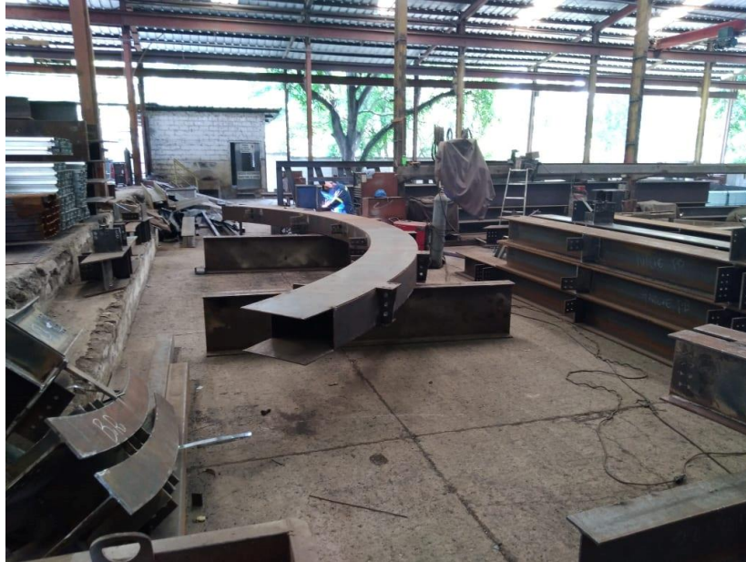
Figura 1: Aquí en esta imagen se observa una pieza estructura metálica en forma de arco curvado ya armado y soldado listo para ser revisado para luego ser enviado a su acabado final en pintura.
