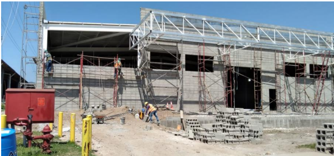
Figura 6: Aquí se ve una imagen general de como se ve el avance de la obra civil del proyecto de Caracolito, en Potrerillos, Cortés.
