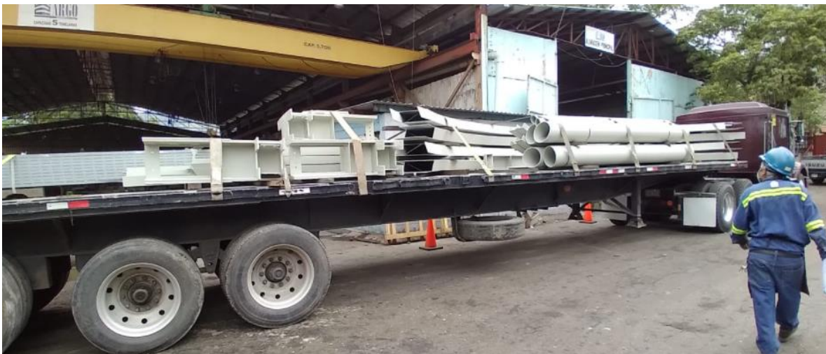
Figura 4: Aquí tenemos la siguiente imagen donde va la rastra al proyecto del aeropuerto de Palmerola, se puede ver que lleva estructuras metálicas, y en este proyecto la forma en como son enviadas a campo son para solo ensamblarlas y en caso necesario que se necesitó un refuerzo adicional hacen uso de la aplicación de una buena soldadura, estas piezas eran las que pasamos revisando desde la semana pasada hasta que tuvieran una buena calidad.
