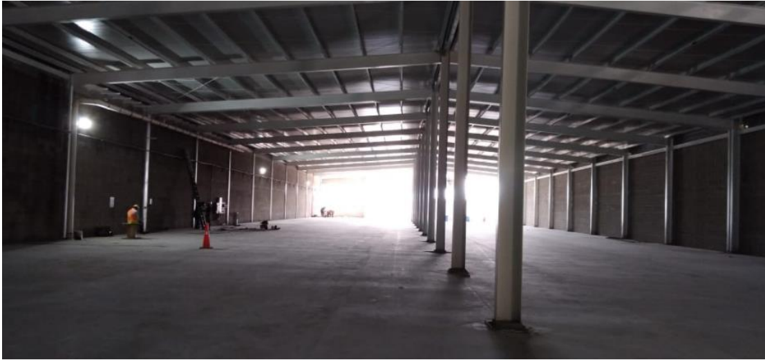
Figura 7: Aquí se ve una imagen general de como se ve el avance adentro de la nave industrial del proyecto de Caracolito, en Potrerillos, Cortés.
