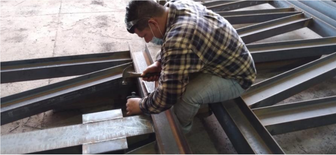
Figura 3: Aquí se logra apreciar a una de las personas del contratista Cristhian en el área de Perfilac limpiando cualquier detalle en un Joist de Carga que se vea de manera visible por ellos, o con ayuda nuestra para facilitar el aspecto de la limpieza.
