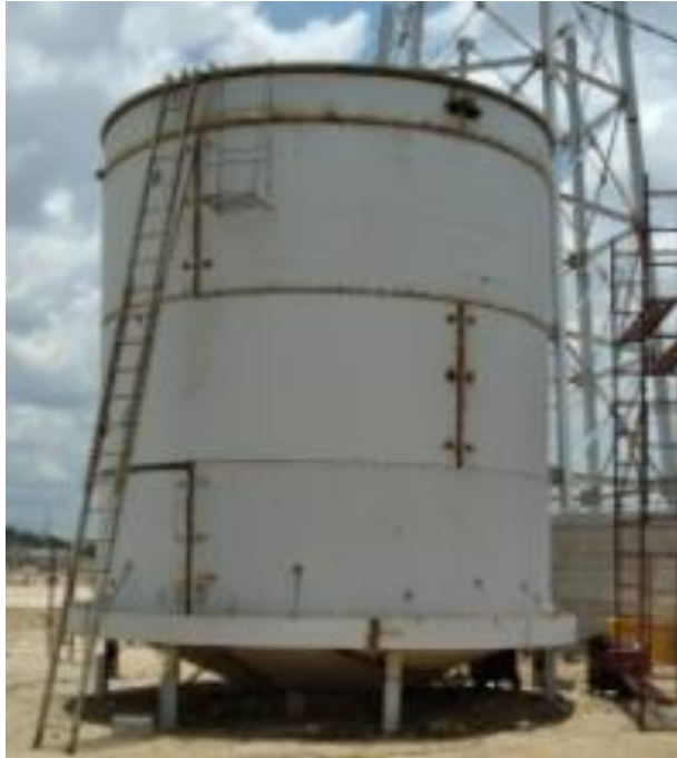
Figura 3: Aquí se logra apreciar el tanque de la segunda visita a campo que va en una torre a 16 metros de altura en la cual se hizo la revisión respectiva de las soldaduras en las uniones de todo el tanque, para saber si no había ninguna discontinuidad.
