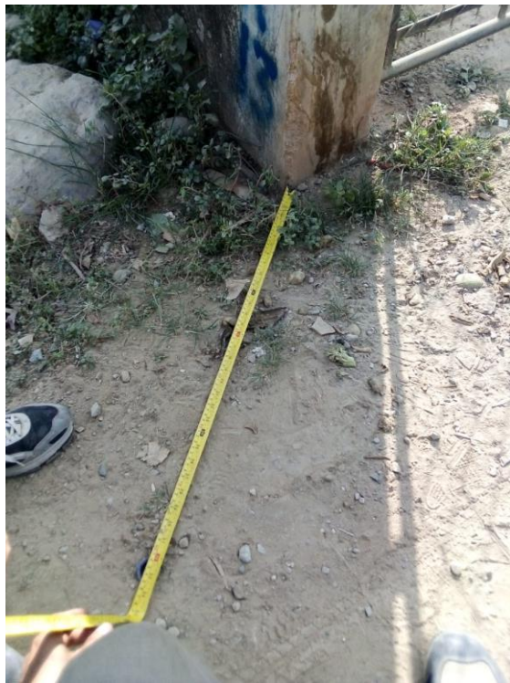
ANEXO 4. Banco de nivel 2 "R13" separado 83 cm de la columna del cerco
