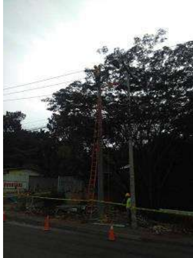
Ilustración 6 - Traslado de Postes.
