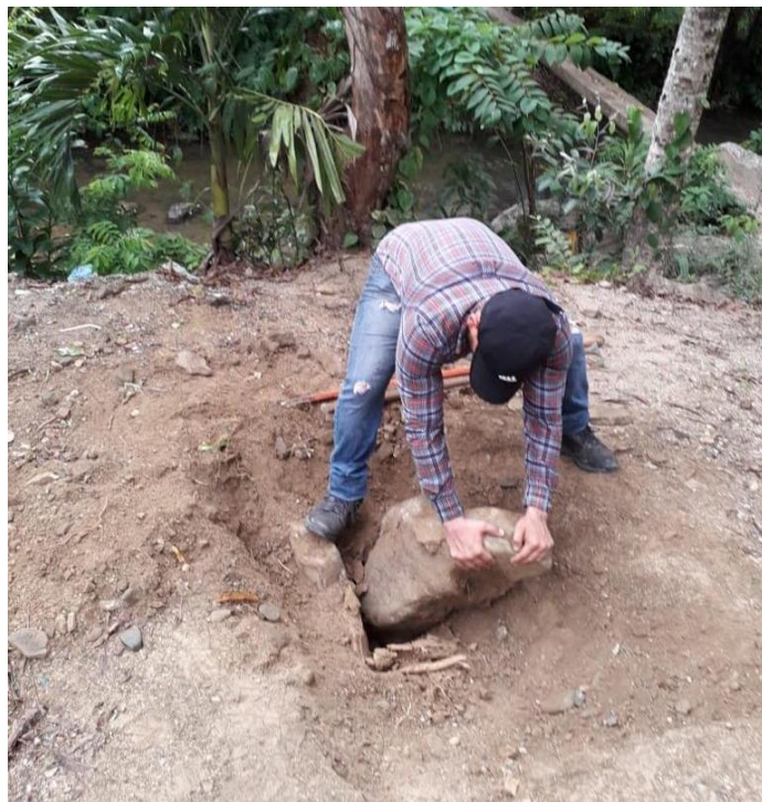
Ilustración 72 – Excavación de calicatas
