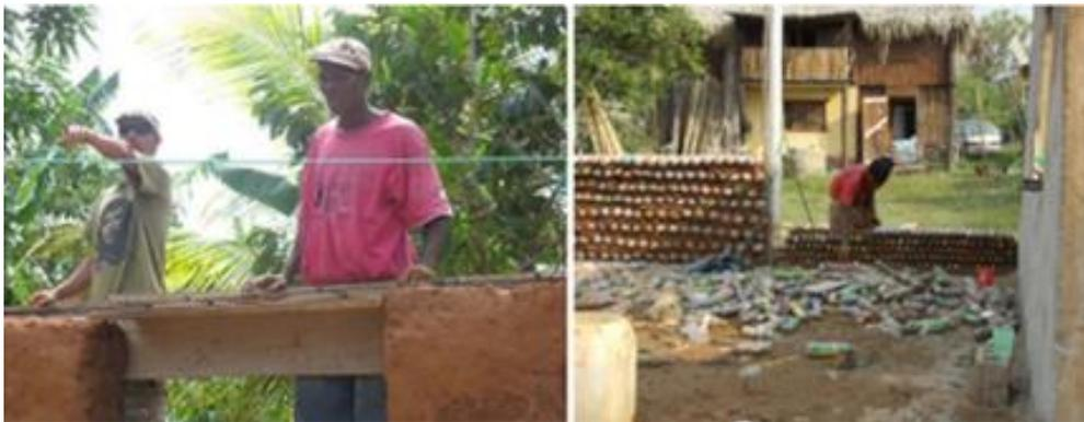
**Ilustración 17. Construcción de casa con plástico**
