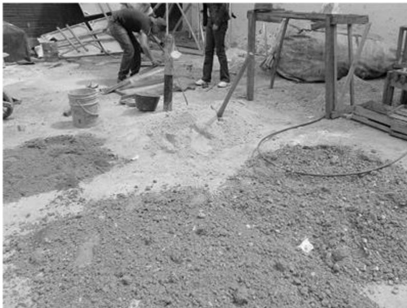
**Ilustración 8. Material de relleno que va dentro de las botellas**
