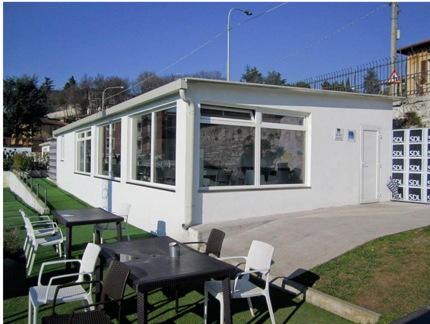
**Ilustración 2. Casa construida a base de ladrillos de plástico reciclado**
