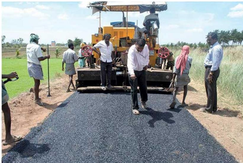
**Ilustración 12. Carretera en construcción con el uso de plástico reciclado**
