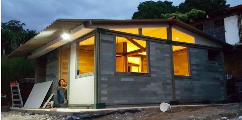
**Ilustración 5. Producto final de vivienda construida con ladrillos de PET**
