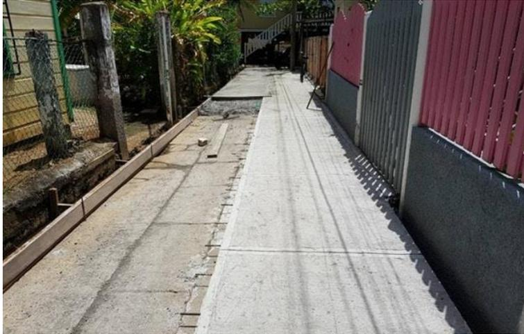
**Ilustración 15. Calle elaborada con la utilización de plástico reciclado**
