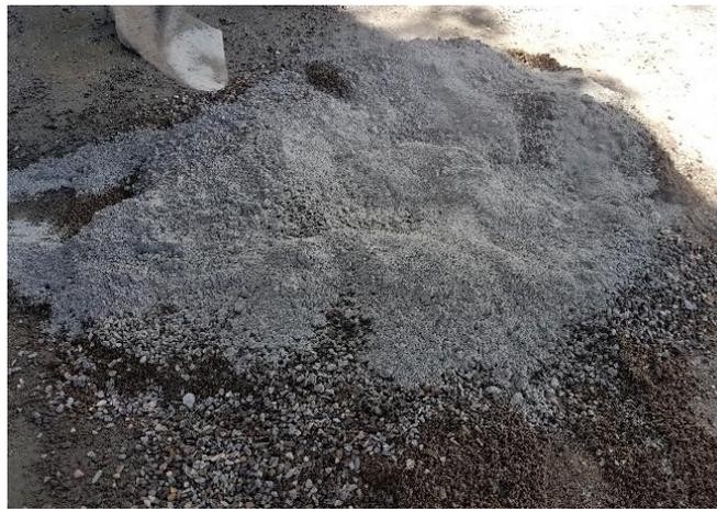
**Ilustración 61. Cemento junto a los agregados para la mezcla**
