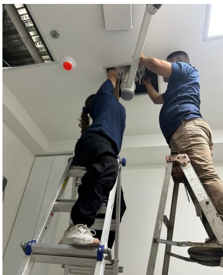
Ilustración 23: Instalación de lámpara quirúrgica
