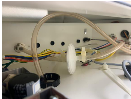
Ilustración 50: Reparación de fuga
