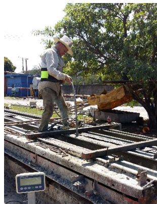
Figura 43. Vibrado de vigas control.
