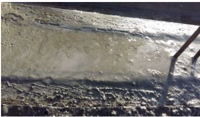
Figura 46. Curador aplicado sobre la viga.
