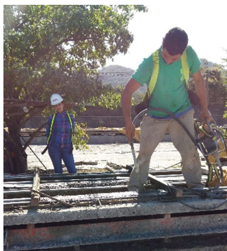
Figura 44. Vibrado de elementos.
