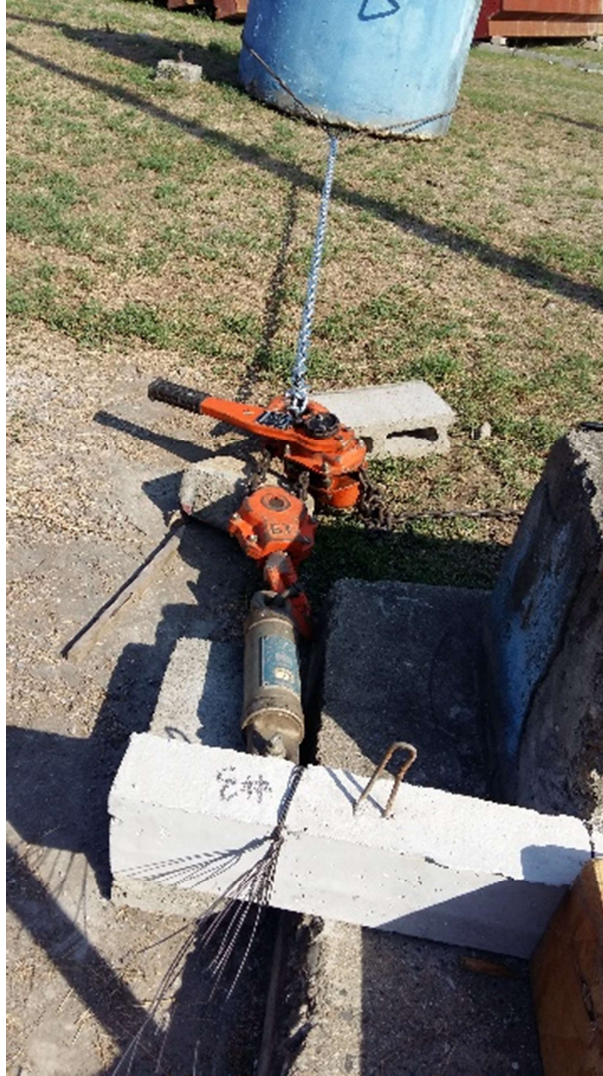
Figura 50. Montaje para ensayo de cortante.
