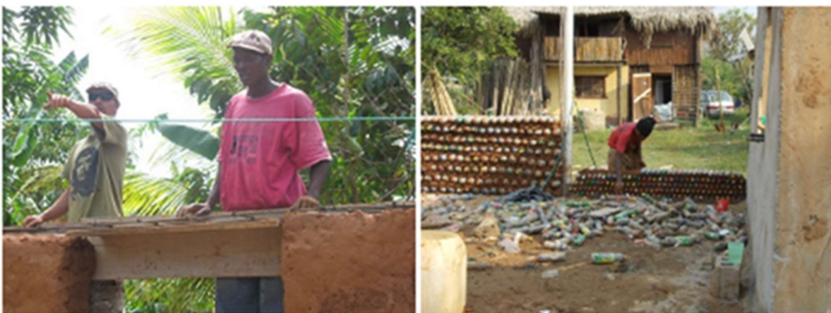
Figura 7. Proceso de construcción de casas.
