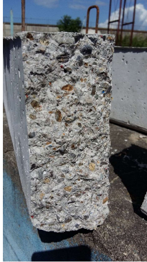
Figura 64. Falla de corte V1 20%, sección transversal
