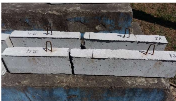
Figura 59. Vigas con 30% de plástico.
