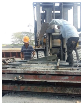
Figura 47. Proceso para sacar las vigas de la bancada.
