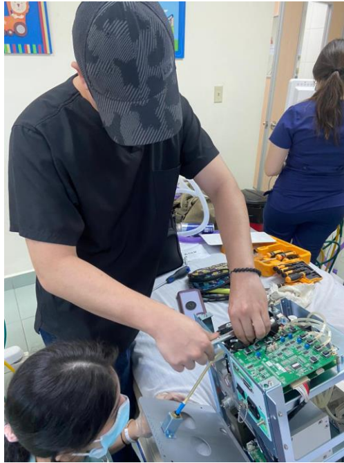
Ilustración 45: Mantenimiento Preventivo de VM MEKICS EVO 5
