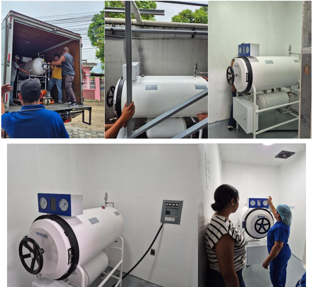
Ilustración 63 - Instalación y prueba de funcionamiento de autoclave
