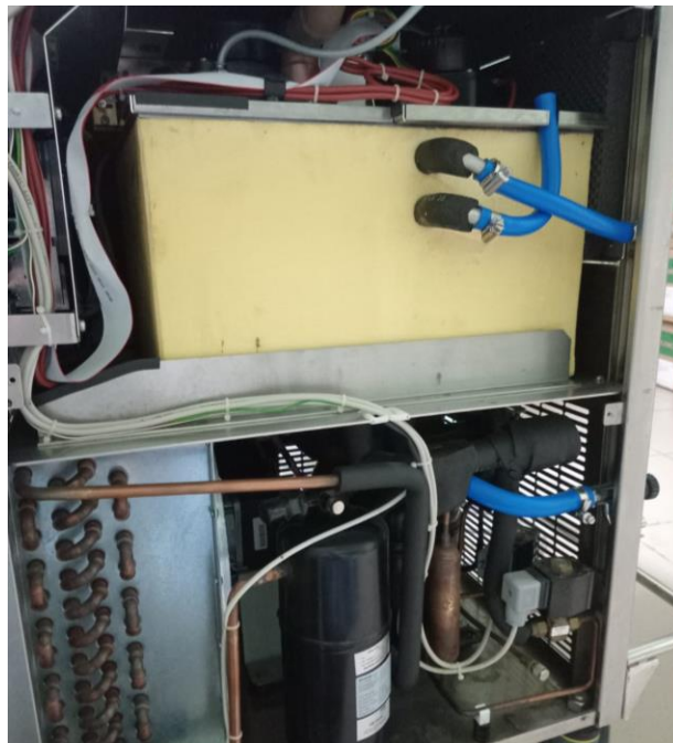
Ilustración 13: Inspección Interna de Intercambiador de Calor
